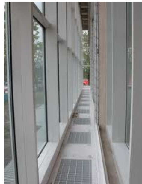
Fig. 5 Interior de la cámara entre las dos pieles de fachada en el Occidental Chemical Centre en las cataratas del Niágara. Fuente Internet
