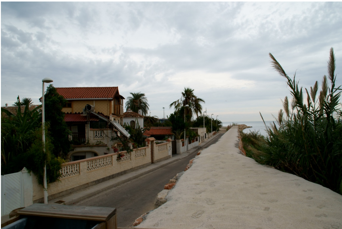
Imagen 4.5. Ocupación riberas y llanuras de inundación en el Serpis. Fotografía tomada el 30/10/12, 13:10.
