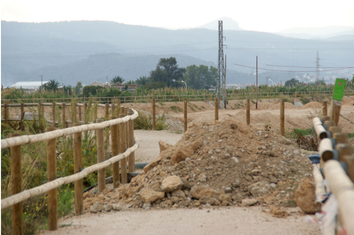
Imagen 4.4. construcción nueva promoción de V.P.O en la ribera del Serpis. Fotografía tomada el 30/10/12 a las 13.20.
