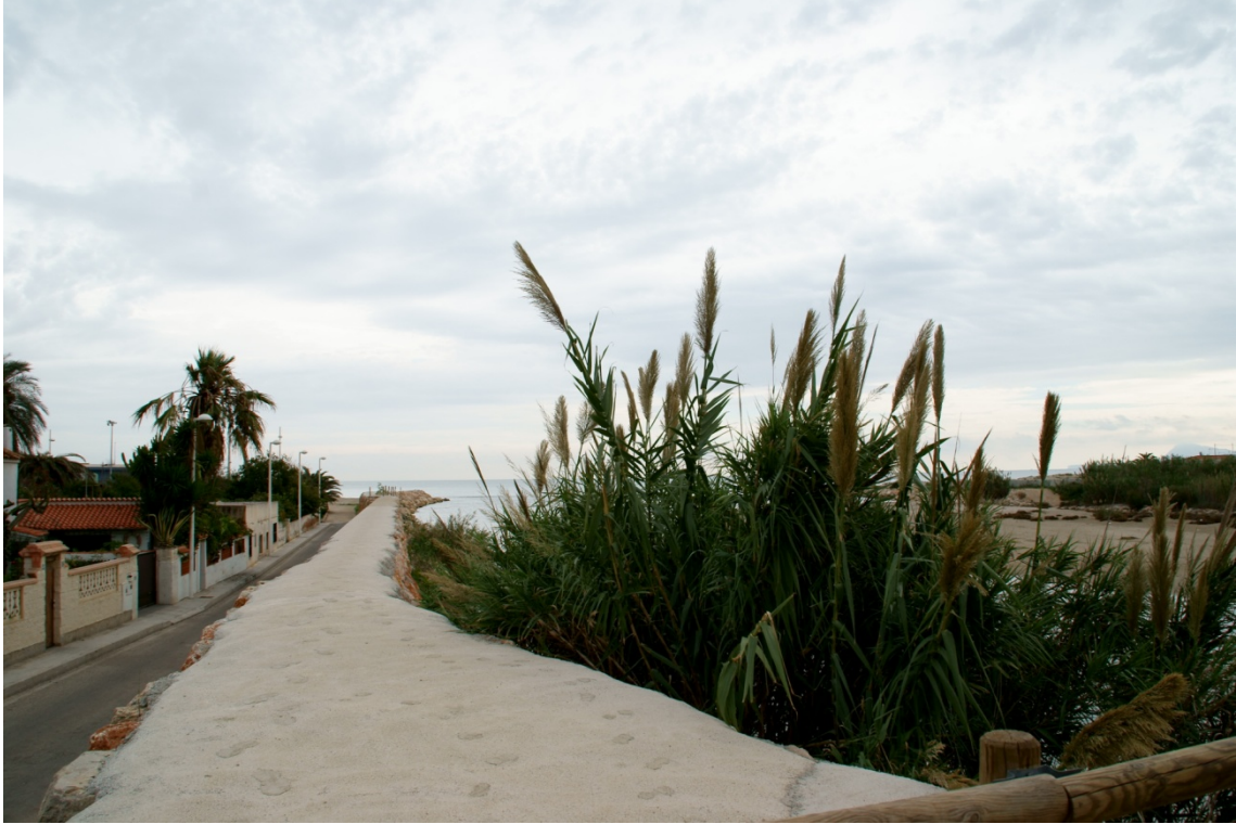
Imagen 5.5. Contacto del perímetro del cauce con infraestructuras. Fotografía tomada el 30/10/12.
