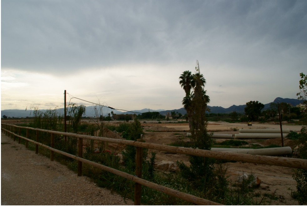
Imagen 4.3. construcción nueva promoción de V.P.O en la ribera del Serpis. Fotografía tomada el 30/10/12 a las 13.23.
