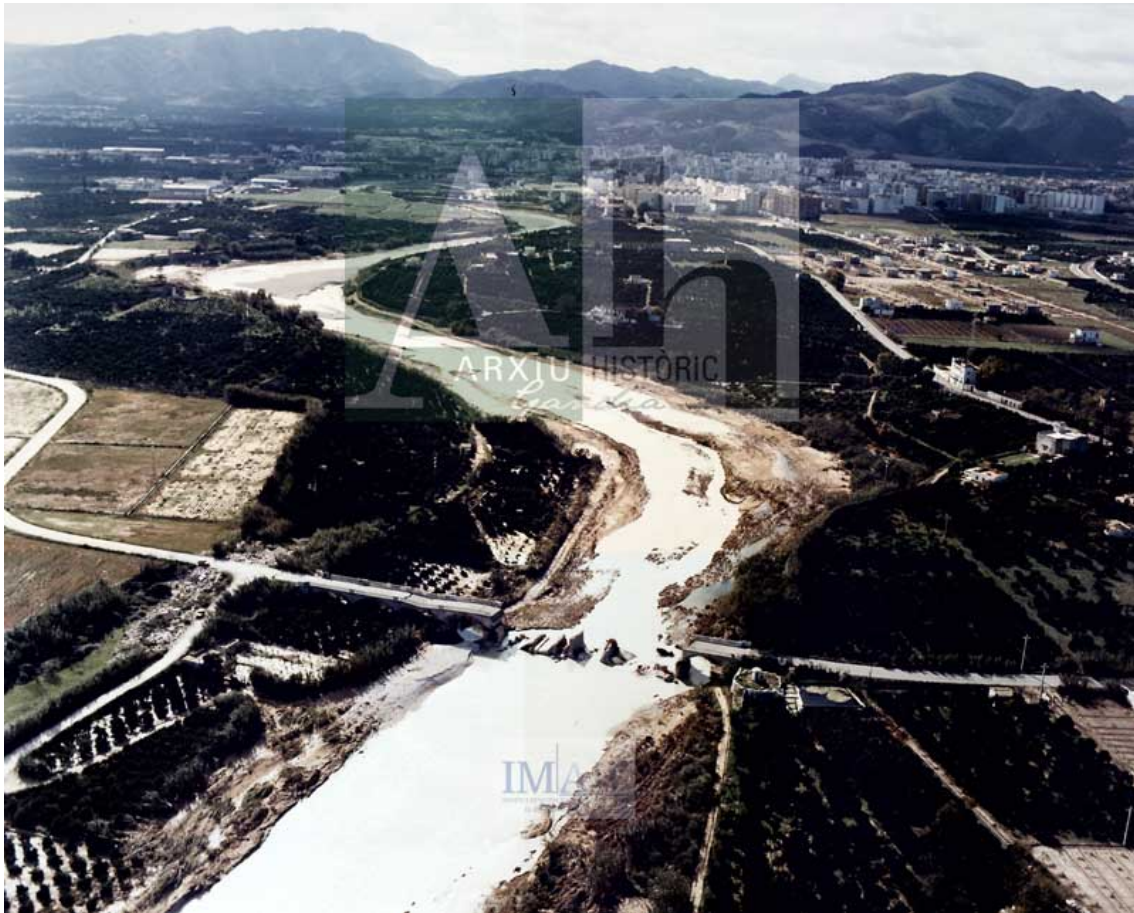
Imagen 5.4. puente de Daimús derruido tras la avenida de 1987. Paisajes de España (1987).
