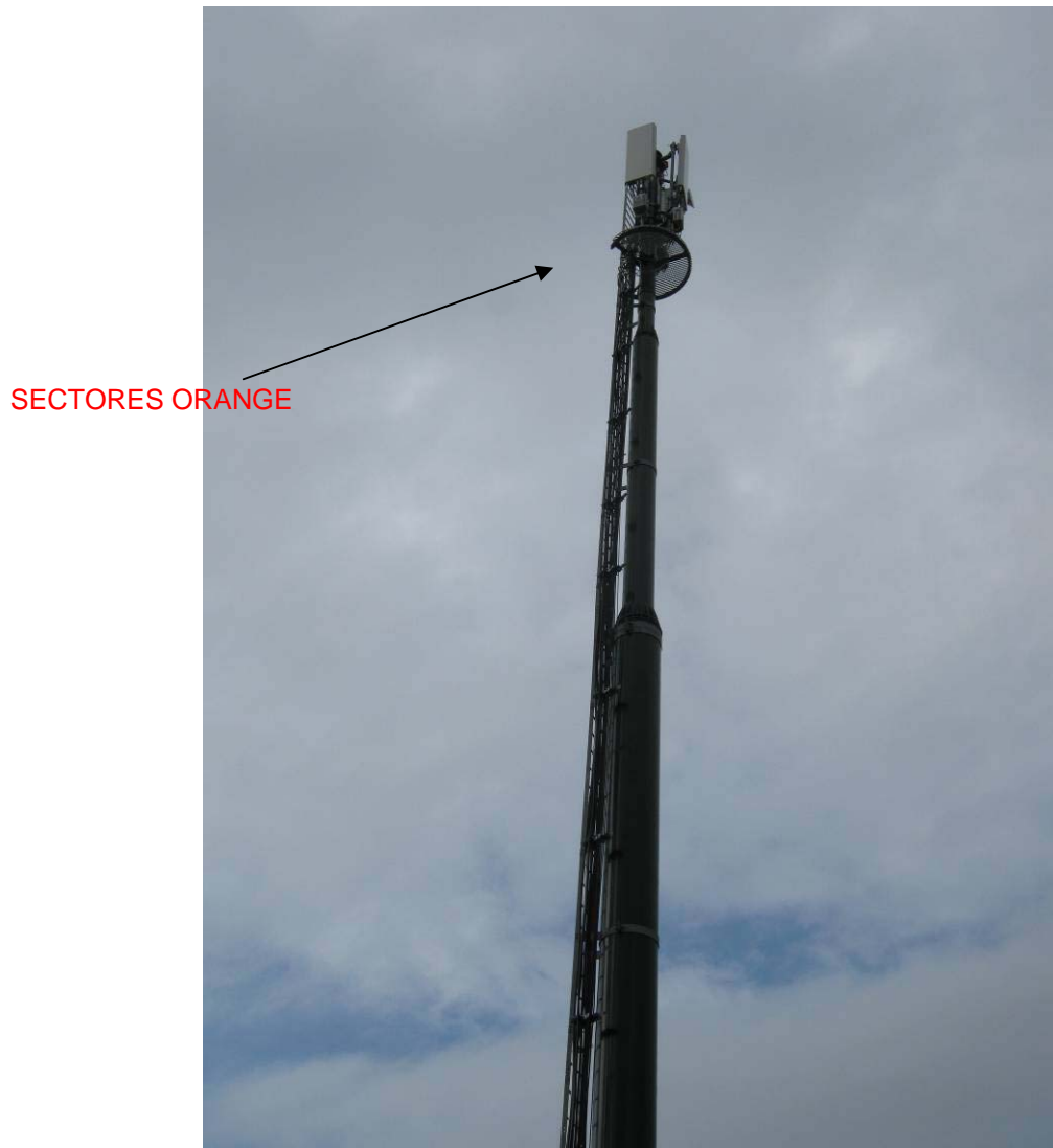
Foto 1: Vista general de la torre dónde se ubicará el sector ORANGE.
