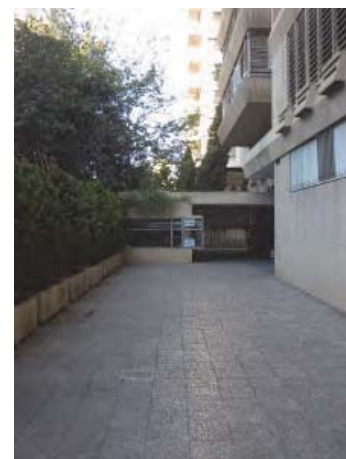
488 Vista de los bloques que conforman la edificación de Jaime Roig 25 desde la edificación de enfrente, El Bachiller 2.
