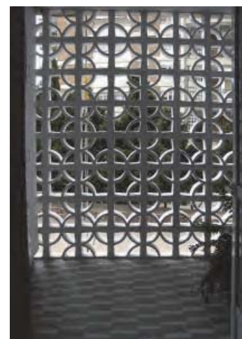
315 Álvaro de Bazán nº 5. Vista de celosía de piezas prefabricadas en galería de servicio en viviendas. Julio Trullenque y Pablo Navarro, 1963.
