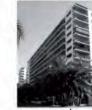
12. EDIFICIO UNIÓN LEVANTINA. 1968
