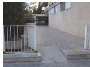
517 Jaime Roig nº 25. Rampa de acceso al aparcamiento subterráneo. Luis Marés, 1966.
