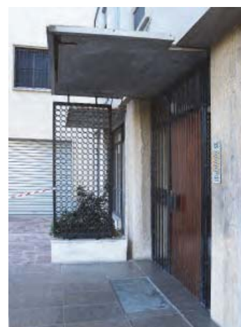
543 Detalles entradas laterales en la edificación Torre de Viveros, Joan Martorell-Botánico Cavanilles 8-10.
