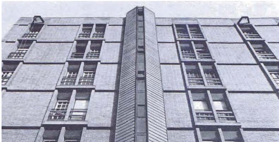
246 Casa de renta en la calle Muntaner, Solá Morales y Roselló.
