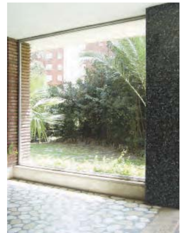
556 Botánico Cavanilles 14-16. Vista del porche exterior protegido por la carpintería de vidrio.
