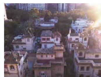
362 Vista de la fachada posterior de la edificación.
