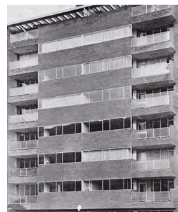
226 Viviendas en Madrid. Portal y fachada. J.M. Arangüena, 1963.
