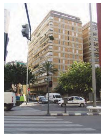
630 Vista de la edificación desde Prímado Reig.
