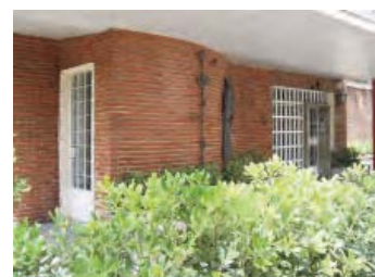
531 Detalle de la celosía de protección de la zona de aparcamiento en planta baja.
