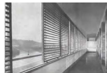
135 Persianas de hormigón premoldeado colocadas en un edificio de oficinas en Milán. Son de lamas accionables, y cada elemento se desplaza lateralmente, con lo que se consiguen unas máximas posibilidades de utilización.
