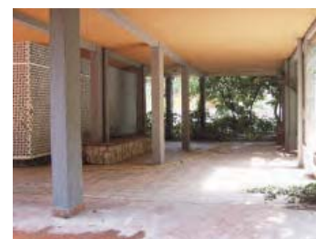
285 Álvaro de Bazán nº 8. Viviendas de portero en planta baja. GO.DB, 1962.
