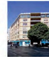
7. EDIFICIO SANTO TOMÁS DE VILLANUEVA. 1958-1960
