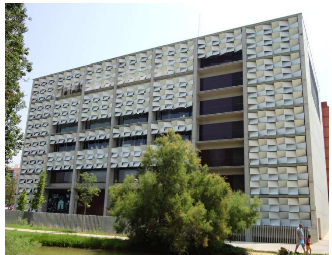
Figura 12. Fachada Oeste, parque de la Rambleta
