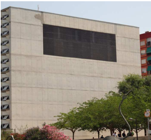
Figura 13. Fachada posterior, Sur
