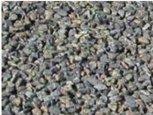
Imagen de un asfalto poroso
