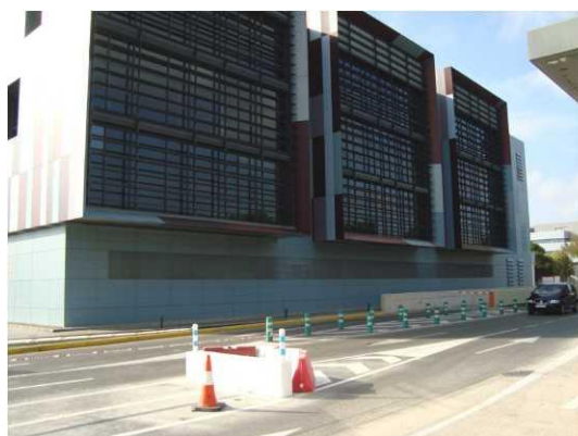
Despachos Ing. Edificación
