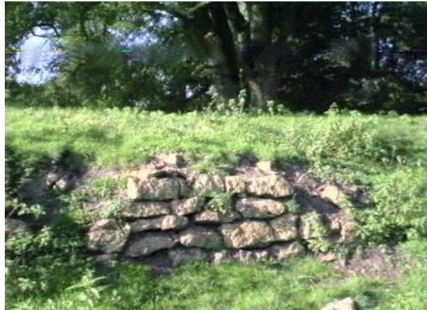
Restos del muro
