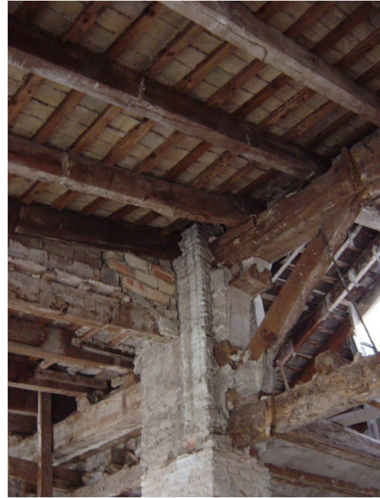
Encuentro de vigas de madera con pilar de ladrillo macizo.
