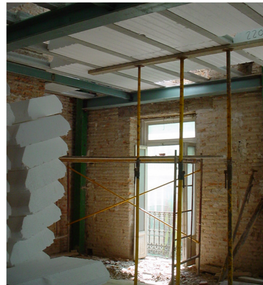
Colocación de bovedillas de poliestireno ext.
