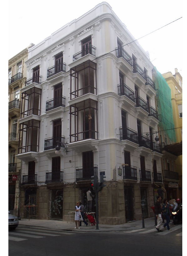
Colocación de la carpintería reparada
