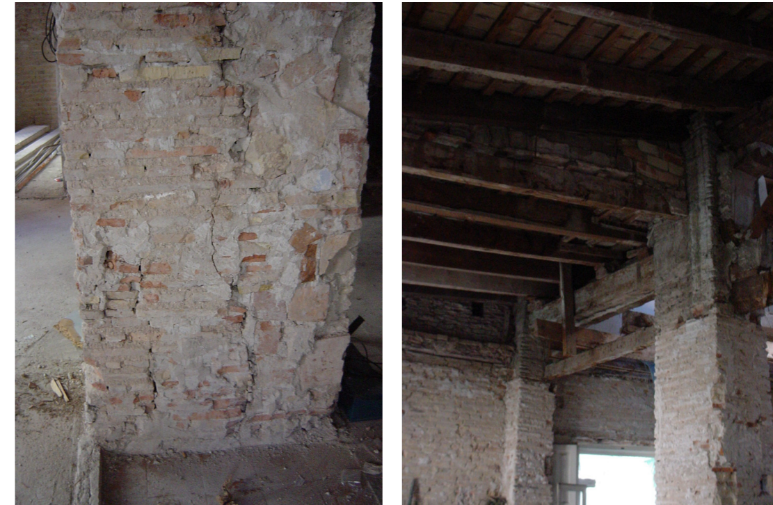
Pilares de ladrillo macizo
