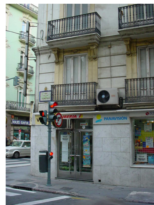
Acceso del local comercial C/ de las Comedias.
