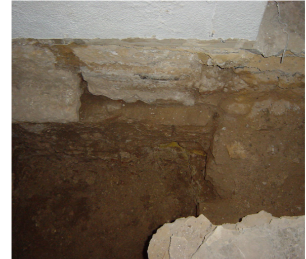
Cimentación continua bajo muro
