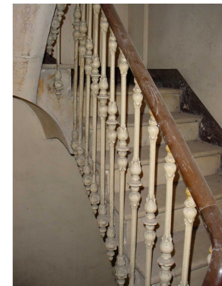
Escalera principal común.
