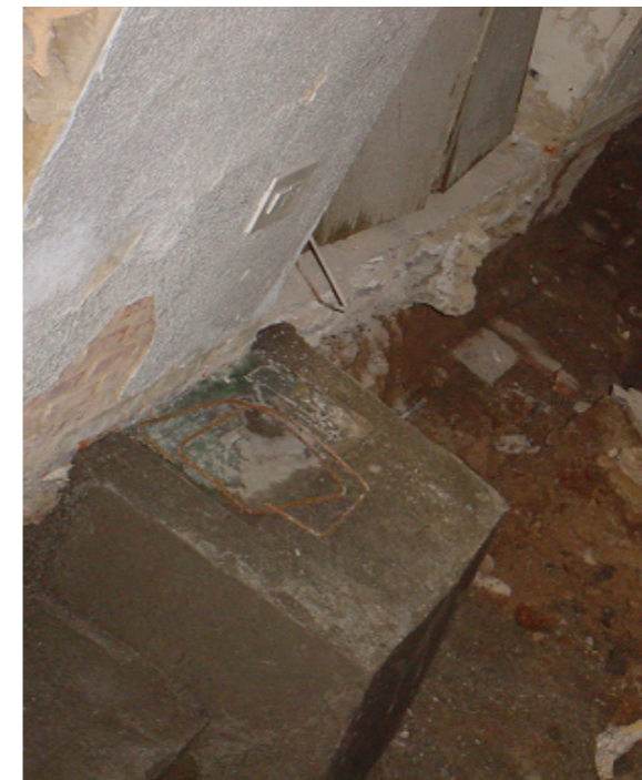
Excavación y ejecución de zapatas arriostradas con vigas de atado.
