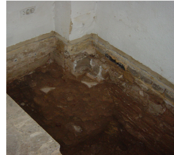
Cimentación escalonada bajo pilares
