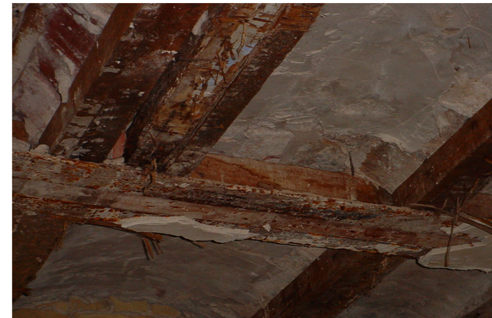
Forjado de viguetas y vigas de madera con entrevigado de rasillas, cascotes y mortero.
