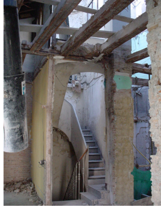
Núcleo de escalera del último tramo.
