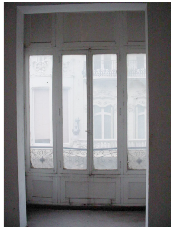
Mirador en fachada principal.
