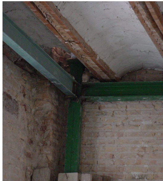
Colocación de estructura metálica
