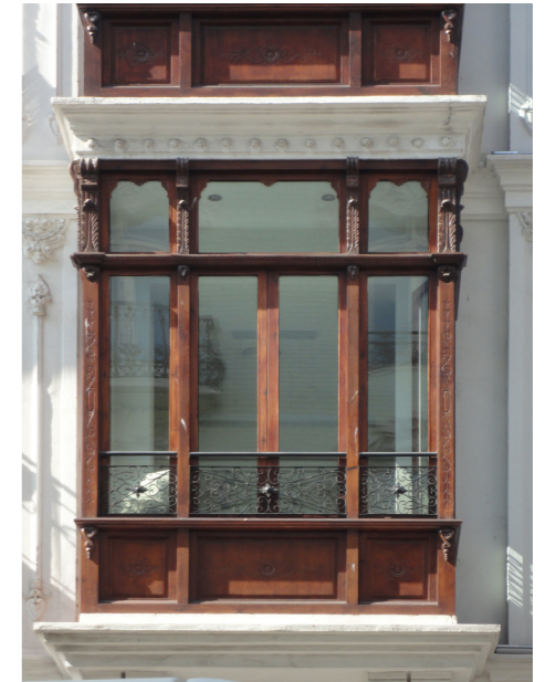
Mirador de la fachada principal
