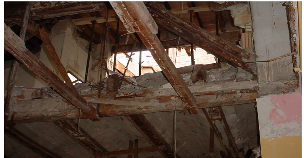
Estructura de cerchas de madera de la planta ático.
