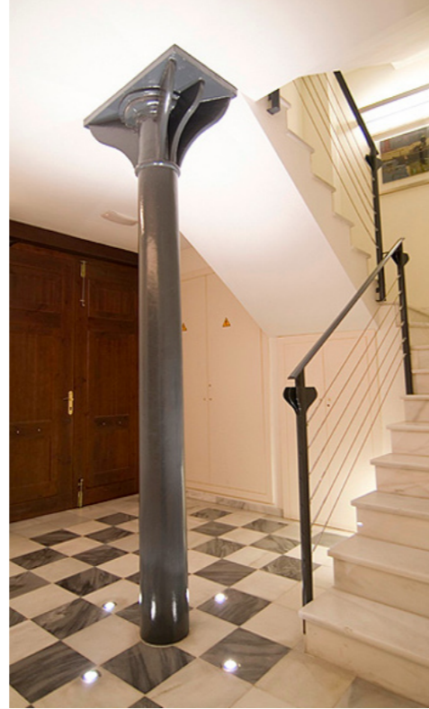
Pilar de fundición recuperado y con diferente ubicación tras la reforma.
