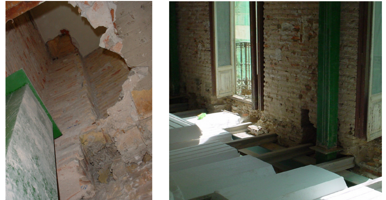
Imágenes de pilares metálicos de la estructura portante
