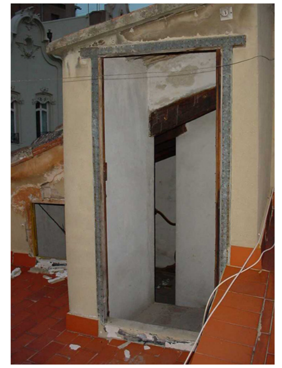
Acceso a la azotea.
