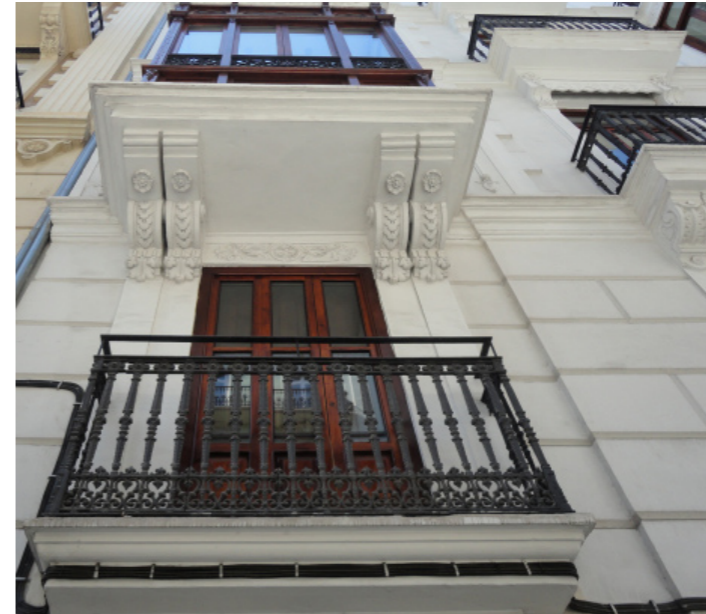
Balcón y mirador de la fachada C/ de la Paz
