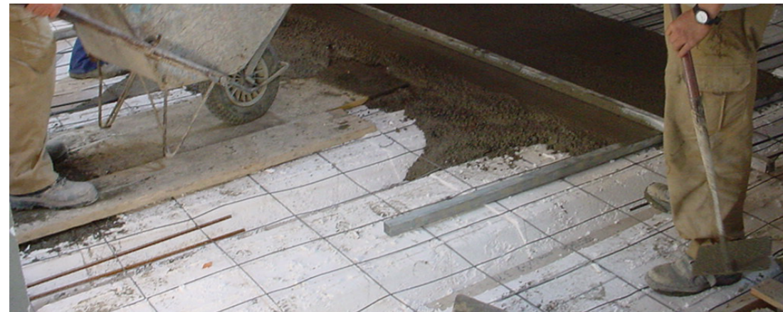
Hormigonado del forjado unidireccional
