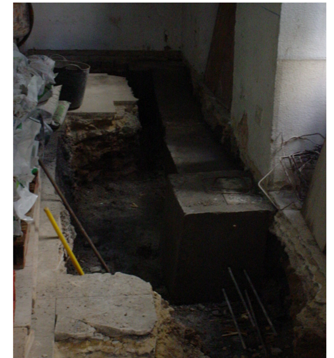
Excavación y ejecución de zapatas arriostradas con vigas de atado.
