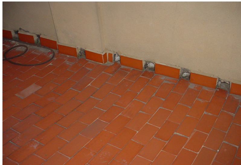
Imagen de aberturas en el antepecho para el desagüe de la azotea.
