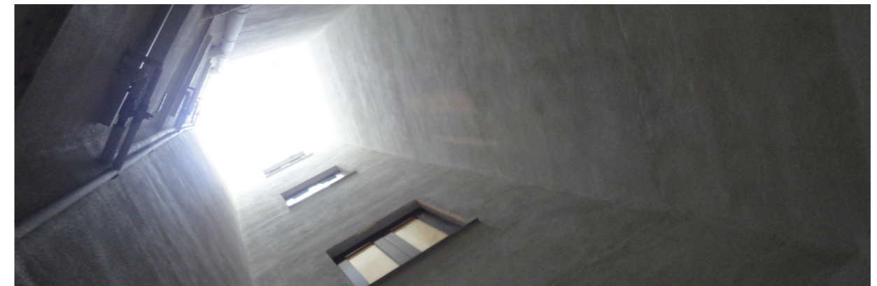
Patio interior del edificio
