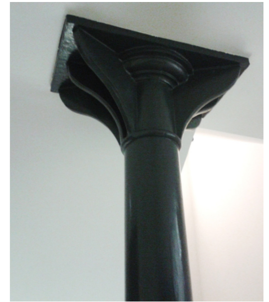
Pilar de fundición
