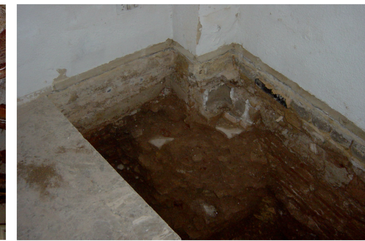
Cimentación escalonada (zampado)
