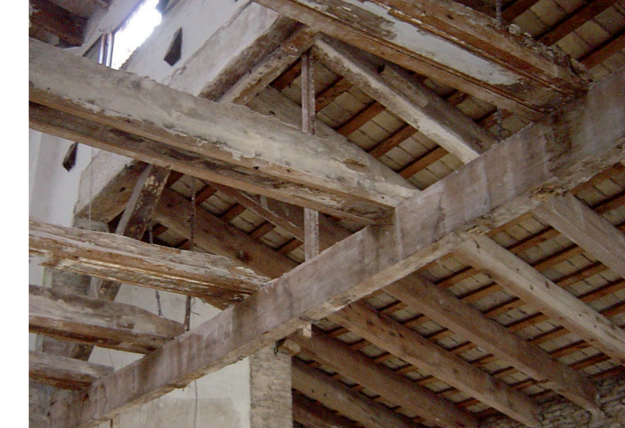
Estructura de cerchas de madera de la planta alíco
