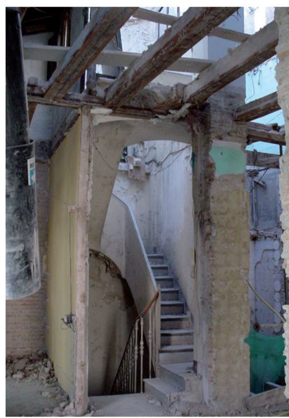
Núcleo de escalera del último tramo
