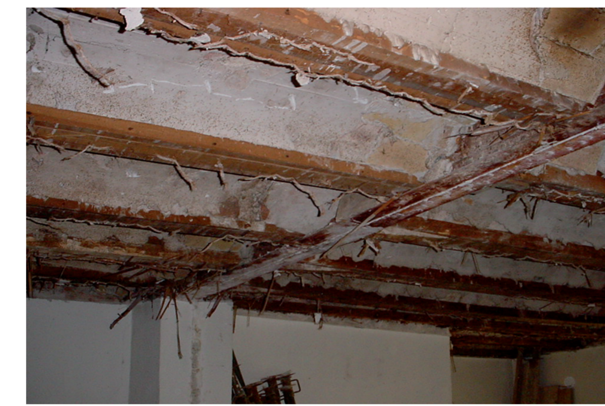
Forjado unidireccional de viguetas de madera con revocón cerámico
