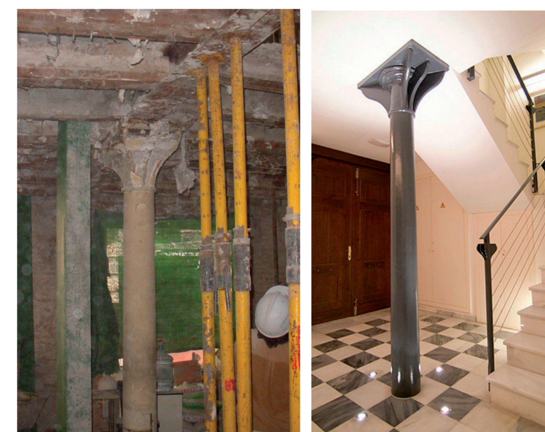
Pilar de fundición recuperado y con diferente ubicación tras la reforma.
