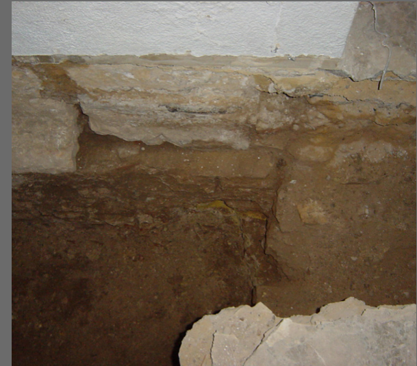
Cimentación corrida bajo muro de carga
