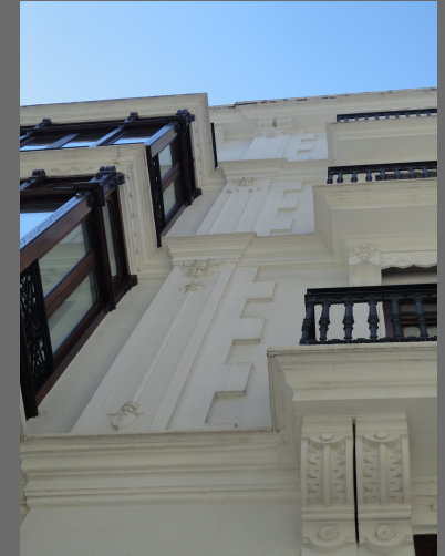
Ornamentación en la fachada principal
