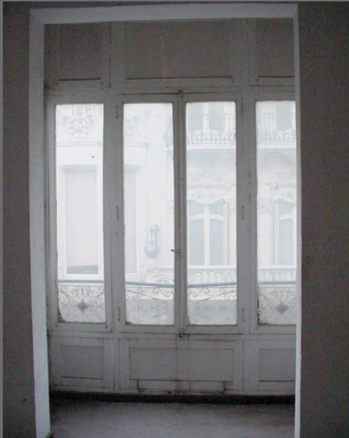
Mirador en fachada principal
