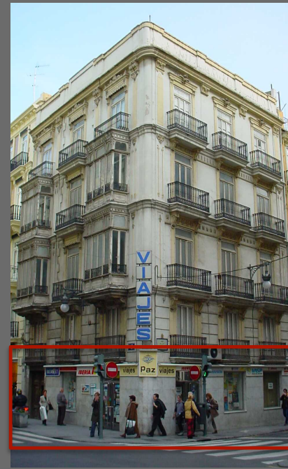
Estado antes de la rehabilitación
