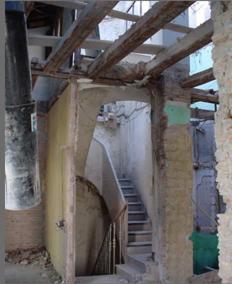
Núcleo de escalera del último tramo
