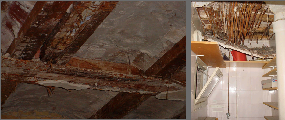
Forjado de viguetas y vigas de madera con entrevigado de rasillas, cascotes y mortero.
