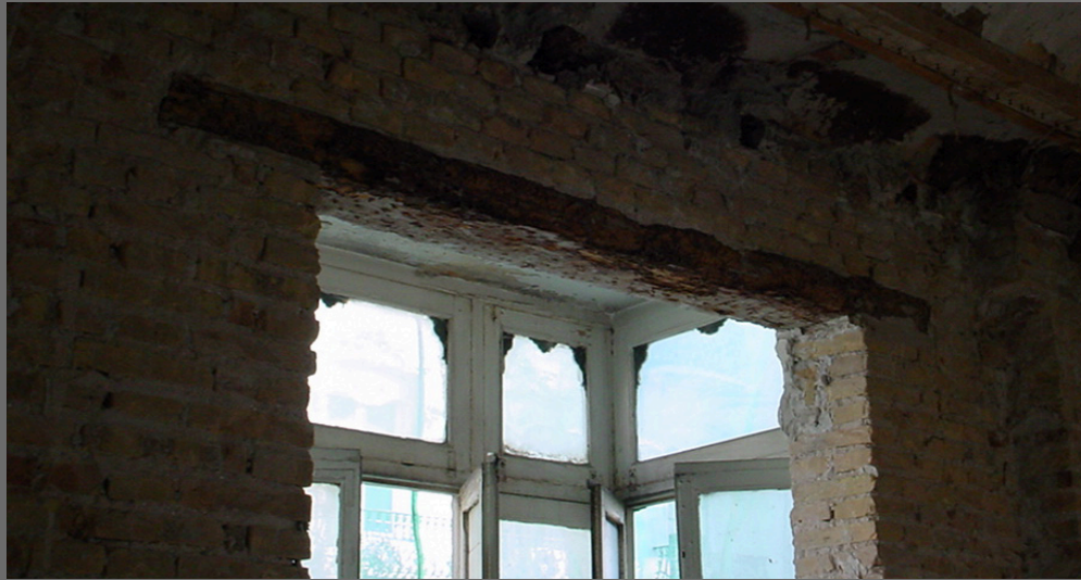
Hueco del mirador con dintel de madera y fachada de fábrica de ladrillo macizo de 1ª
