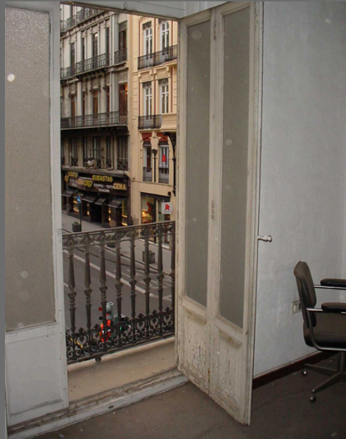
Balcón en fachada C/ Comedias
