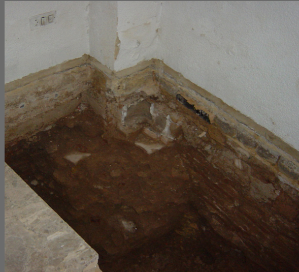
Cimentación escalonada (zampeado)
