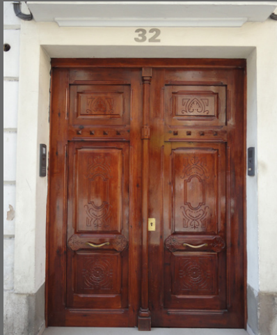
Acceso al edificio
