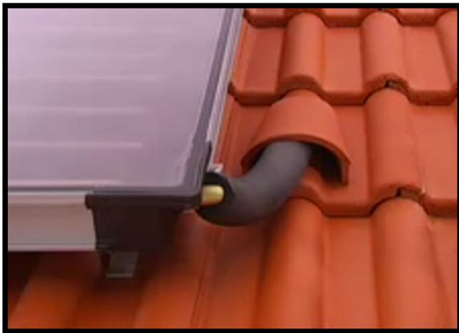
Fig.34 – Teja de ventilación
