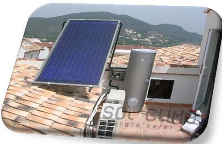
Fig.26 – Placa solar térmica sobre cubierta inclinada de teja curva junto a una cubierta plana transitable.
