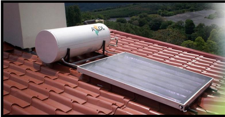
Fig.24 – Placa solar térmica sobre cubierta inclinada
