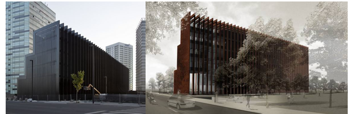
Edificio de la Sede Layetana en Barcelona_RCR
