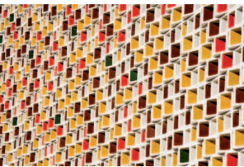
CEIP El Martinet, 2005, Mestura arquitectos.
