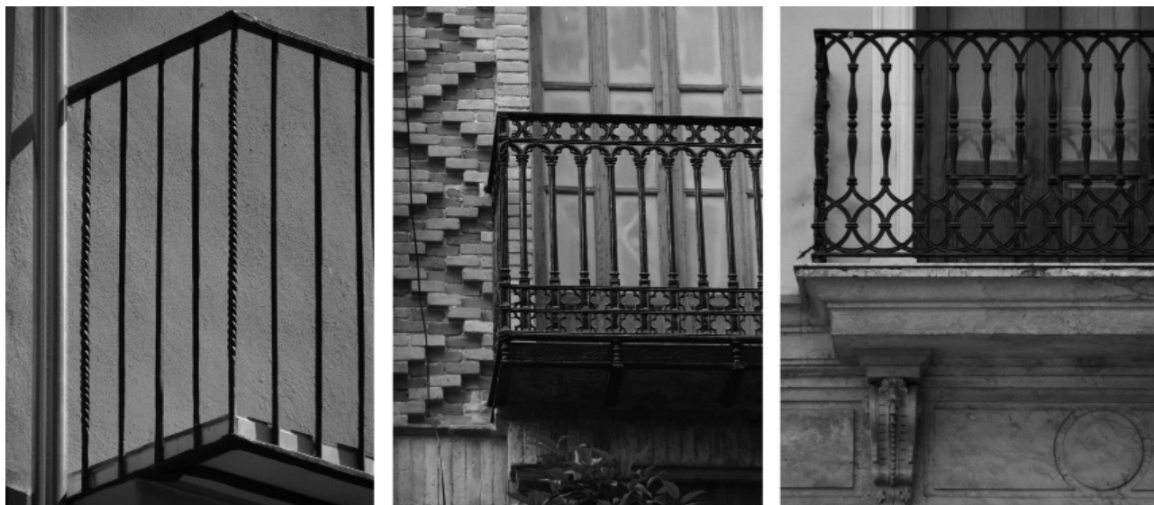
Figura 7. Las tres familias de balcones valencianos: a) Jaula, b) Jaula Partida, c) Baranda y Solera
