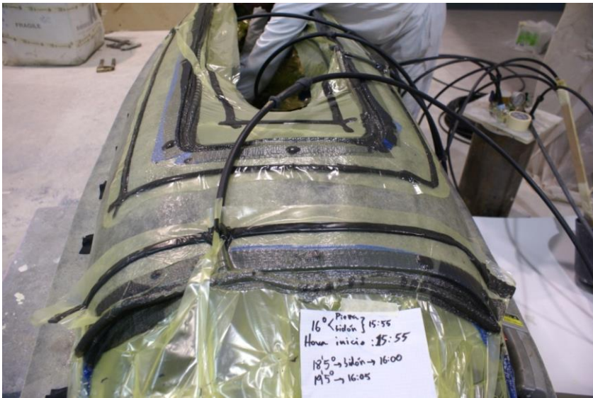
Figura 6-23 Vista general del molde mientras se realiza la infusión.
