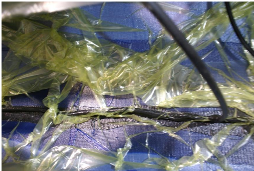
Figura 6-20 Frente de avance de la resina.
