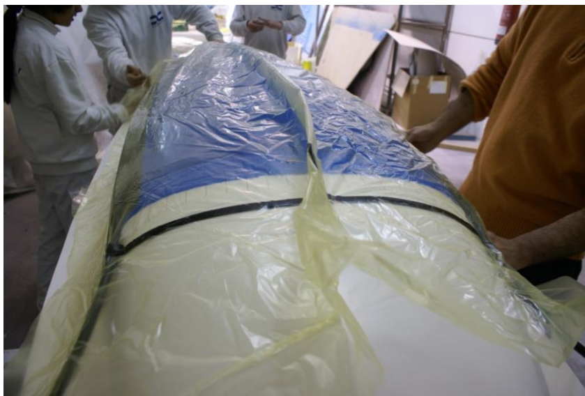
Figura 6-16 Colocación del film.
