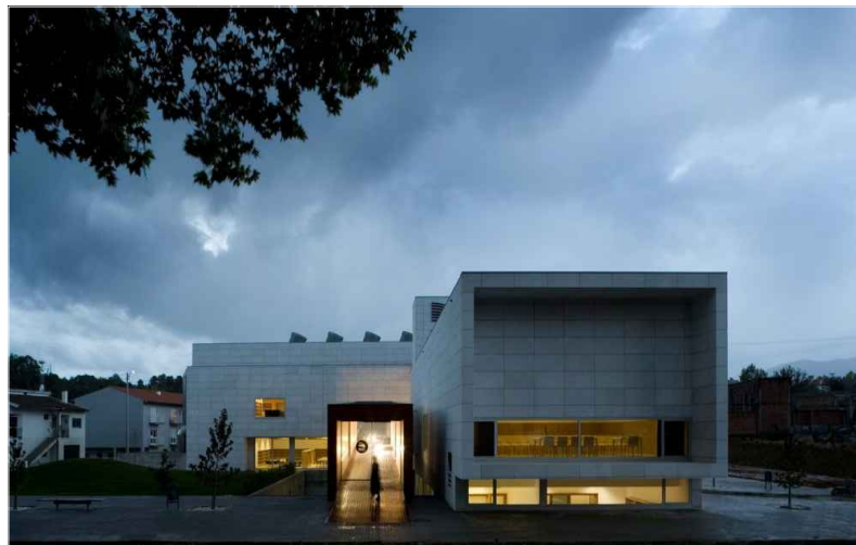
Biblioteca Municipal Dr Júlio Teixeira / Belém Lima Arquitectos
