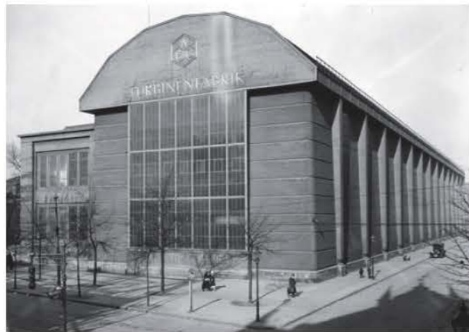
[Turbinas AEG Gropius]
