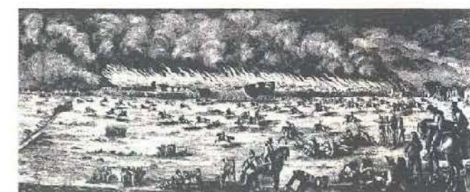
Plata del incendio causado en las Barracas del Cabanyal de la playa de Palanós en el día 21 de Febrero de este año de 1796, que con el viento de C.N. y quedó conizas 86.
