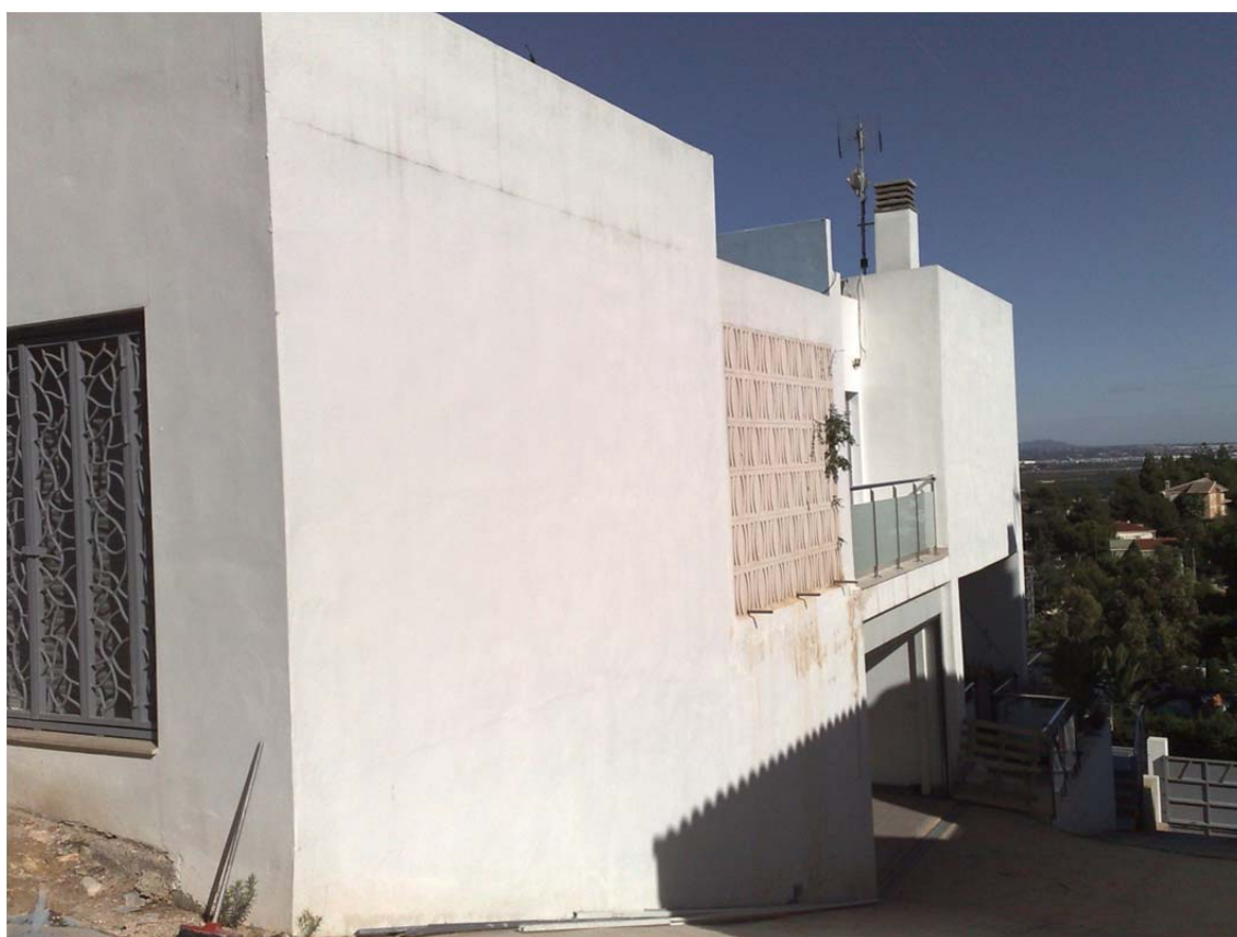
Fig. 5: Imagen de la fachada Sur-este.
