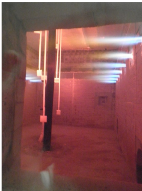
Figura 4.32. Imagen tomada a través de una de las ventanas de inspección del horno horizontal durante el ensayo donde se aprecian los quemadores activos
