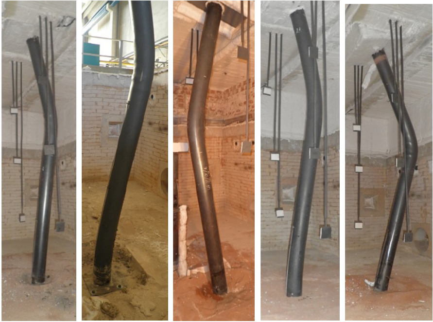
Figura 4.33. Aspecto de diferentes pilares CFT tras el ensayo
