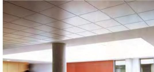
3.- Zonas comunes donde es necesario un falso techo registrable, se escoge un falso techo metálico formado por lamina de aluminio prelavado de ancho 200 ó 300 insertadas en pestañas de rastreles de paso troquelado 200 ( ARAN VZ 200) ó 100 (ARAN VZ 300) y colgadas del forjado superior mediante un sistema de varillas roscadas.
