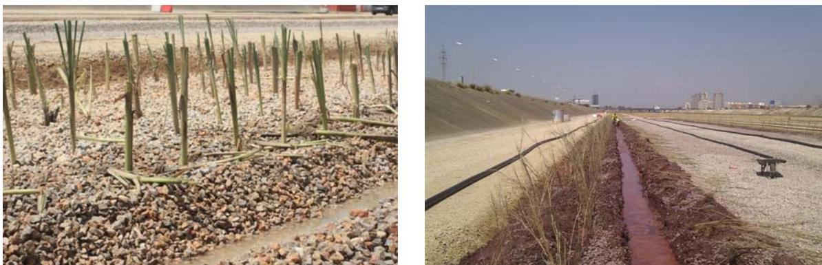
Figura 17. A la izquierda plantación de enea (*Typha latifolia*) en la celda 1. A la derecha plantación de carrizo (*Phragmites Australis*) en la Celda 9. Fuente: Acuamed, 2012.
