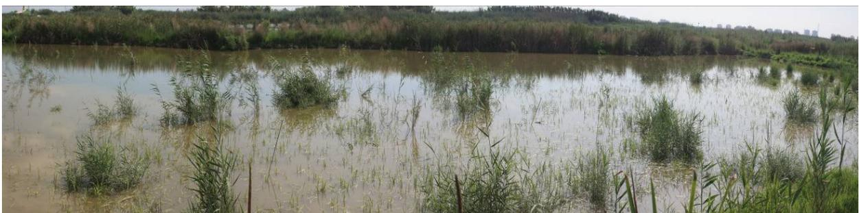
**Figura 33:** Fotografía panorámica del *Tancat de la Pipa*, filtro fp2, realizada en julio de 2012. Filtro plantado con *Phragmites australis*.
