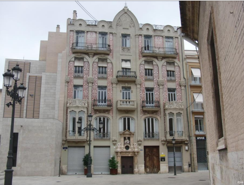
Edificio del Punt de Gantxo, Plaza de la Almoina, valencia.
