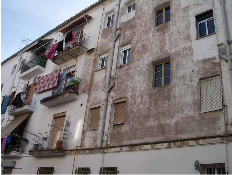
Vista de los desagües.
