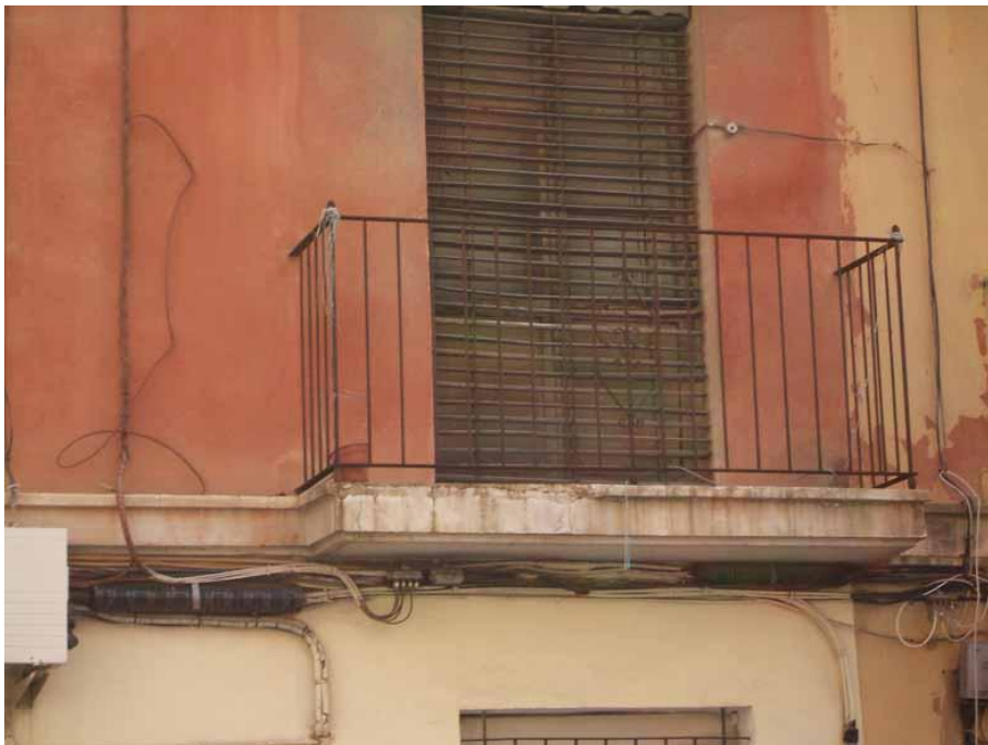
Imagen de los balcones originales de estos edificios.
