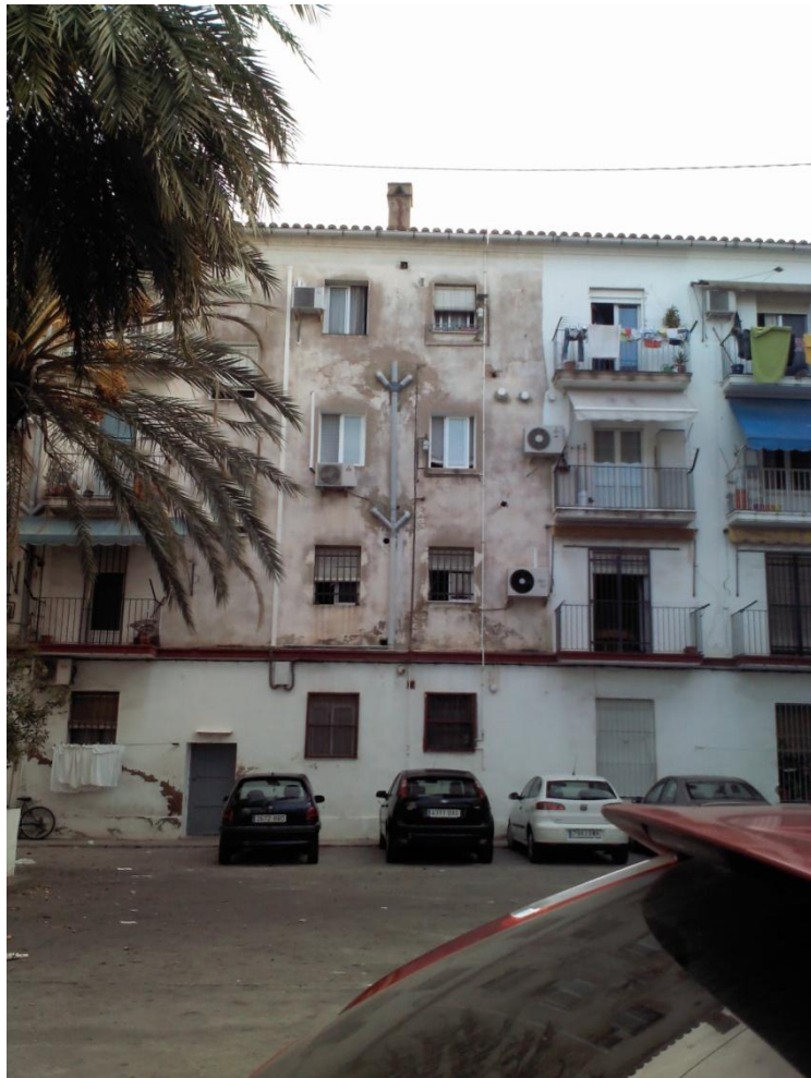
Fotografías del patio mostrando el distinto estado de conservación de las fachadas.
