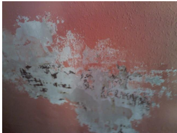
Imágenes de humedades en la pared que de al patio en el salón.
