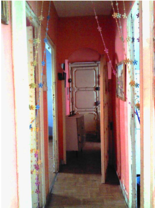
Pasillo de la vivienda de la transformación
