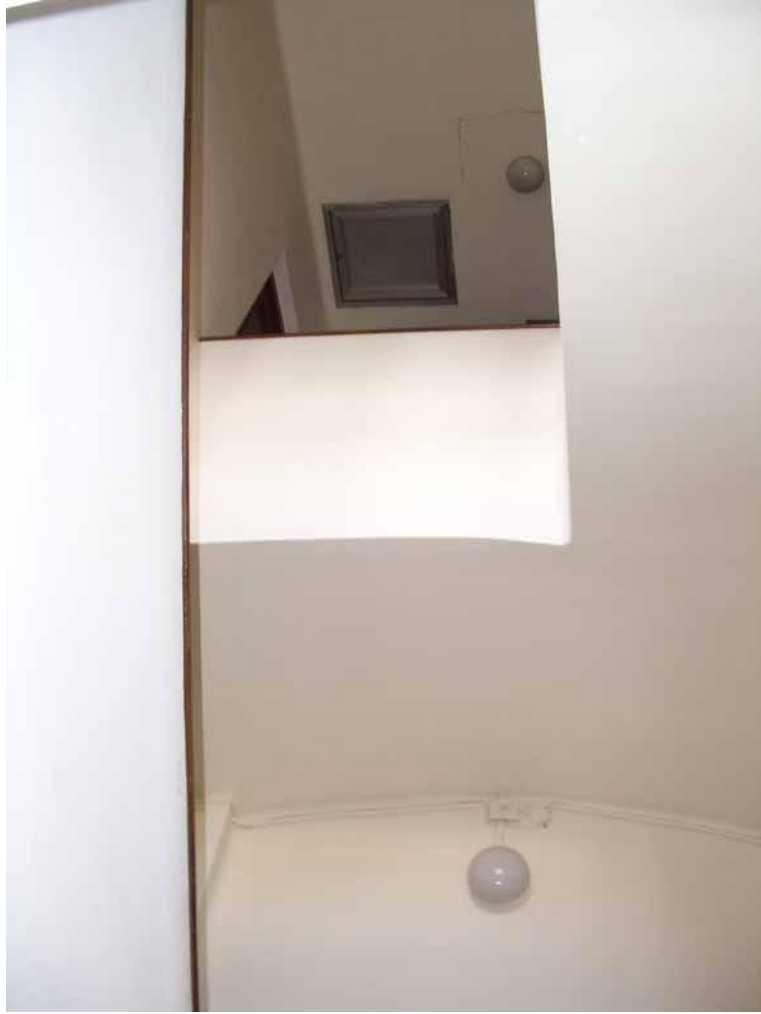
Escaleras y trampilla de acceso a la bajo cubierta.
