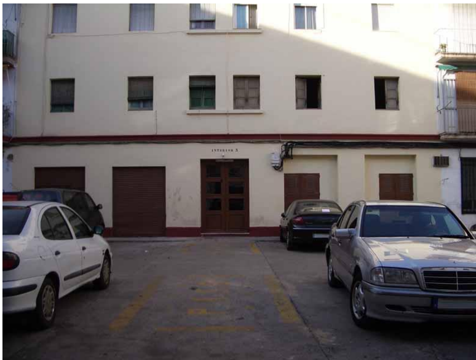
Vista del patio de acceso por el patio vecinal, del bloque interior.
