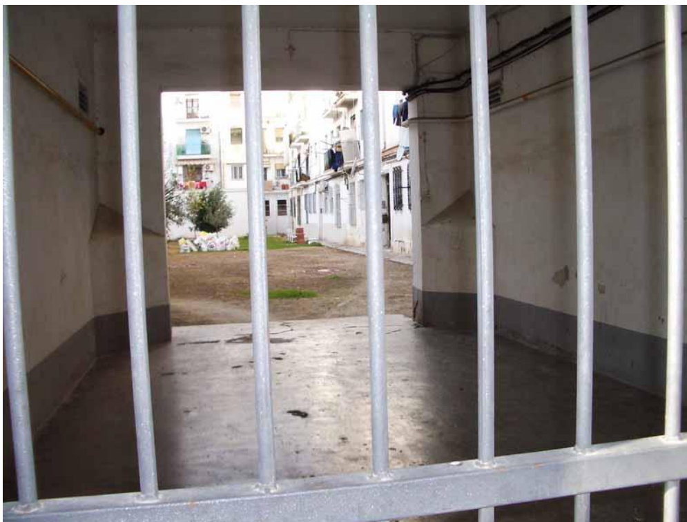
Vista del patio desde la calle Conde Torrefiel.
