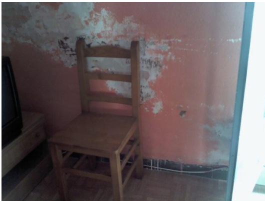
Imágenes de humedades en la pared que de al patio en el salón.
