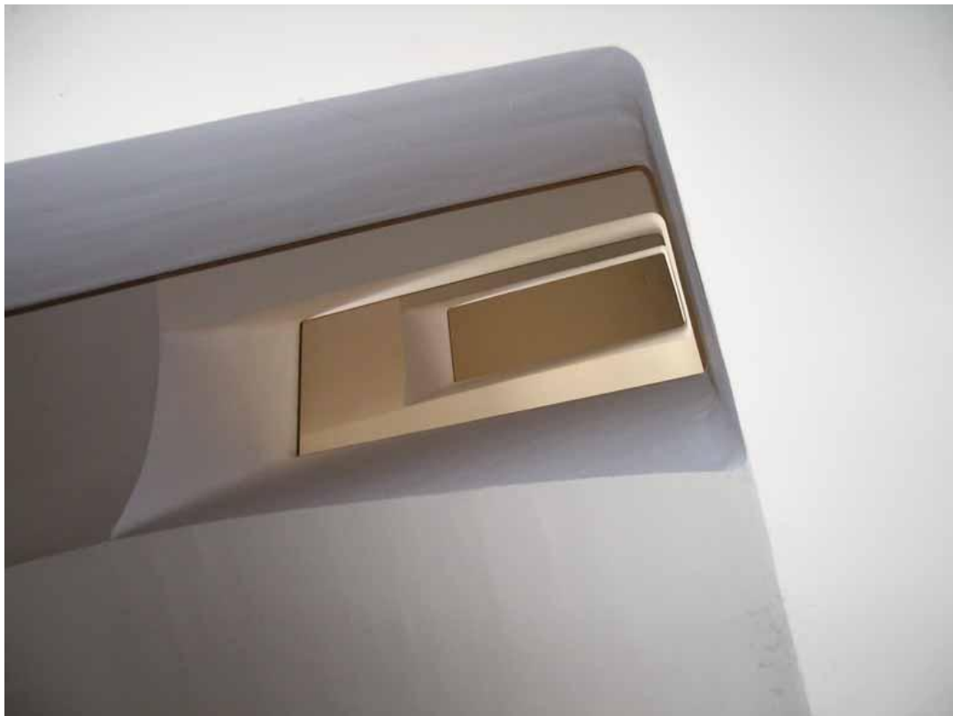
Vista del hueco de la escalera, de 90 cm.
