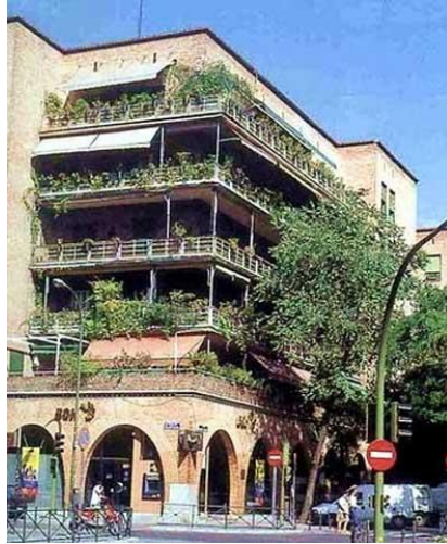
Fachada casa de Las Flores, Madrid.
