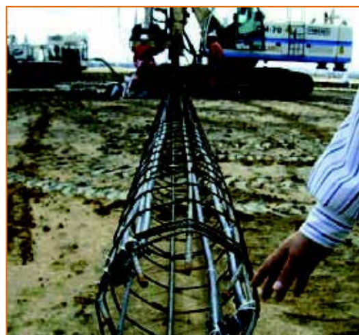
Figura 25. Sondas geotérmicas unidas a estructura
