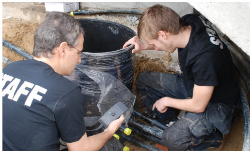
Figura 38. Preparación de colectores
