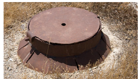
Figura 37. Tapa de la perforación
