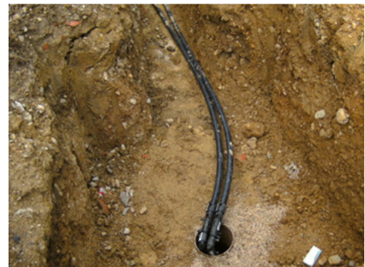
Figura 36. Introducción del colector en la perforación
