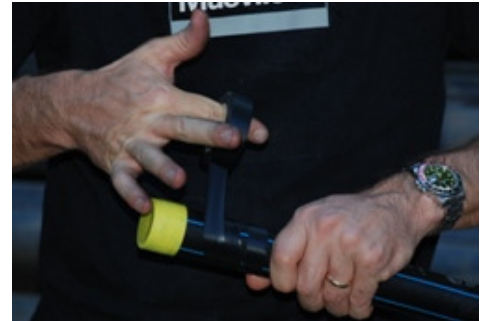
Figura 35. Fijación de colectores
