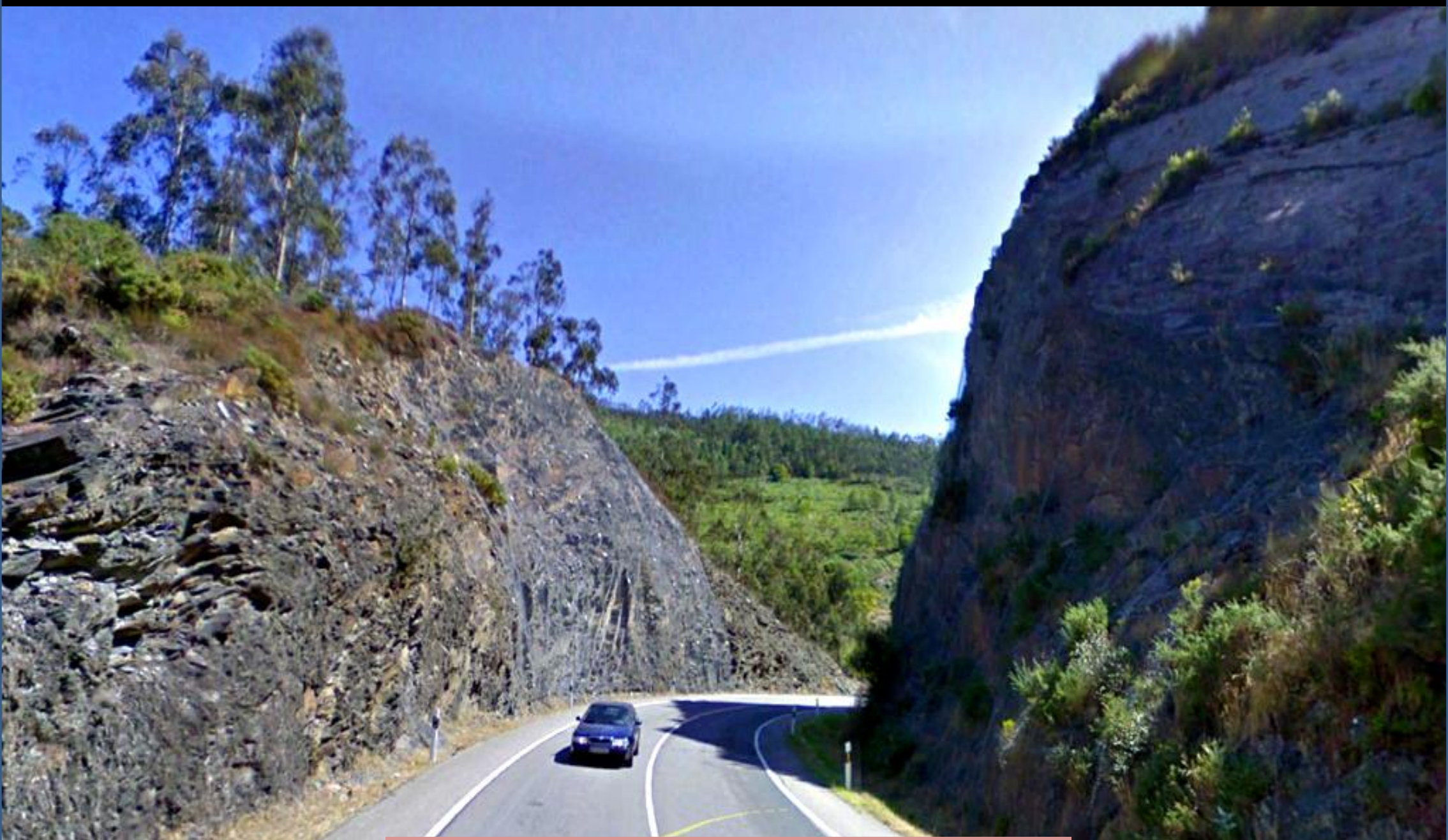
Peligrosidad de desprendimientos en las pizarras y areniscas del Cámbrico-Ordovícico, con mallazos. E de Villarouz, Lugo. SW Hoja de Vegadeo, límite con Asturias.
