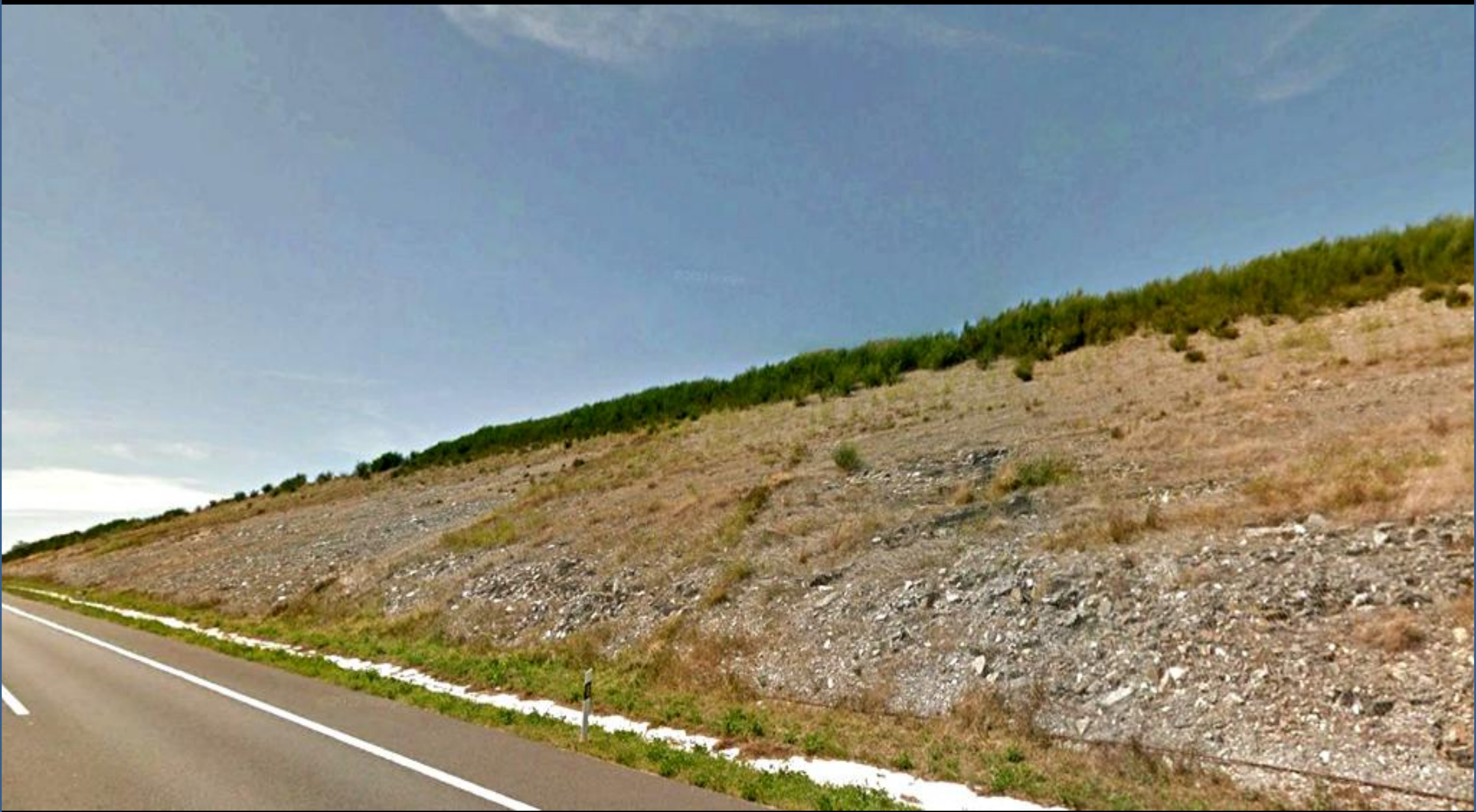
Observa el bajo ángulo del talud en los materiales del Precámbrico en la autovía al N de Frayas, Lugo. (y aún así hay desprendimientos menores). SW Hoja de Mondoñedo.
