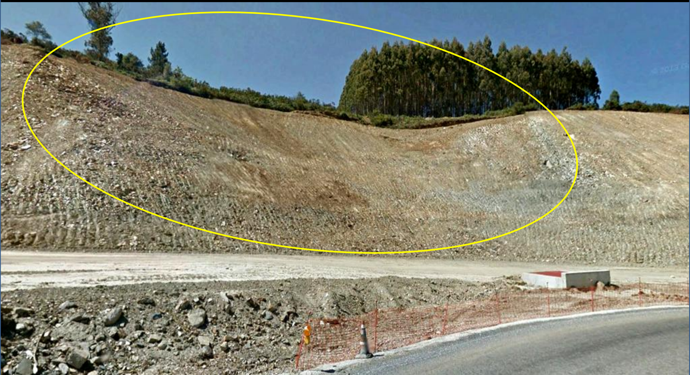
Ajuste' de la pendiente del talud en terrenos del Cámbrico Inf., posiblemente deslizados. NW de Curros, Lugo. Centro S. Hoja de Mondoñedo.
