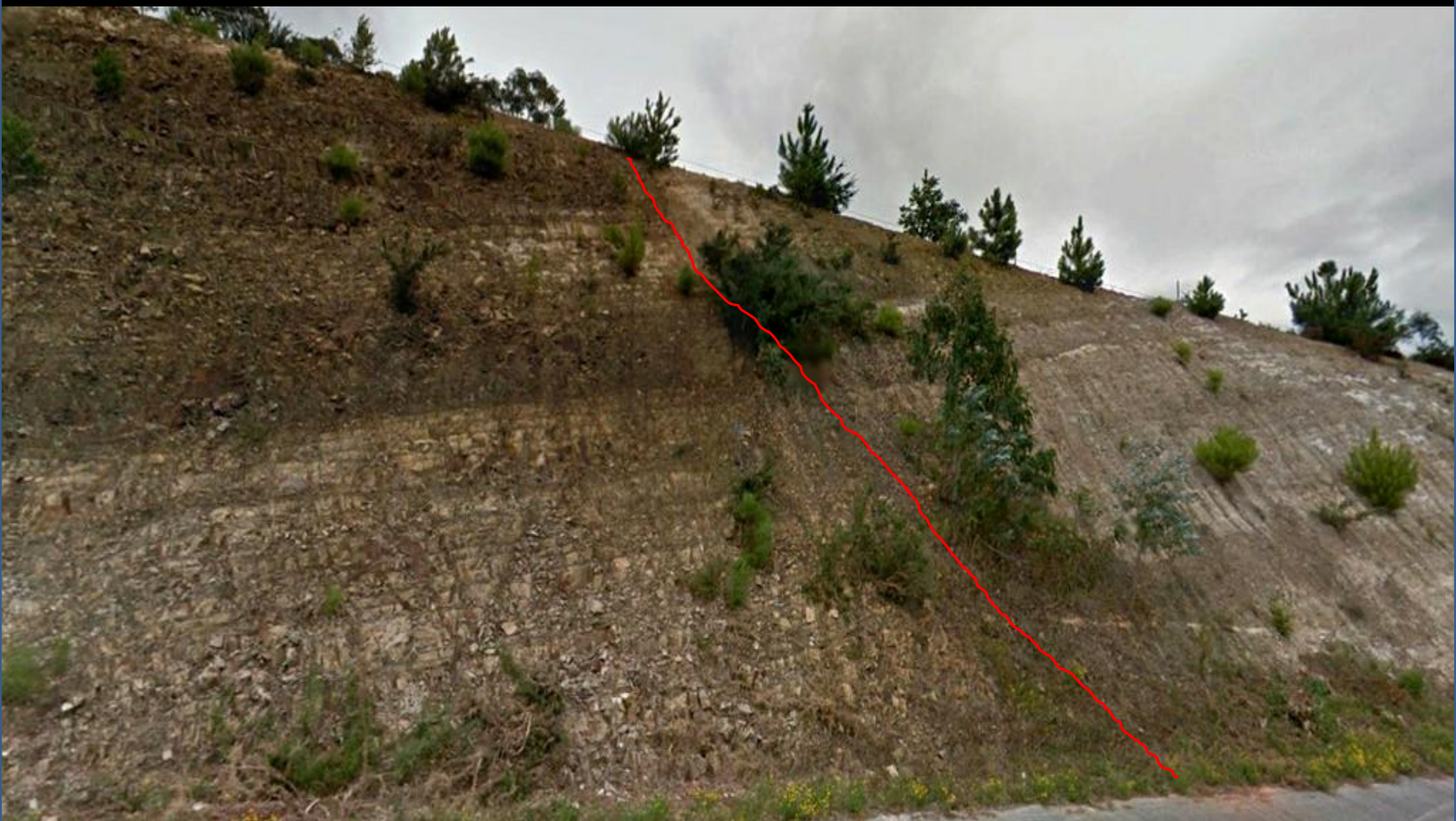
Falla en las cuarcitas y pizarras de la Serie de Los Cabos. Cambro-Ordovícico. Autovía del Cantábrico, NW de Acebedo, Lugo. SW Hoja de Ribadeo.
