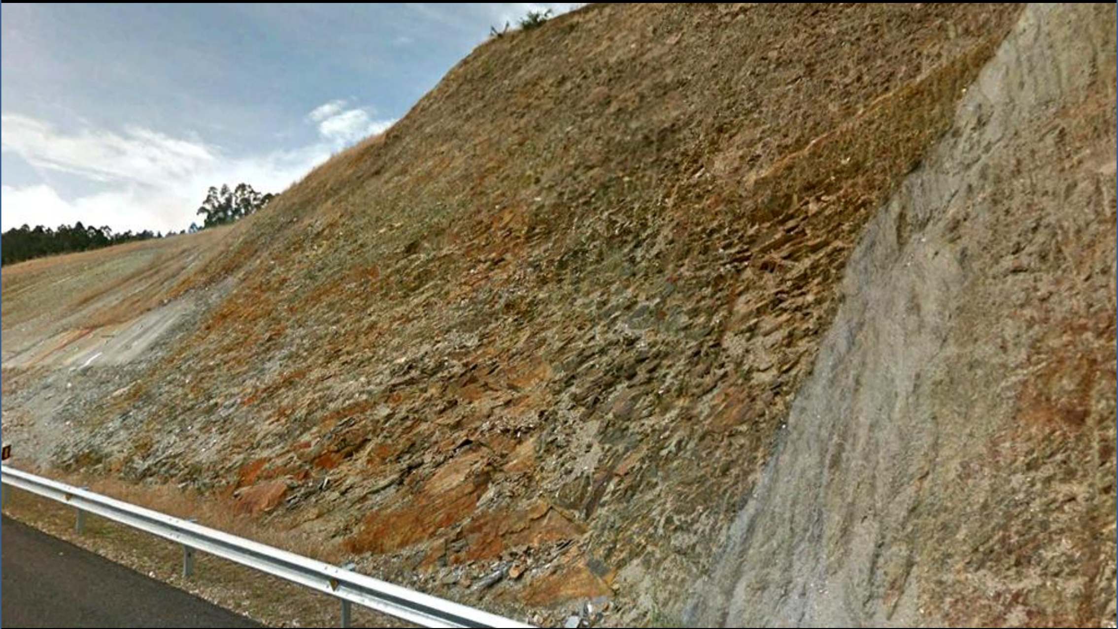
Cambios en la pendiente del talud. Autovía del Cantábrico. Pizarras y areniscas, falladas, del Cámbrico Sup.- Ordovícico. NW Villanueva Lorenzana, Lugo. NE Hoja de Mondoñedo.
