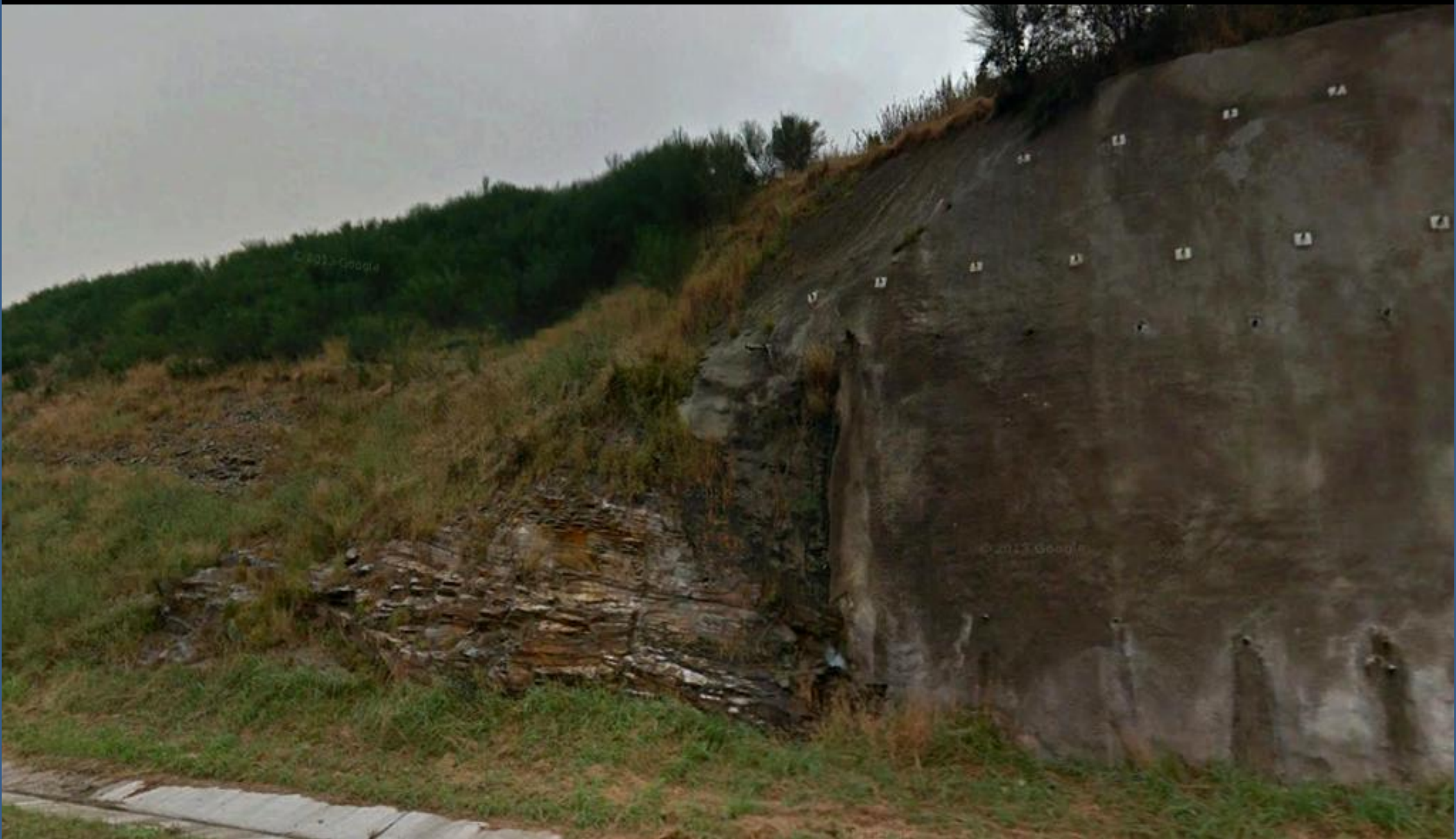
Gunitado y bulonado sobre las rocas cuarzo-pelíticas del Precámbrico. NW de Candabade, Lugo. SW Hoja de Mondoñedo.
