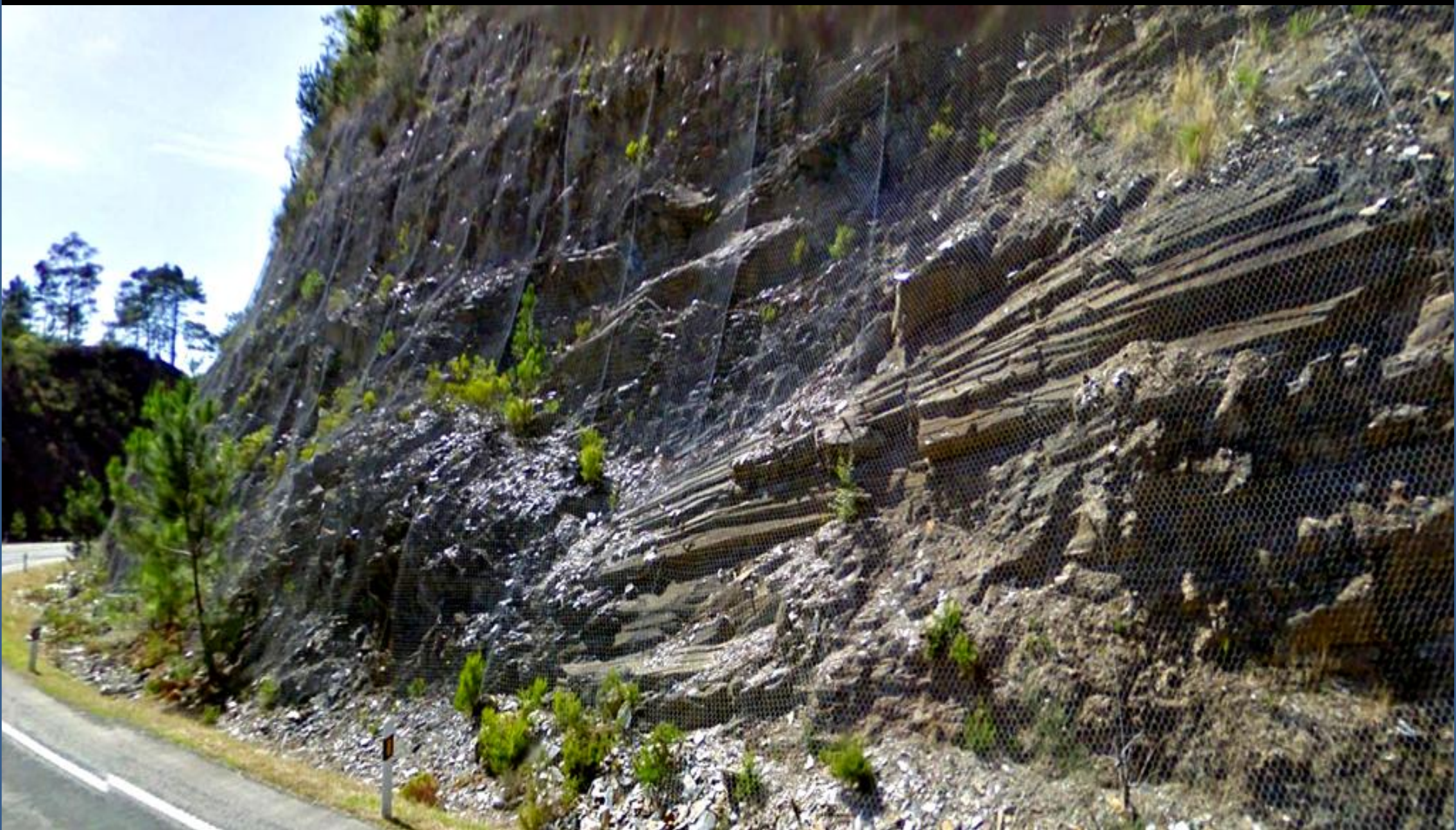
Mallazo en las pizarras del Ordovícico, falladas. N de Saldoira, Lugo. SW Hoja de Vegadeo
