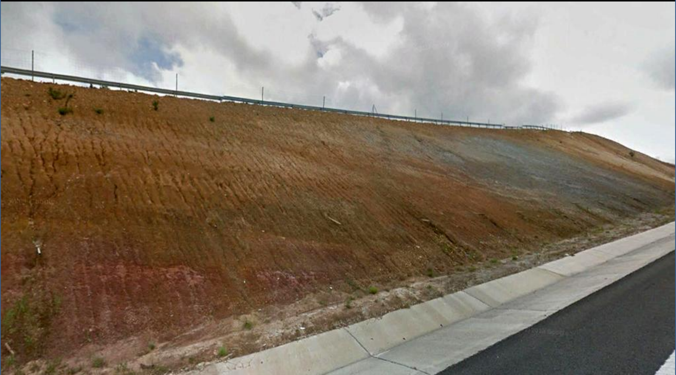
Talud de esquistos alterados del Precámbrico, N de O Revellón, Lugo. SW Hoja de Puente de García Rodríguez.
