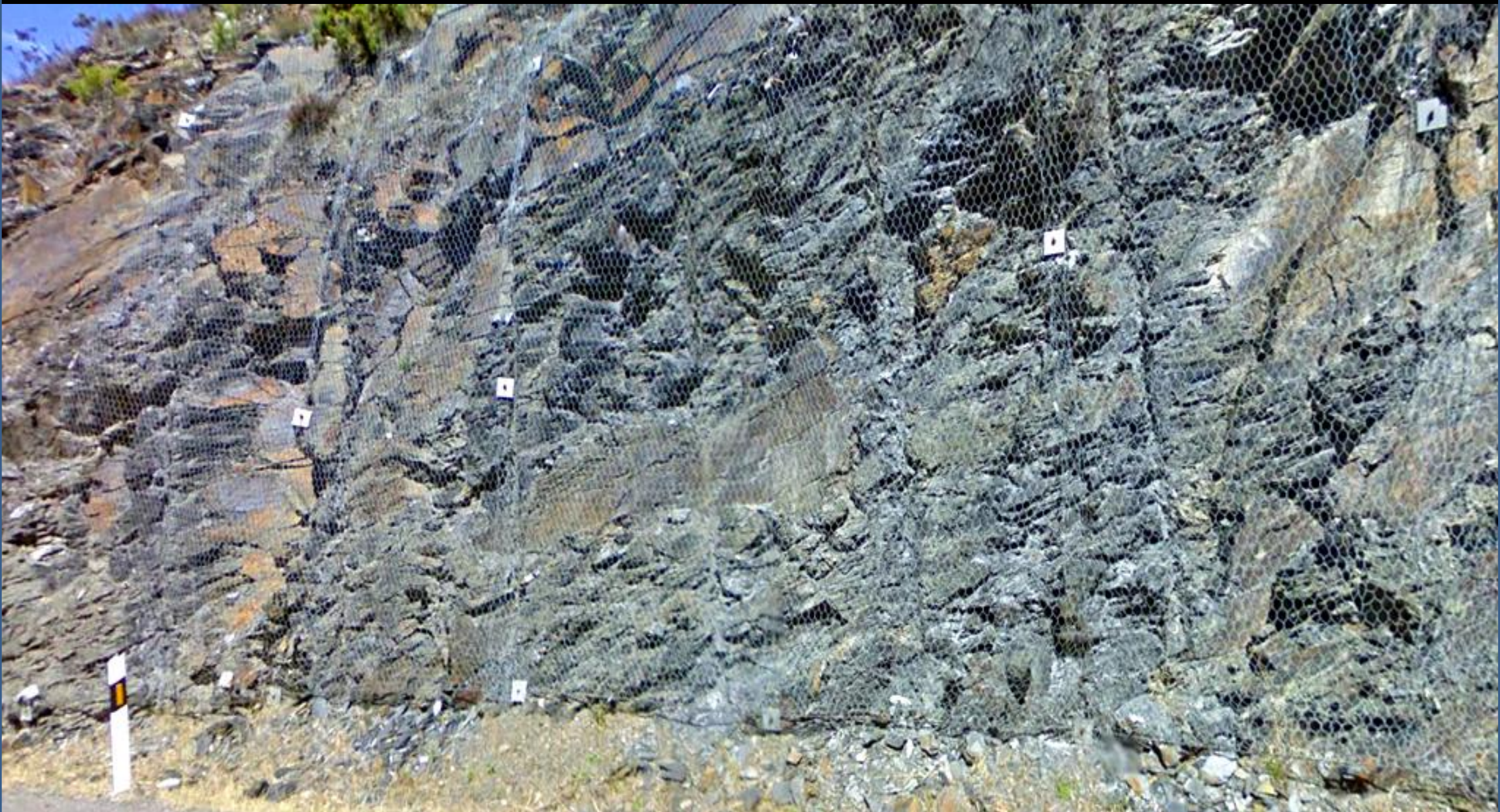
Detalle de anterior: Pizarras del Cámbrico-Ordovícico, con mallazo y bulonado. E de Villarouz, Lugo. SW Hoja de Vegadeo, límite con Asturias.
