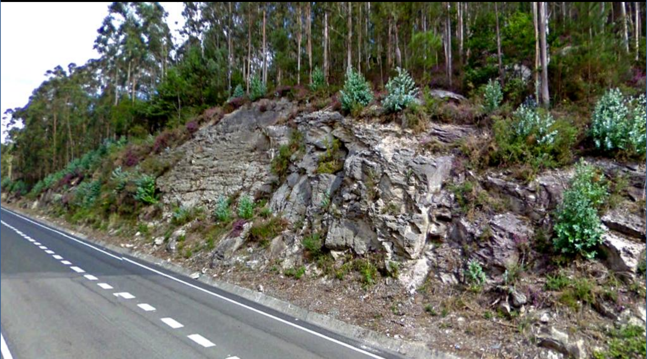
Talud de granito de dos micas tectonizado. S de Rua, Lugo. NW Hoja de Mondoñedo.
