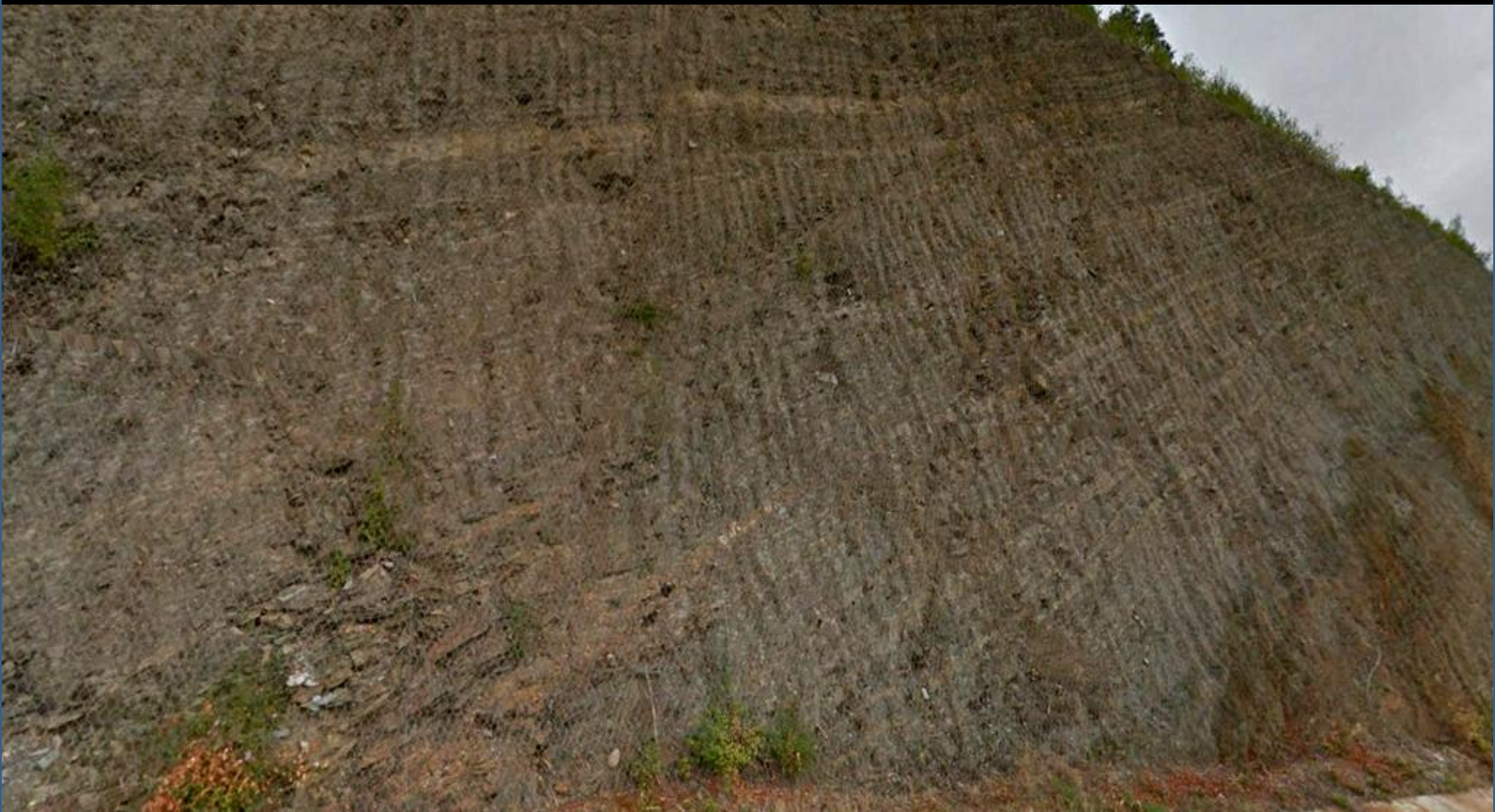
Mallazo en los esquistos del Silúrico. Al N de Pigara, Lugo. SW Hoja de Villalba.
