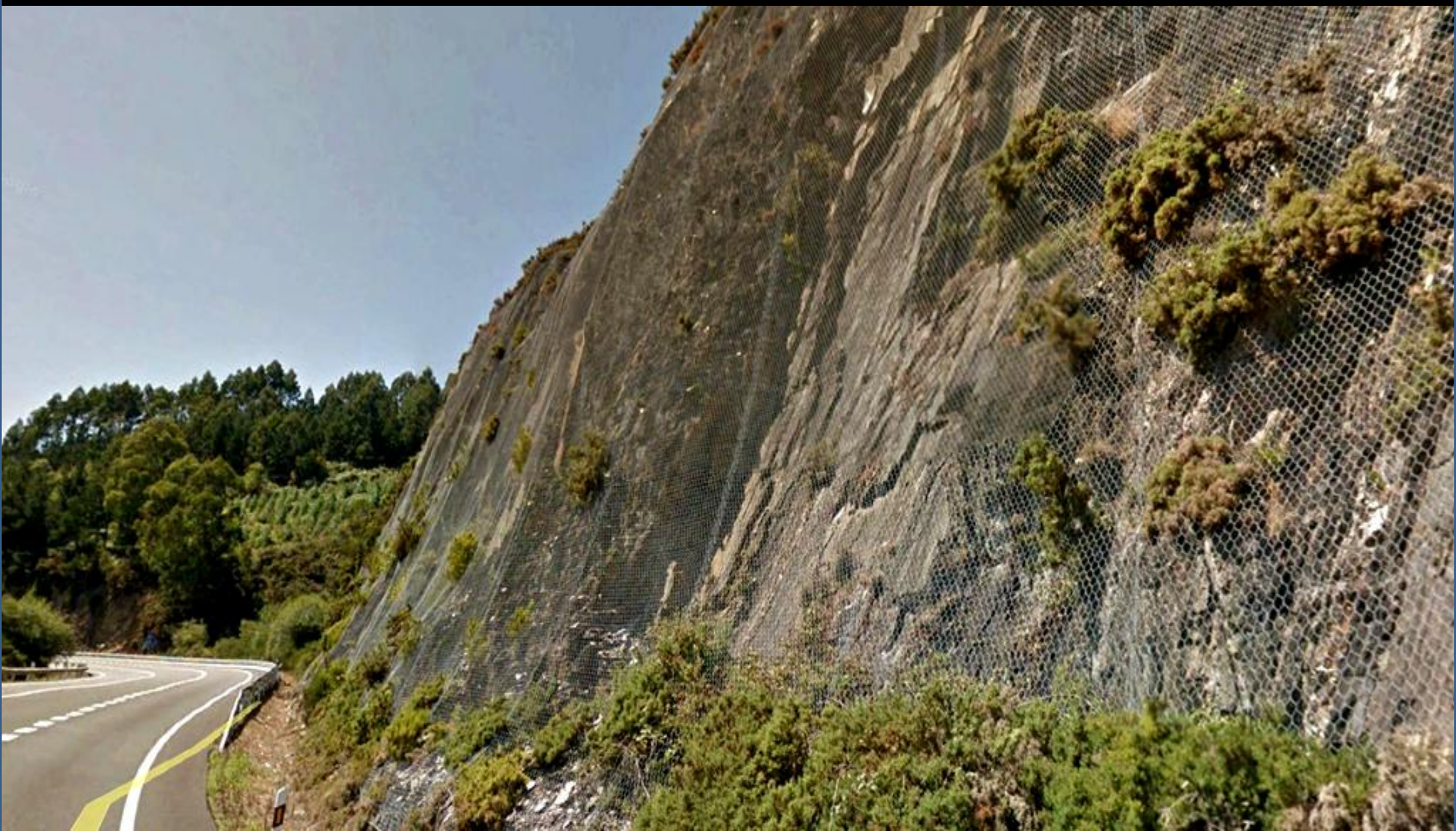
Mallazo para estabilizar las pizarras y areniscas de las Capas de Villamea, Cambro-Ordovícicas. S de Corno del Val, NW de Praducelo, Lugo. NE Hoja de Meira.
