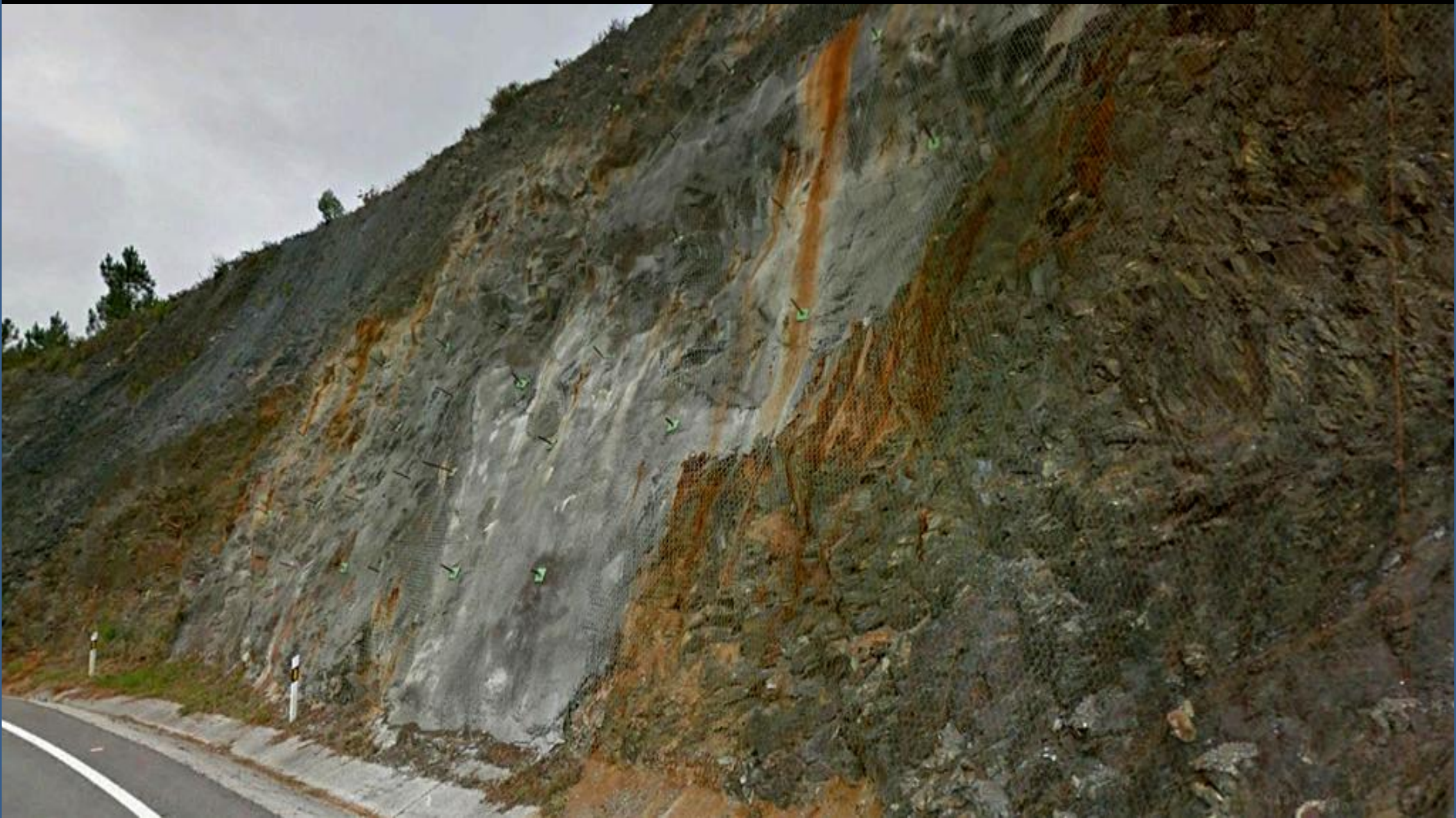
Detalle de anterior: Mallazo, gunitado y con bulones en los esquistos del Silúrico. Al N de Pigara, Lugo. SW Hoja de Villalba.
