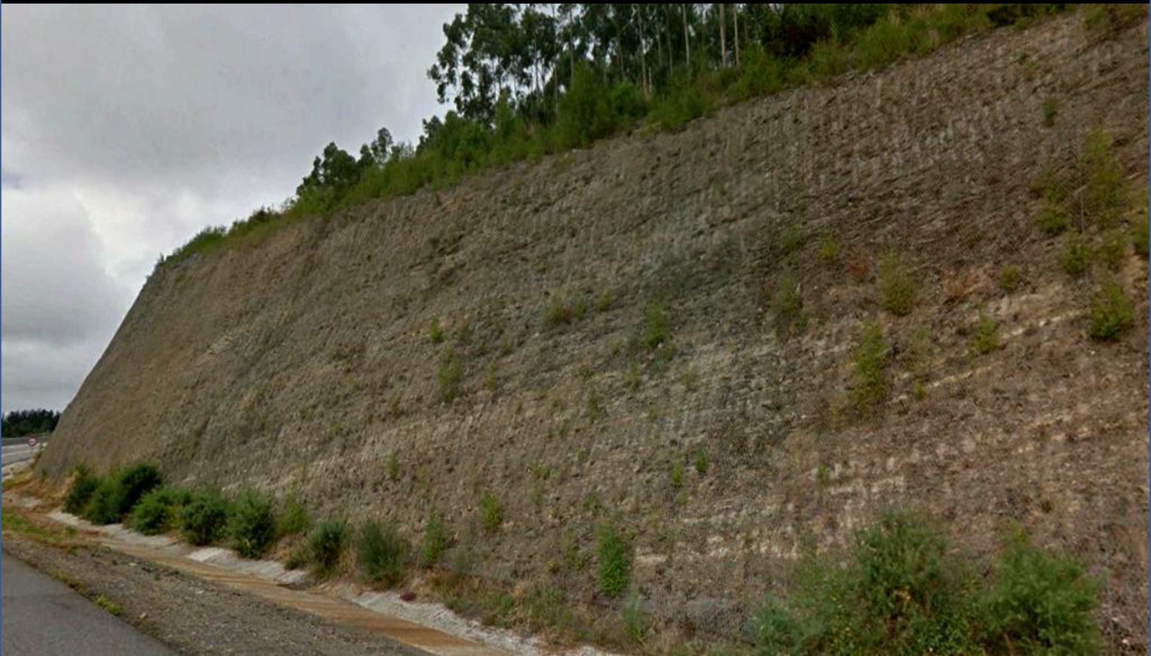
Mallazo en los esquistos del Silúrico. Al N de Pigara, Lugo. SW Hoja de Villalba.
