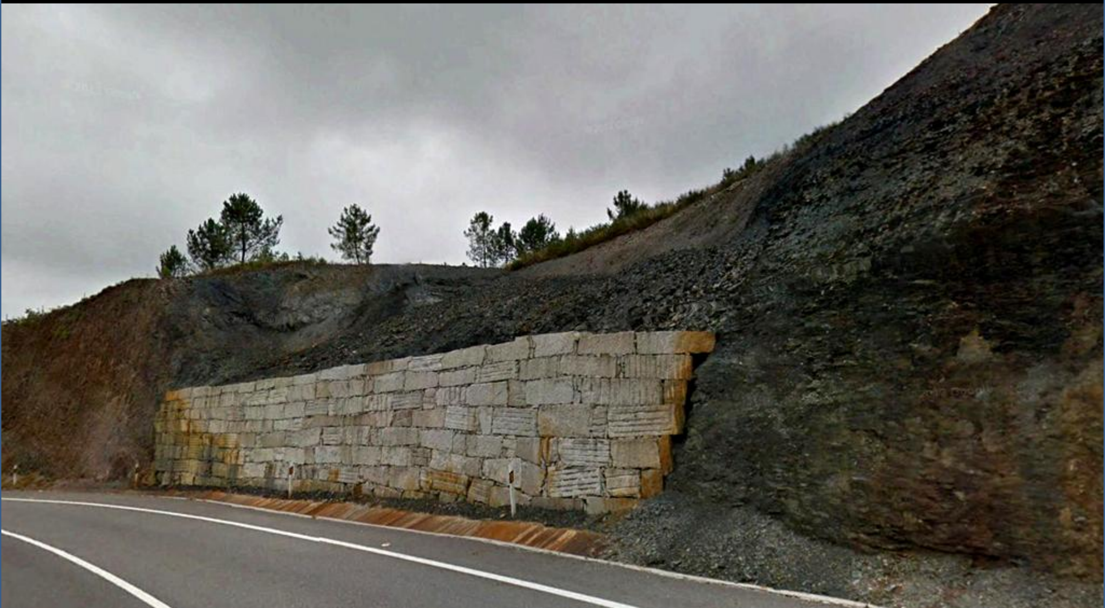
Obras de estabilización de talud en zona de posible falla y deslizamiento en los esquistos del Silúrico. Al N de Pigara, Lugo. SW Hoja de Villalba.
