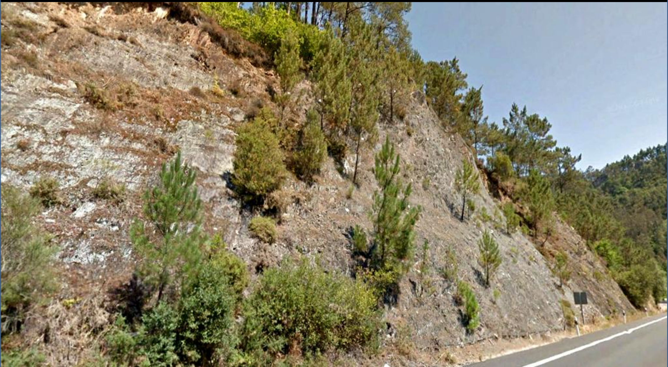
Mallazo para estabilizar las pizarras y areniscas de las Capas de Villamea, Cambro-Ordovícicas. NE de Saldoira, Lugo. NE Hoja de Meira.
