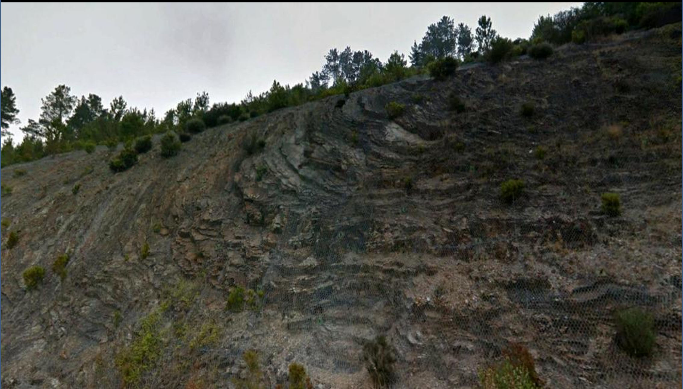
Detalle de anterior: Inestabilidad en plegamiento de Ordovícicos. Mallazo. SW de A Borquería, Lugo. SW Hoja de Becerreá.
