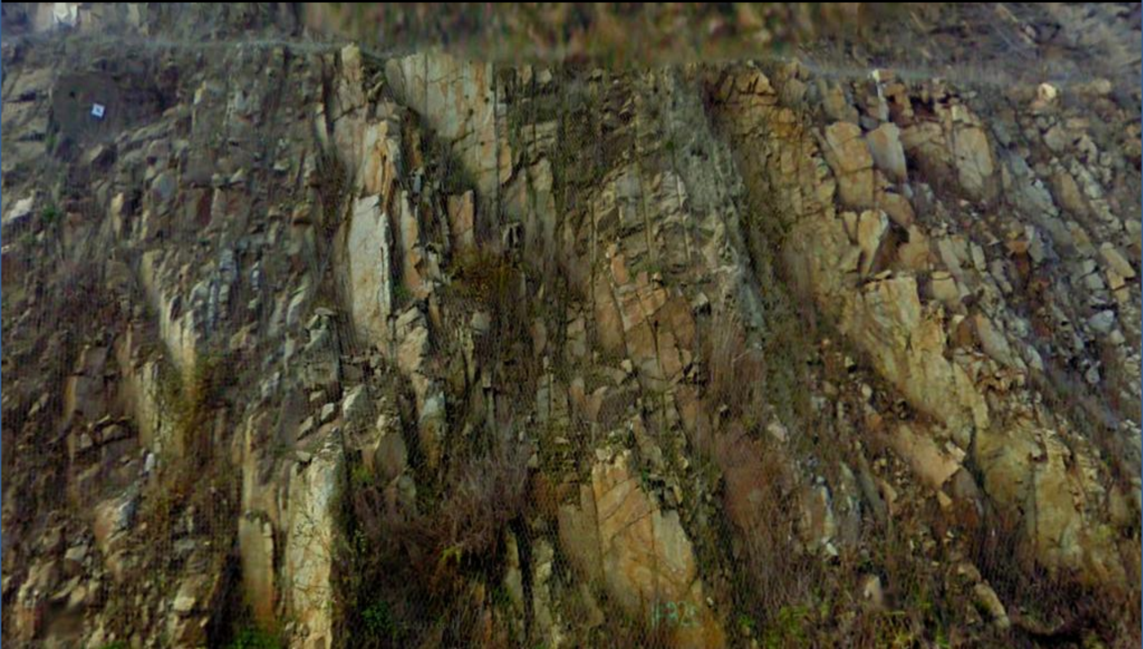
Mallazo y bulonado en las granodioritas de la carretera Lugo-Monforte en O Páramo, Lugo, SW Hoja de Baralla.
