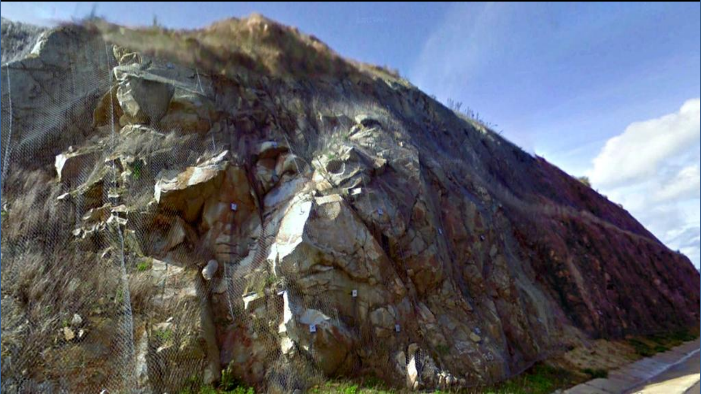
Mallazo y bulonado en las granodioritas de la carretera Lugo-Monforte en O Páramo, Lugo, SW Hoja de Baralla.
