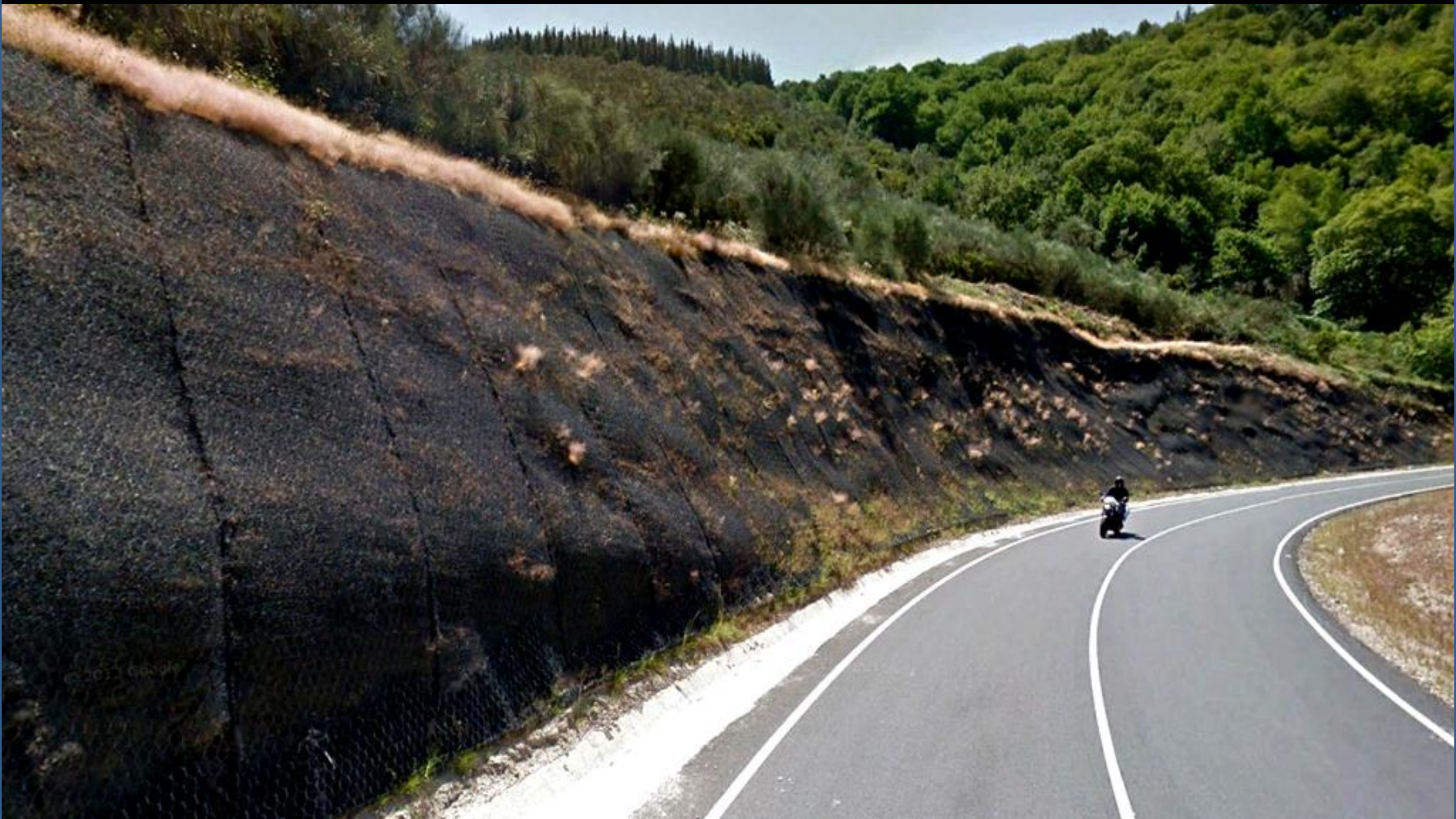
Mallazo para estabilizar el talud en las pizarras negras del Ordovícico Med. NE de Souto, Lugo. Centro Hoja de Becerreá.
