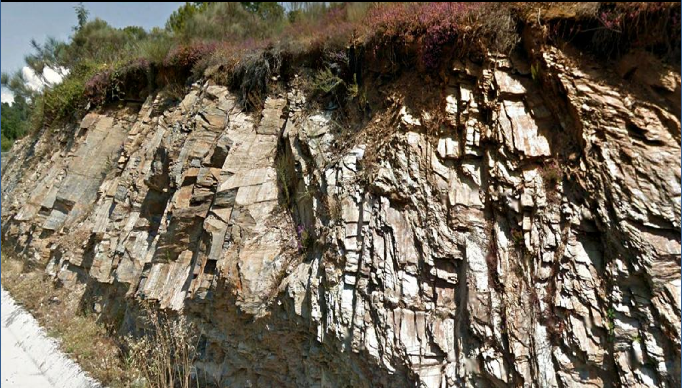
En la zona anterior. Superficies de pizarrosidad proclives al deslizamiento. Pizarras y areniscas Cambro-Ordovícicas. ¿Cuántas familias de discontinuidad?. S de Navia de Suarna, Lugo. NW Hoja de Becerreá.
