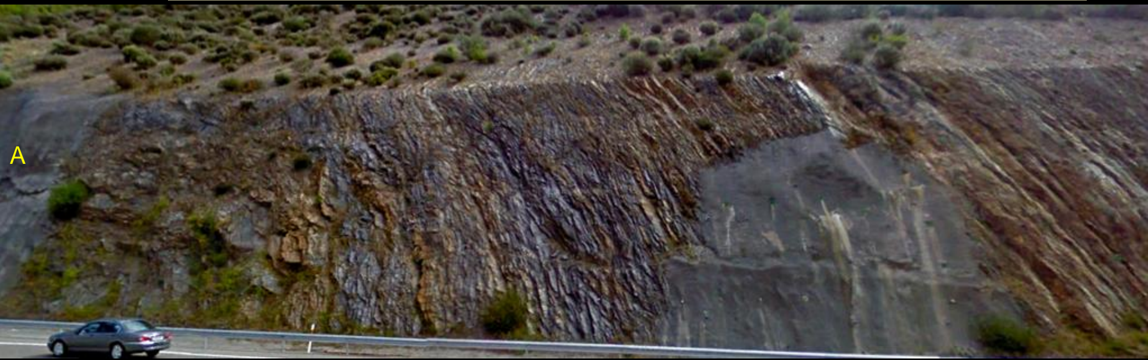
Imagen partida de talud con los Ordovícicos tectonizados, inestables y gunitados. En la autovía A6. SW de A Borquería, Lugo. SW Hoja de Becerreá.
