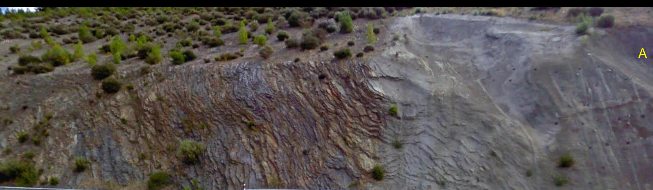
Imagen partida de talud con los Ordovícicos tectonizados, inestables y gunitados. En la autovía A6. SW de A Borquería, Lugo. SW Hoja de Becerreá.
