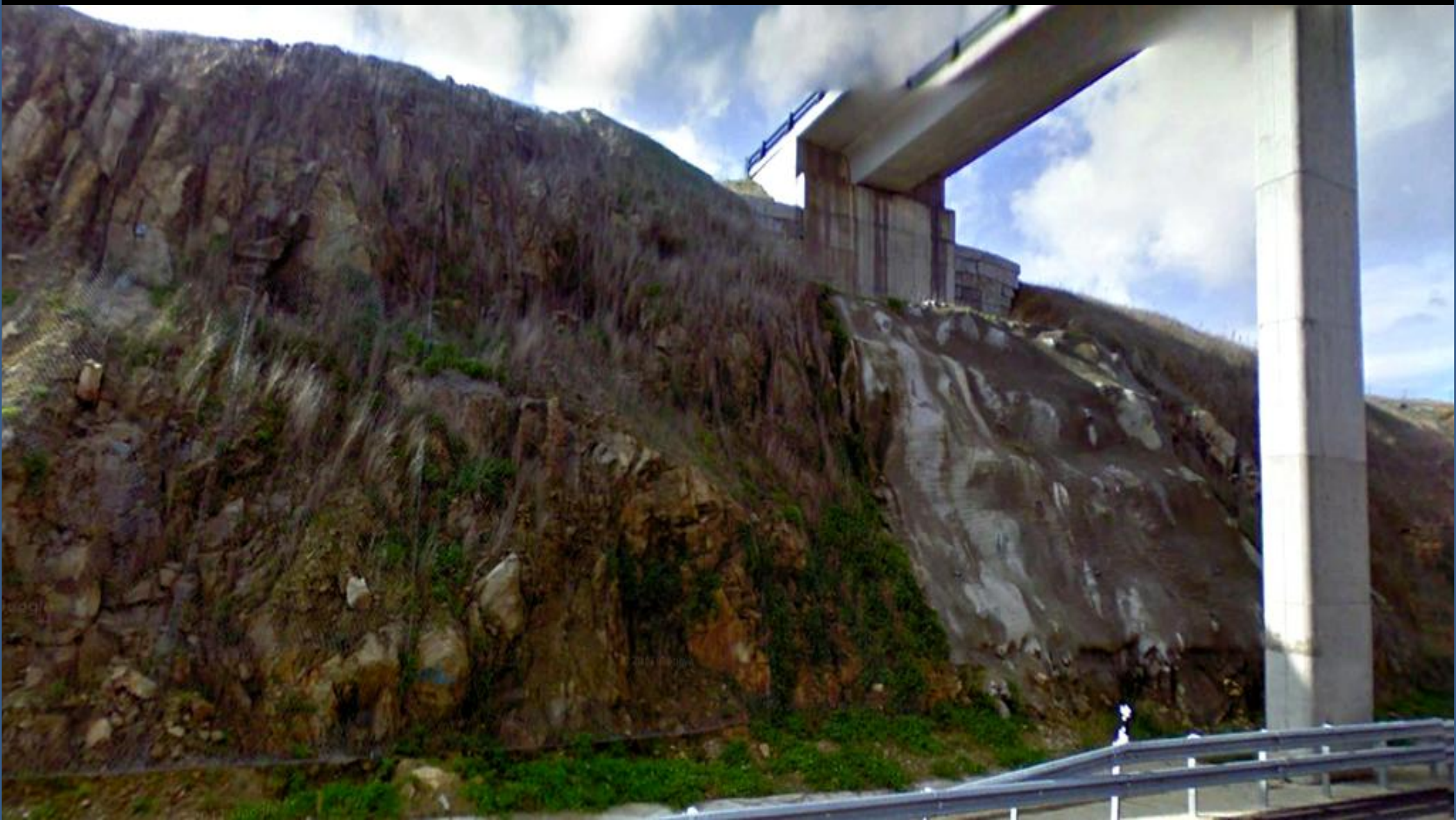
Estabilización de ladera con mallazo y gunitado en las granodioritas de la carretera Lugo-Monforte en O Páramo, Lugo, SW Hoja de Baralla.
