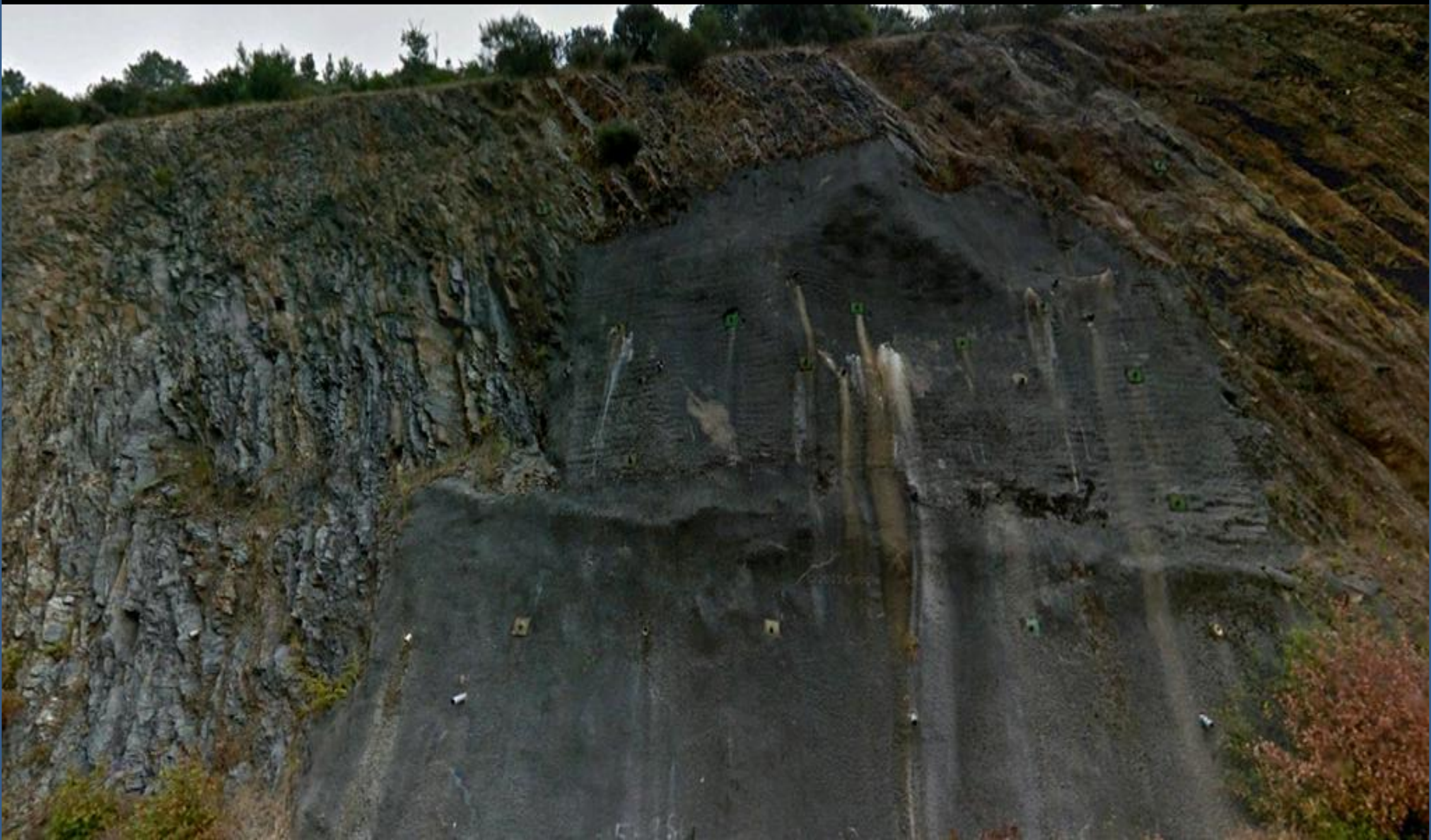
Mallazo, gunitado y bulonado. En las pizarras del Ordovícico. SW de A Borquería, Lugo. SW Hoja de Becerreá.
