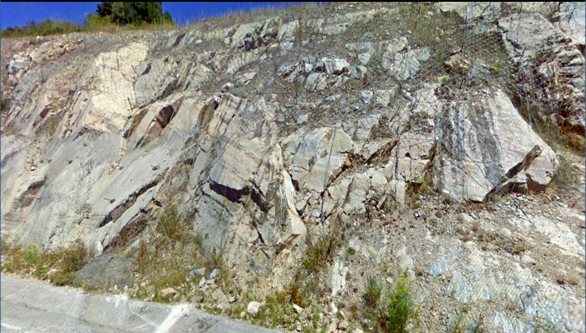
Areniscas Cámbrico- Ordovícicas con mallazo y bulones. Autovía al NE de Cadoalla, Lugo. SW Hoja de Becerrea.
