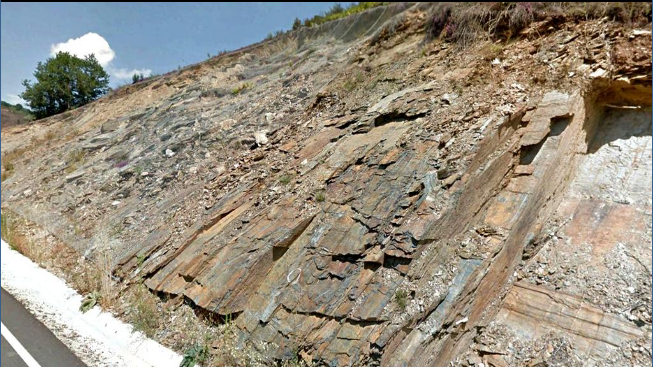
Inestabilidad de ladera en las pizarras y areniscas Cambro-Ordovícicas. S de Navia de Suarna, Lugo. NW Hoja de Becerreá.
