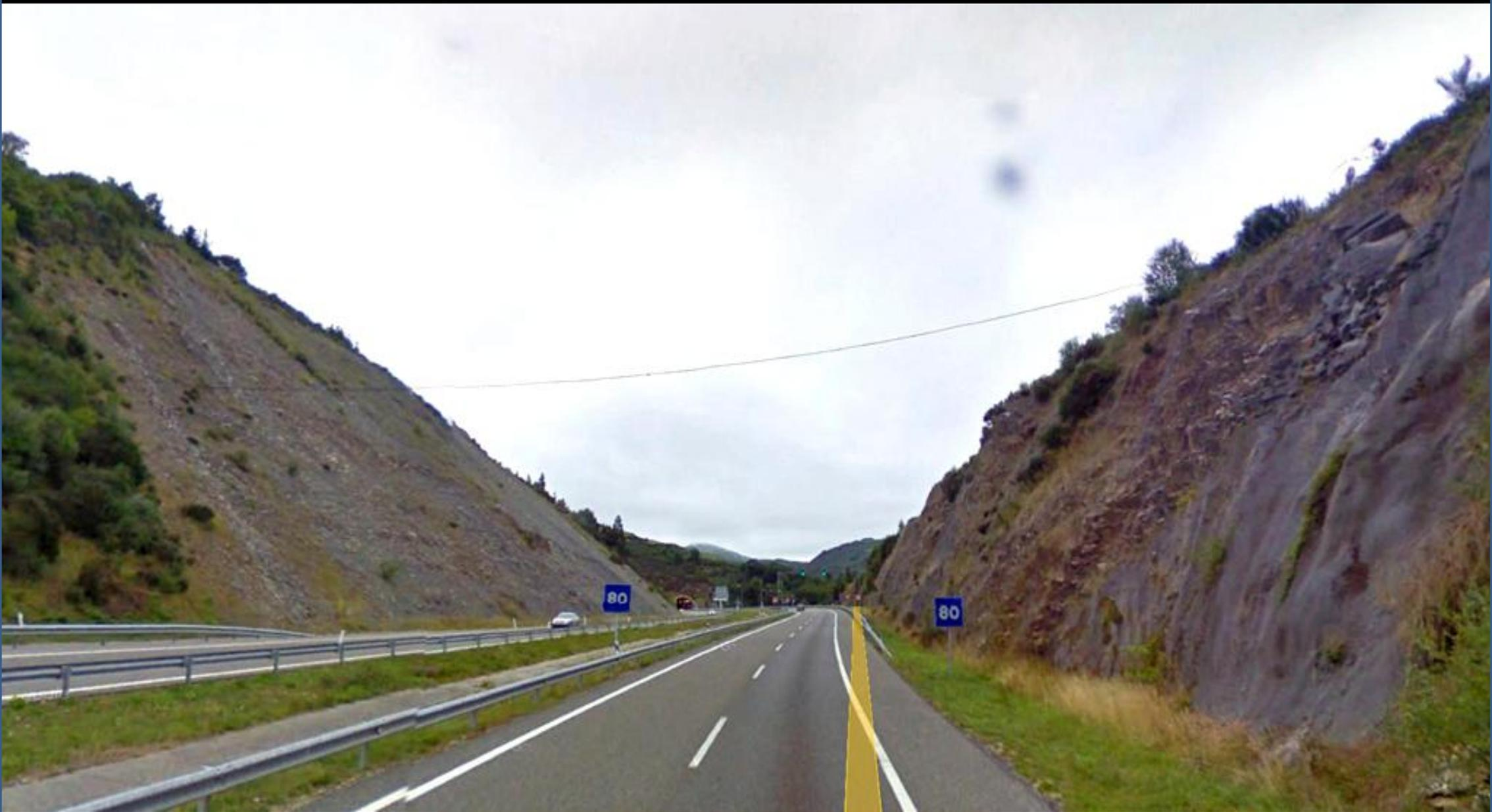
Autovía 6. Metaestabilidad del talud de pizarras falladas del Cámbrico y gunitado a la derecha. SW de Los Nogales. NW Hoja.
