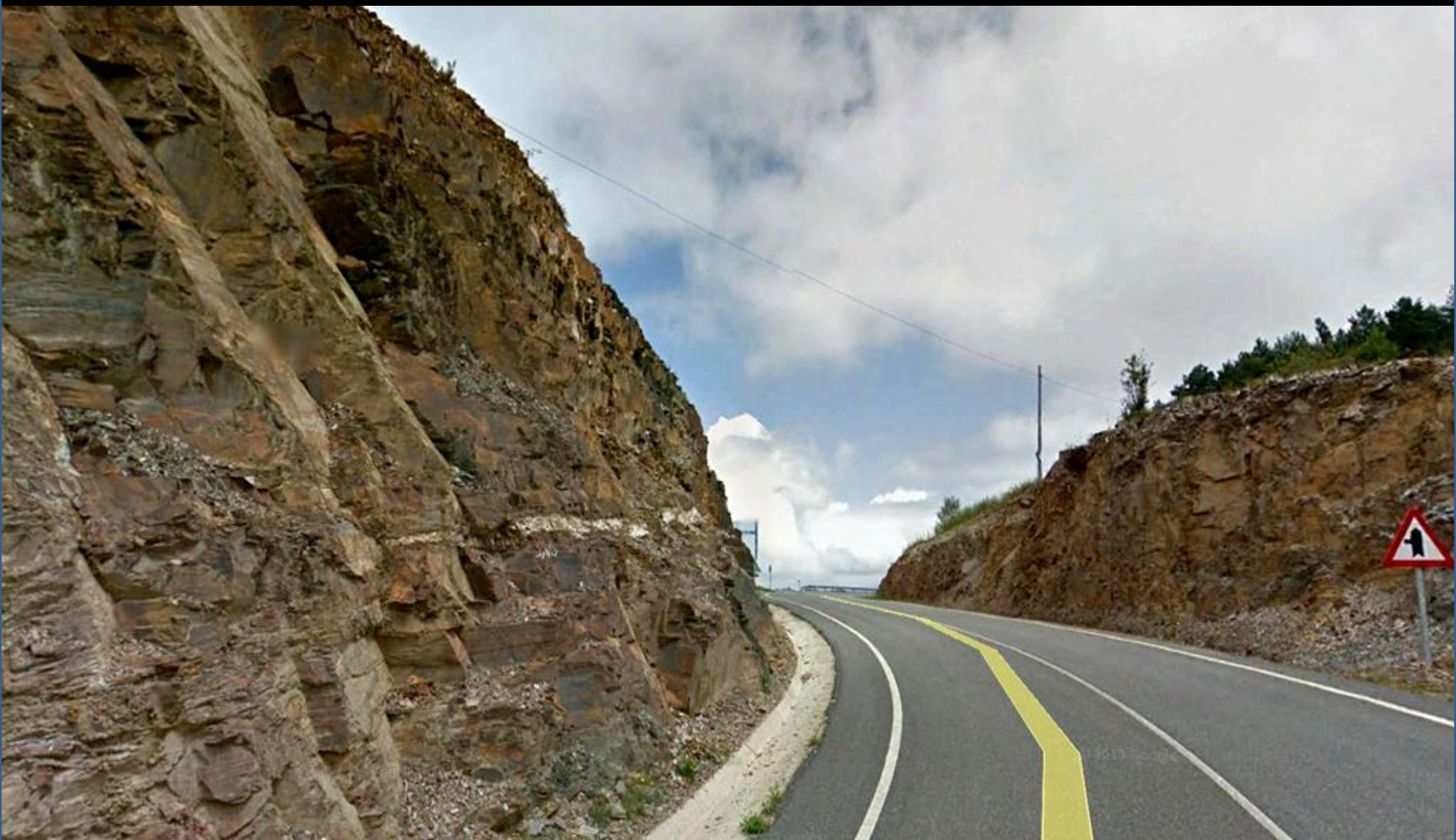
Taludes en pizarras negras con niveles de cuarcita, del Ordovícico Med.-Sup., al NNW de Leixazós, Lugo. SE Hoja de Monforte de Lemos.
