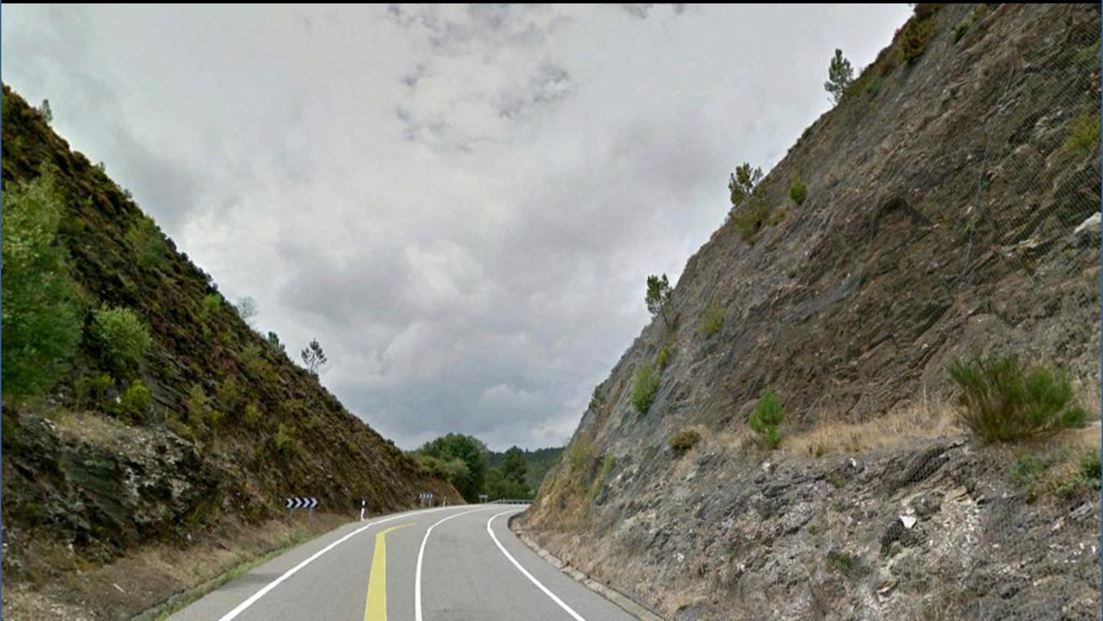
Taludes de esquistos con niveles de cuarcita del Precámbrico-Ordovícico, con mallazo. SE de Torguedo, Pontevedra.
