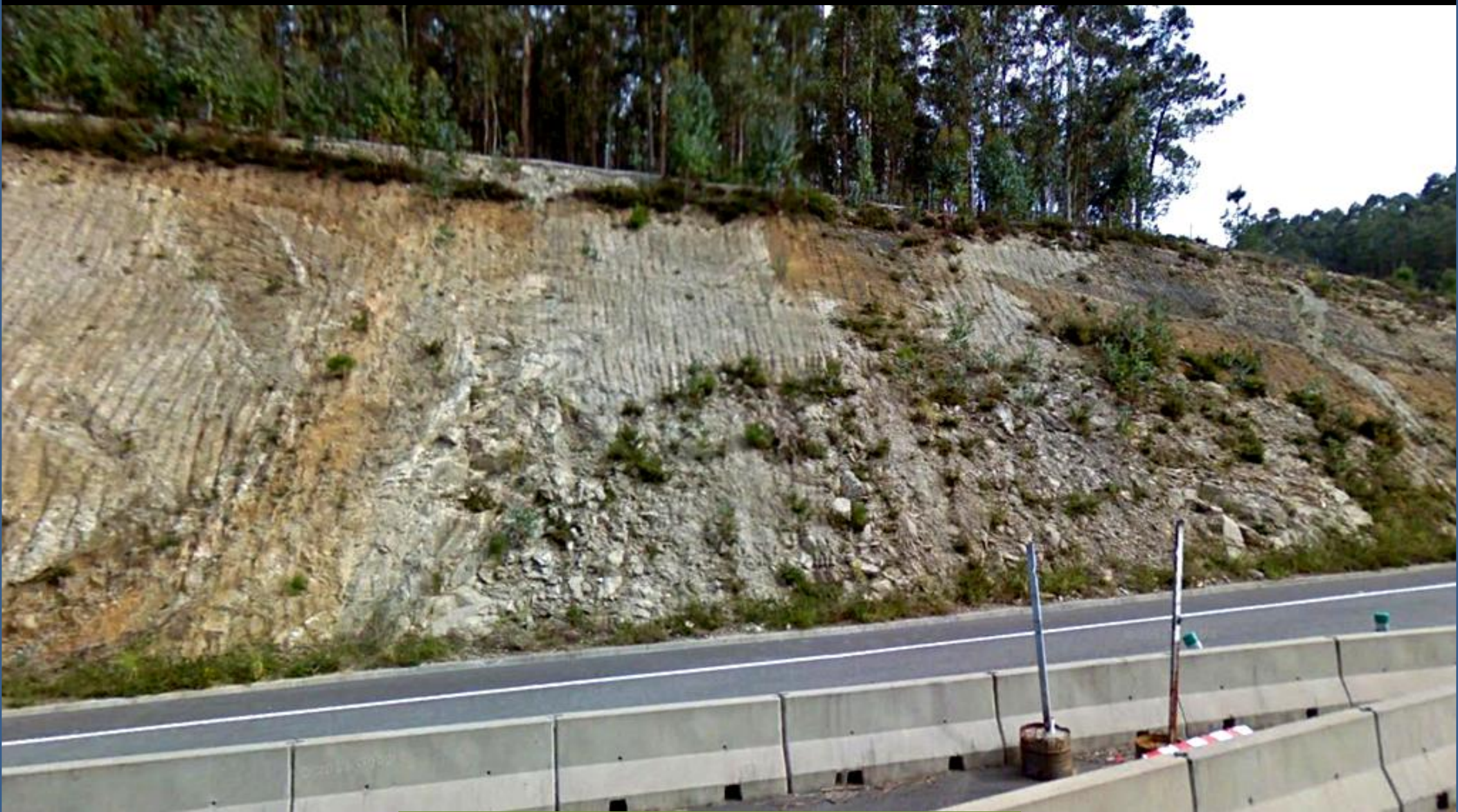
Talud metaestable en el granito alterado al E de Marín, Pontevedra. SW Hoja.
