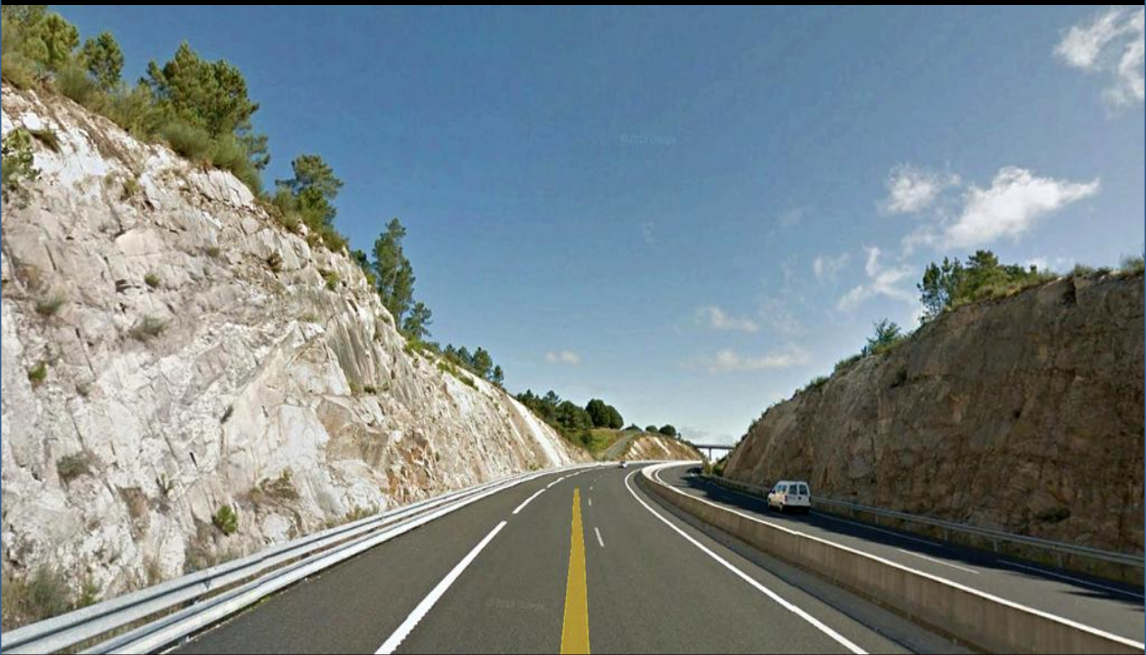
Taludes de granito adamellítico de dos micas en la Autovía. N de Outeiro, Orense. NE Hoja.
