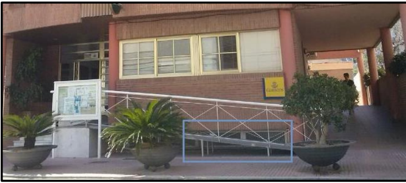
Figura 36. Fotografía ventana desde el exterior.
