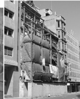
Imagen 6. Medio auxiliar: estabilizador de fachada
