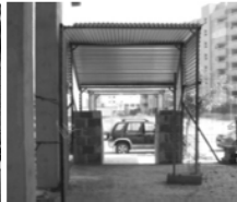
Imagen 8. Inst. prov. de protección: marquesina
