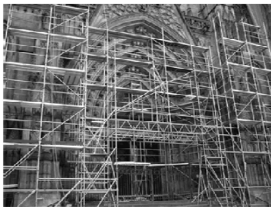
Imagen 4. Medio auxiliar: andamio de trabajo
