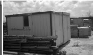
Imagen 10. Inst. prov. de uso y servicio: caseta aseo-vestuario
