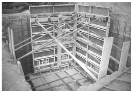
Imagen 5. Medio auxiliar: encofrado de muro y su apuntalamiento
