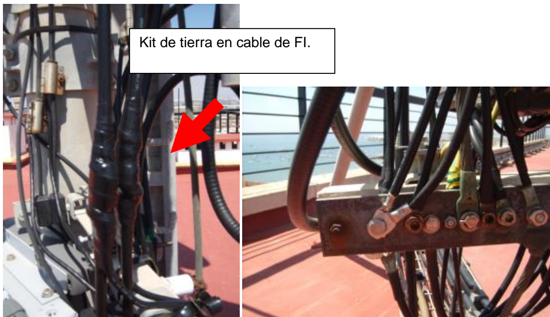
Figura 7.5: Kit de tierra en cable FI y conexión a pletina equipotencial.
