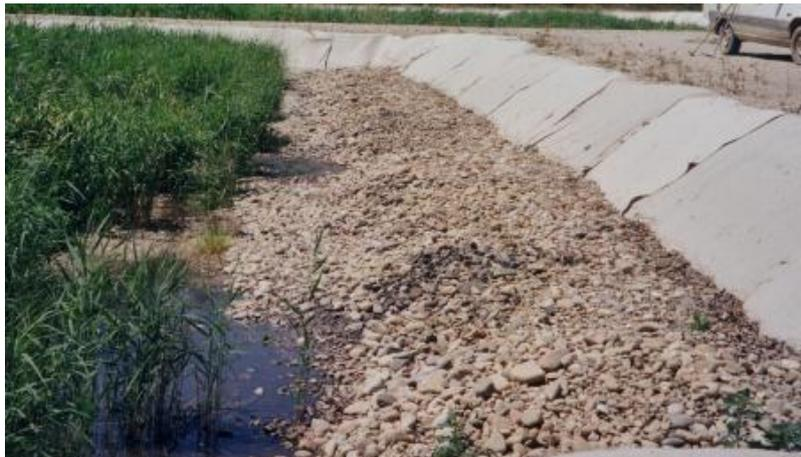
Gráfico N°29. Franja de material granular de gran tamaño en la zonas de entrada al humedal de flujo subsuperficial horizontal. Tomado de: Depuración con Humedales Construidos, Guía práctica de diseño, construcción y explotación de sistemas de humedales artificiales, Joan García Serrano, Angélica Corzo Hernández.
