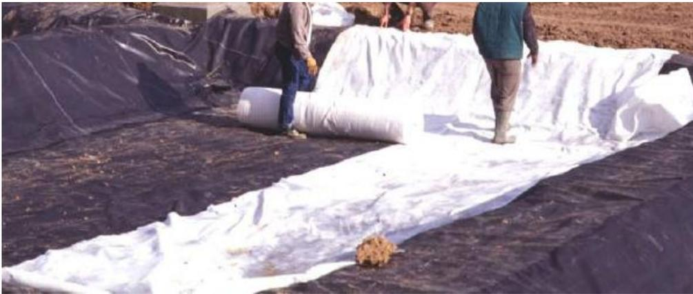
Gráfico N°37. Colocación de geotextil. Tomado de: Depuración con Humedales Construidos, Guía práctica de diseño, construcción y explotación de sistemas de humedales artificiales, Joan García Serrano, Angélica Corzo Hernández
