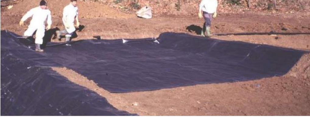
Gráfico N°36. Colocación de geomembrana. Tomado de: Depuración con Humedales Construidos, Guía práctica de diseño, construcción y explotación de sistemas de humedales artificiales, Joan García Serrano, Angélica Corzo Hernández
