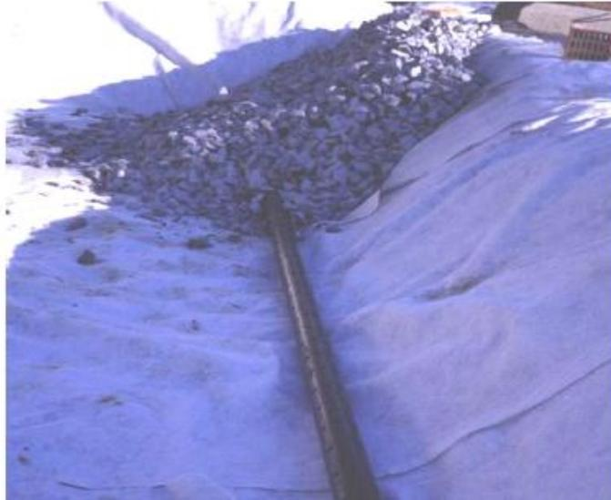
Gráfico N°35. Colocación de tubería de salida de un humedal de flujo subsuperficial horizontal. Tomado de: Depuración con Humedales Construidos, Guía práctica de diseño, construcción y explotación de sistemas de humedales artificiales, Joan García Serrano, Angélica Corzo Hernández
