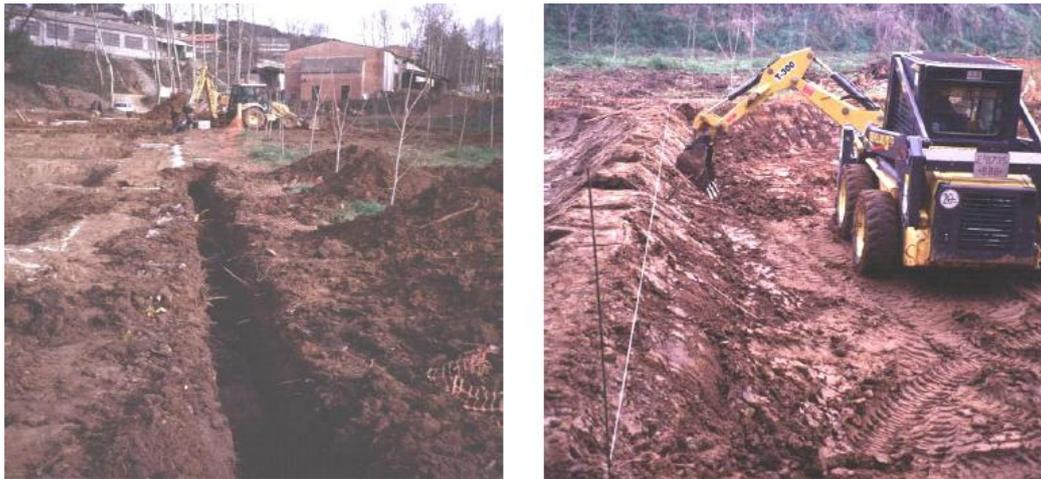
Gráfico N°34. Excavación de una zanja para la colocación de una tubería y excavación y conformación de taludes durante la construcción de un sistema de humedales construidos. Tomado de: Depuración con Humedales Construidos, Guía práctica de diseño, construcción y explotación de sistemas de humedales artificiales, Joan García Serrano, Angélica Corzo Hernández.
