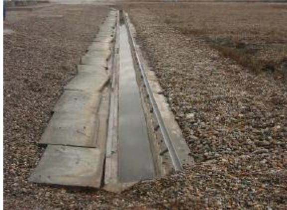
Gráfico N°28. Canal de un vertido en un humedal de flujo horizontal. Tomado de: Depuración con Humedales Construidos, Guía práctica de diseño, construcción y explotación de sistemas de humedales artificiales, Joan García Serrano, Angélica Corzo Hernández.
