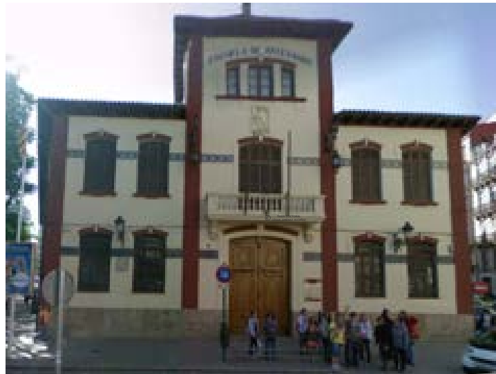
Fig.104. Antigua Escuela de Artesanos de Francisco Mora Berenguer (1925), actualmente Instituto Educación Secundaria Vicente Blasco Ibáñez, en la Avenida Reino de Valencia, 46. Fotografía: Jiménez Alcañiz, C.
