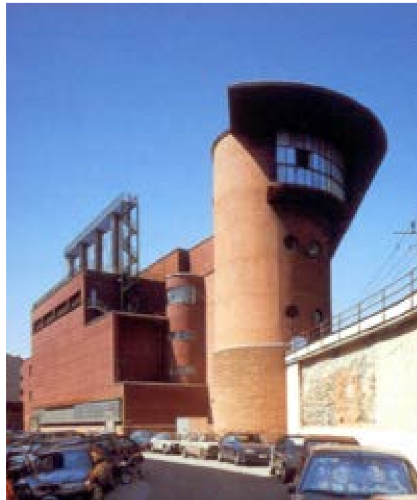
Fig.69. Cabina y central térmica de la Estación de Santa María Novella.
