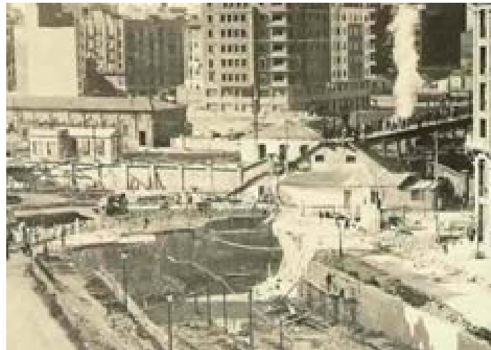
Fig.81. Construcción del túnel de comunicación entre las grandes vías en 1959. Fuente: www.skyscrapercity.com
