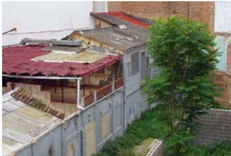
Fig.62. Casa de Poble. Calle Chella 15 y 13 (1850 y 1886) Fotografía: Jiménez Alcañiz, C.
