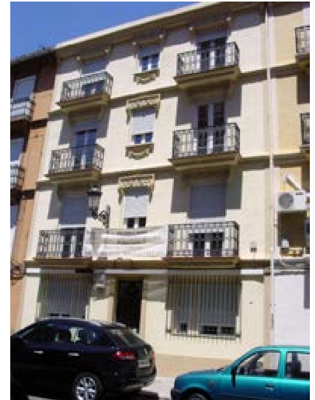
Fig.72. Casa Vecinal PB+III. Calle Denia, 68 (1900) Fotografía: Jiménez Alcañiz, C.
