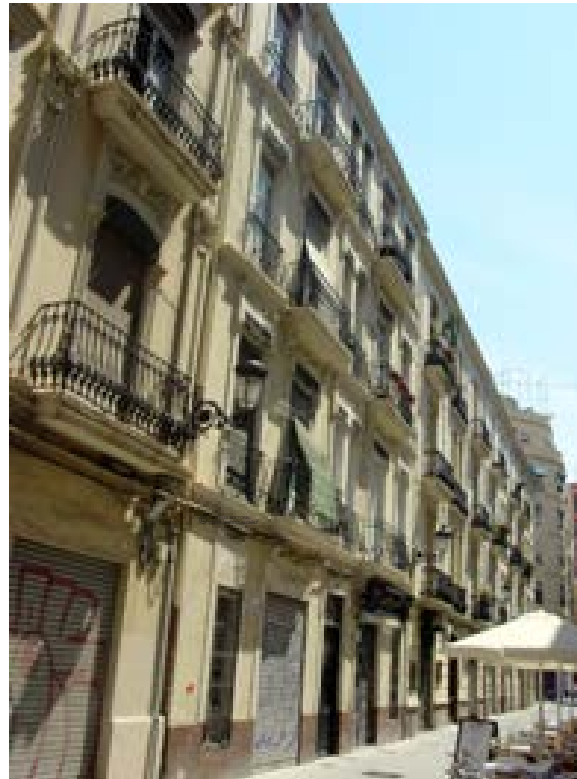
Fig.71. Casa Vecinal PB+III. Calle Cura Femenía, 20 (1907) Fotografía: Jiménez Alcañiz, C.
