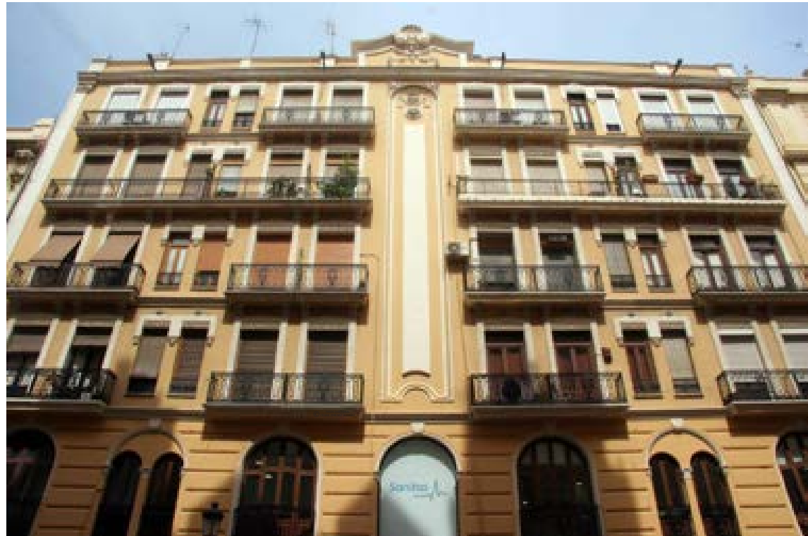
Fig.25. Edificio en la calle Segorbe nº, 6 y 8, una de las pocas parcelas de uso residencial de gran dimensión del Barrio.
