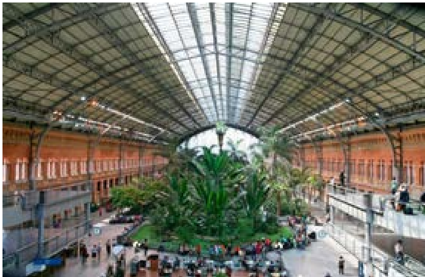
Fig.222. La nueva Estación de Atocha. Fuente: www.adif.es/
