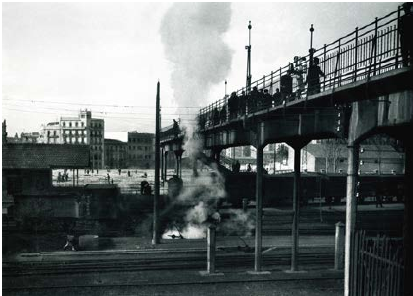
Fig.74. La pasarela que cruzaba las líneas del ferrocarril entre las grandes vías de Ramón y Cajal y Germanías antes de la construcción del túnel. Años 30. Resulta evidente la dificultad de comunicación entre las dos partes del Ensanche. Fuente: "Valencia en blanco y negro", pág. 122.
