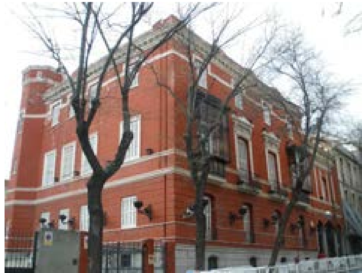
Fig..236. Casa-Palacio de Carlos María de Castro. 1864. Fuente: www.panoramio.com/
