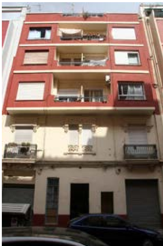
Fig.100. C/ Buenos Aires, 6 (1945) PB+IV Edificio próximo al AE3 Fotografía: Jiménez Alcañiz, C.
