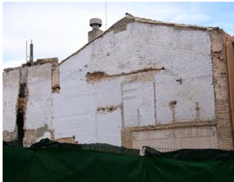
Fig.52,53,54 y 55. Muros de tapia valenciana, en la fachada y en medianeras en Benaguasil Fotografía: Jiménez Alcañíz, César
