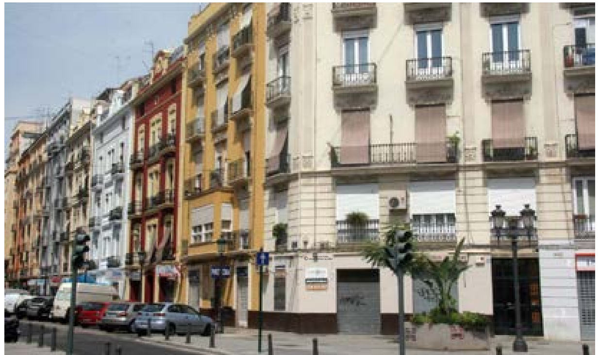
Fig.53. Cruce calle Sueca con calle Puerto Rico Fotografía: Jiménez Alcañiz, C.
