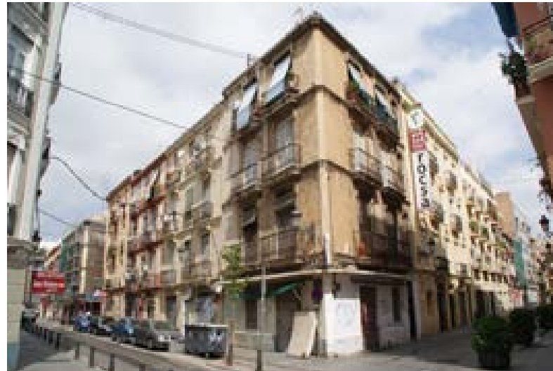
Fig.195,196,197 y 198. Edificios en el barrio de Russafa. Fotografías: Jiménez Alcañíz, César.
