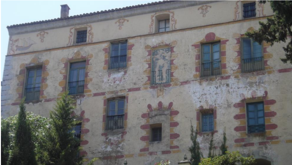
22. Detalle de la fachada principal.
