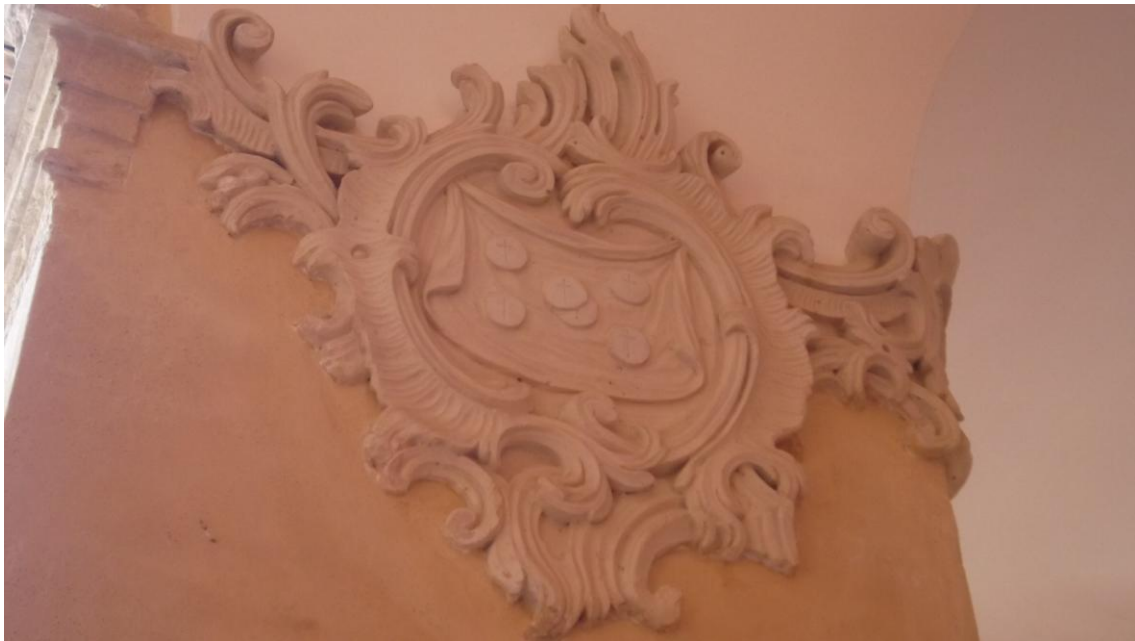
45. Escayola. Muro del Claustro.
