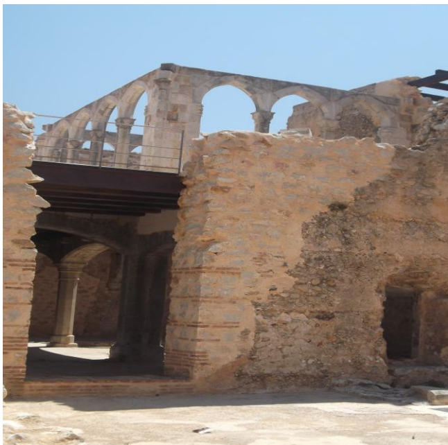
16. Palacio del Abad. Claustro.
