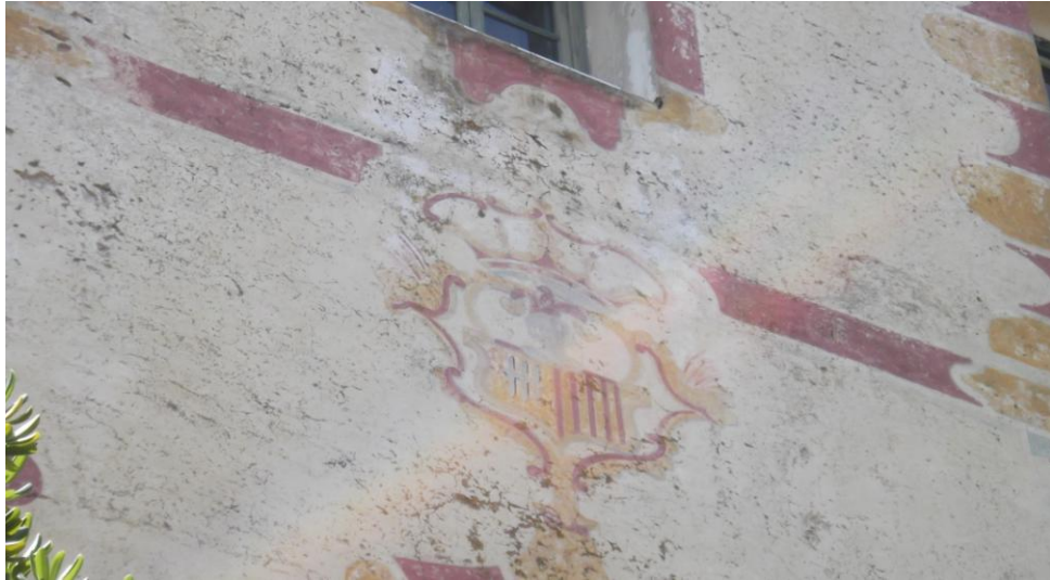
25. Yelmo. Fachada Principal.
