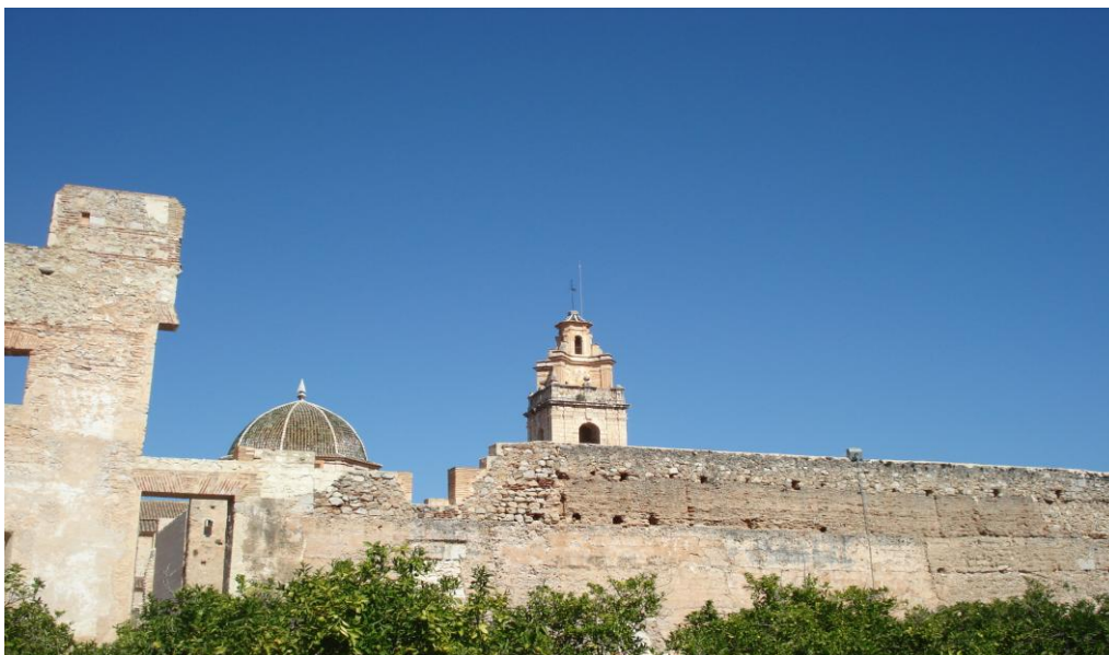
18. Muros exteriores. Santa María de la Valldigna.
