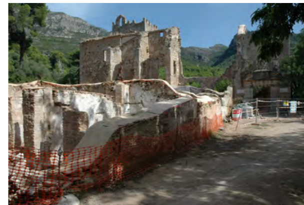
Muros de la zona del claustro
