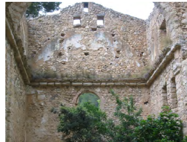
Revestimientos en muros de la iglesia
