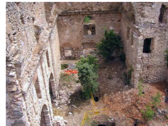
Interior de la iglesia
