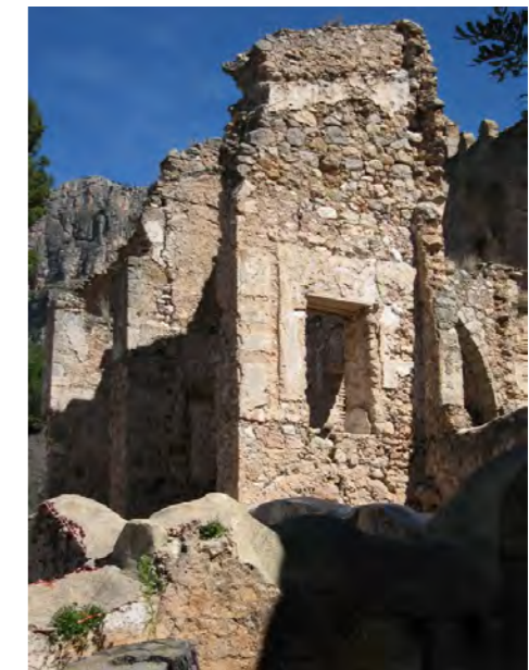
Contrafuertes de la iglesia
