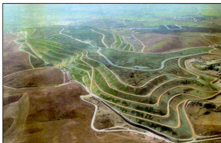
Fig.III-1 Vertedero sellado e hidrosechado.
