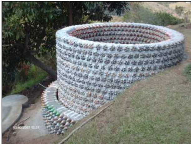
Fig.IV-9 Tanque almacenamiento agua lluvia. Guarme-Antioquía.2007
