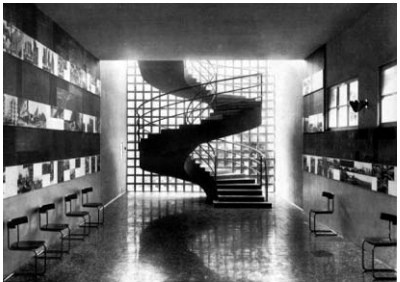
5.48 | Interno del padiglione aggiunto della Triennale di Milano, 1936.
