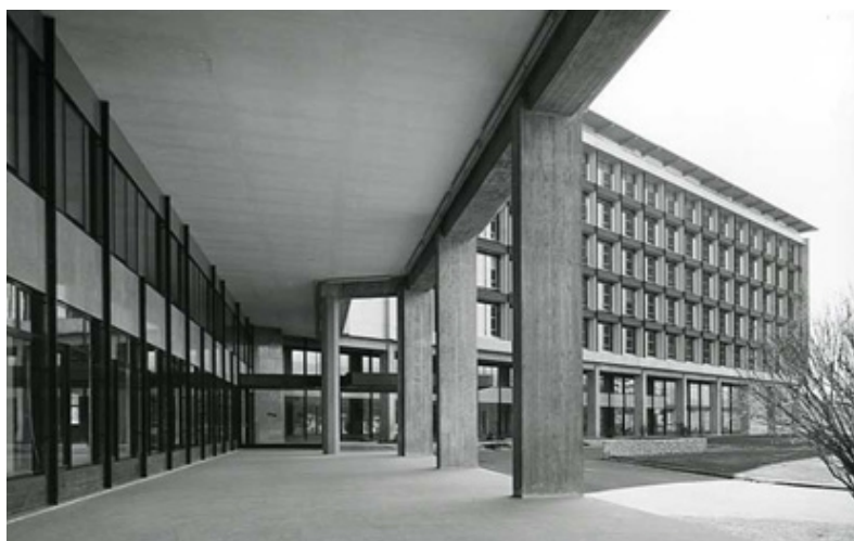
6.15 | Il palazzo presenta sette piani fuori terra più un piano di dimensioni ridotte, simile a un super-attico.
