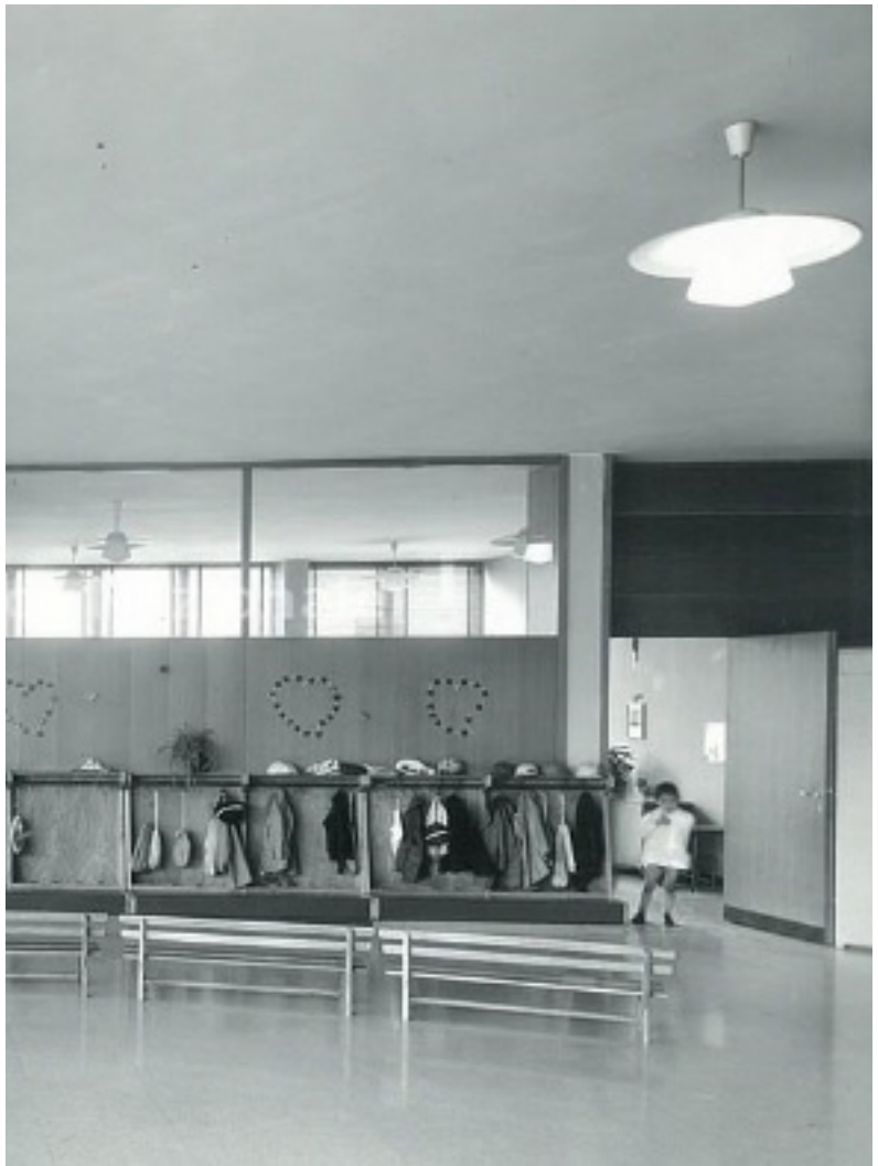
5.143 | Quartiere Feltre a Milano, interno della scuola elementare, 1961.
