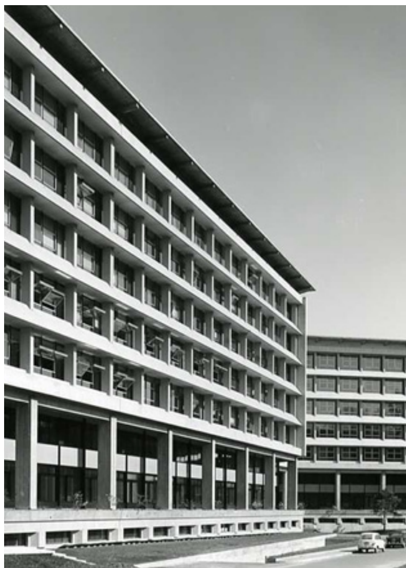
6.13 | La facciata, regolare ed armoniosa, è alleggerita dall'ampia vetratura con finestre a nastro, con studio particolare alle condizioni di soleggiamento.
