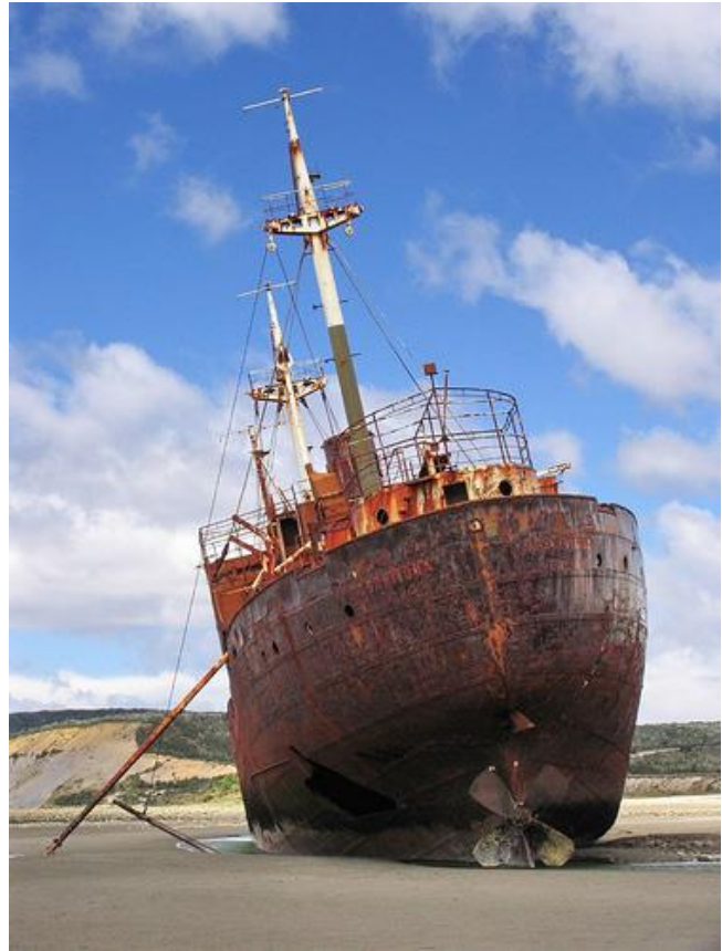
Foto 13: Barco comido por la corrosión.
