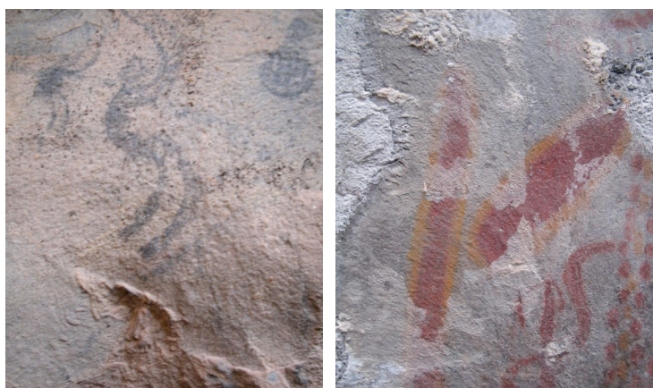
Figura 67 - Pátina sobre la pared rocosa y eflorescencias salinas sobre las pinturas.
