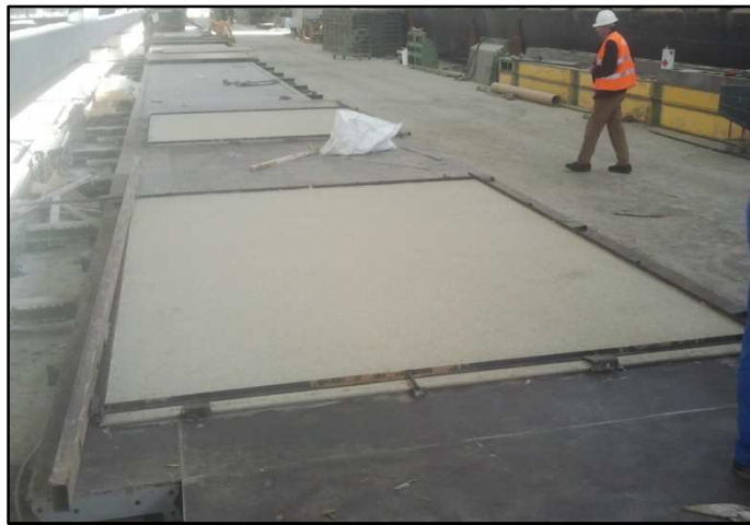
Figura 40. Preparación de moldes para hormigonado de losas
