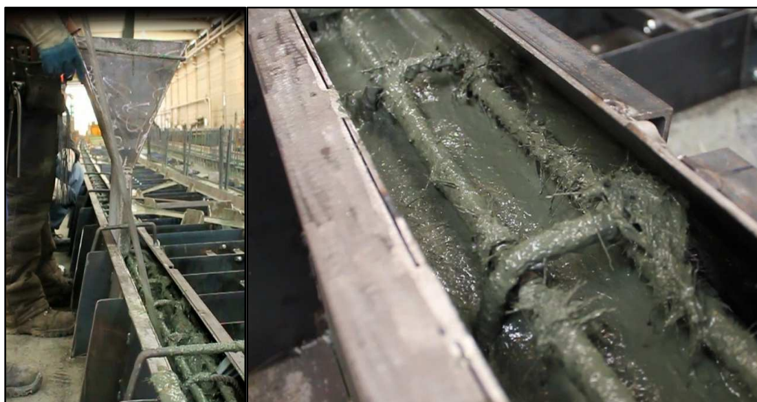
Figura 44. Hormigonado con embudo: Picado con barra y fibra en armadura
