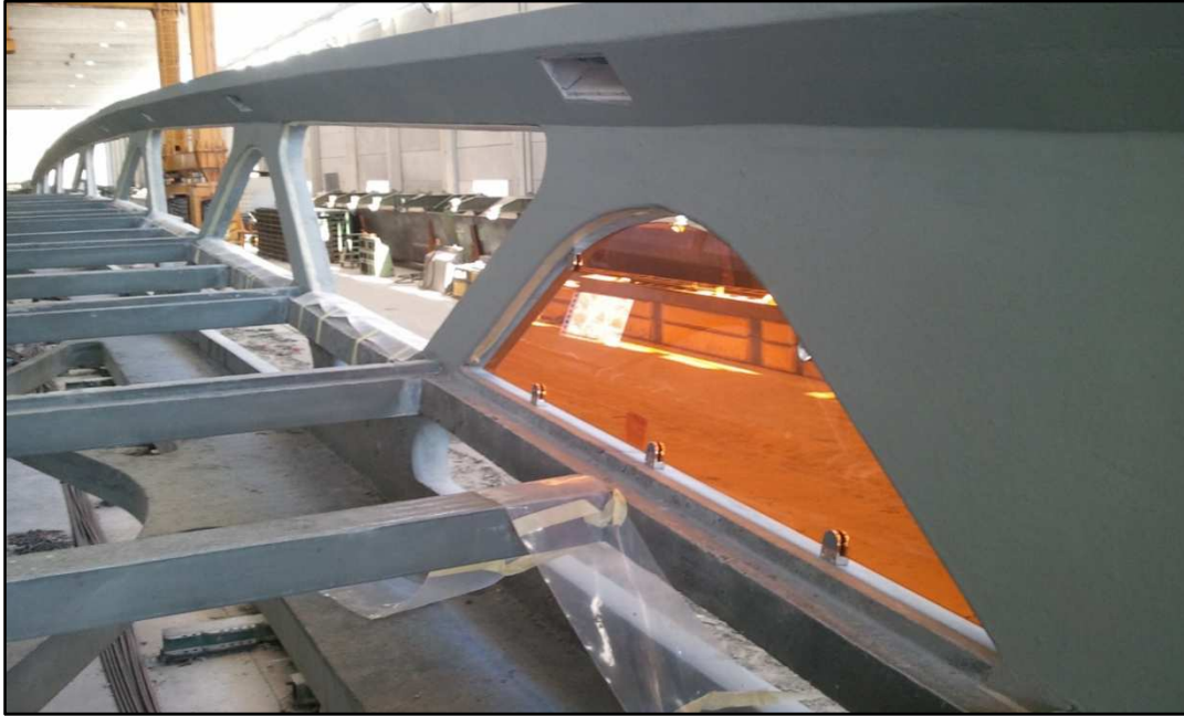
Figura 58. Prueba de herrajes y vidrio. Cajeado para iluminación en cordón
