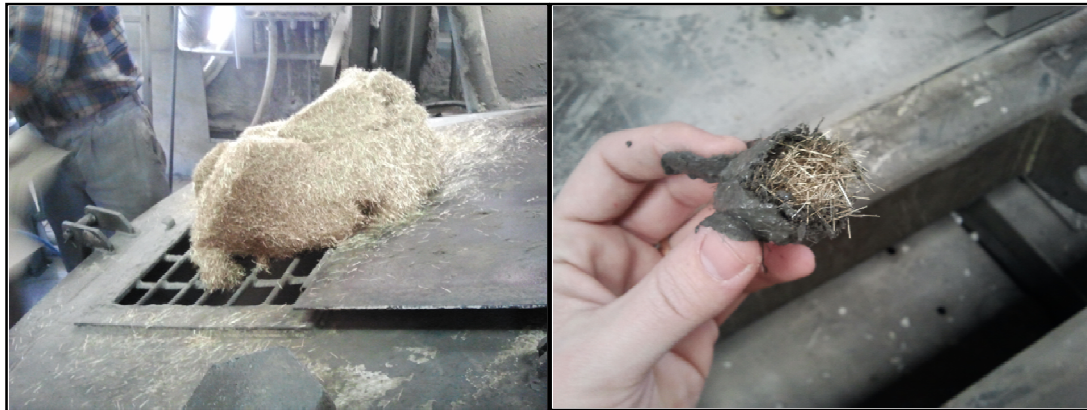
Figura 22. Adición de fibra fina en bloque y “erizos” aparecidos en la puesta en obra
