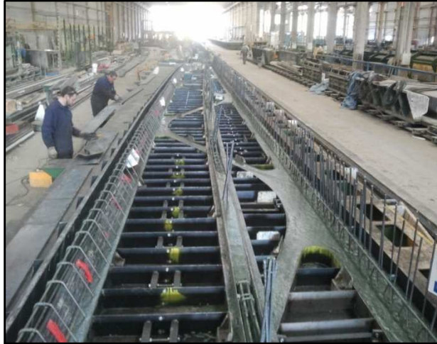
Figura 28. Molde hormigonado correspondiente a medio lateral
