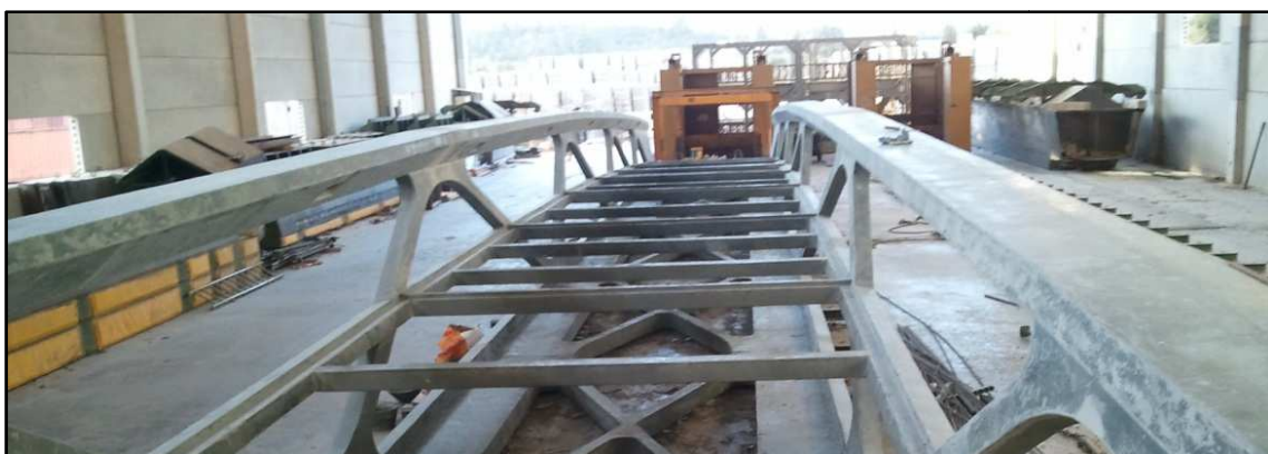
Figura 39. Aspecto de las riostras y cajado del cordón superior hormigonados
