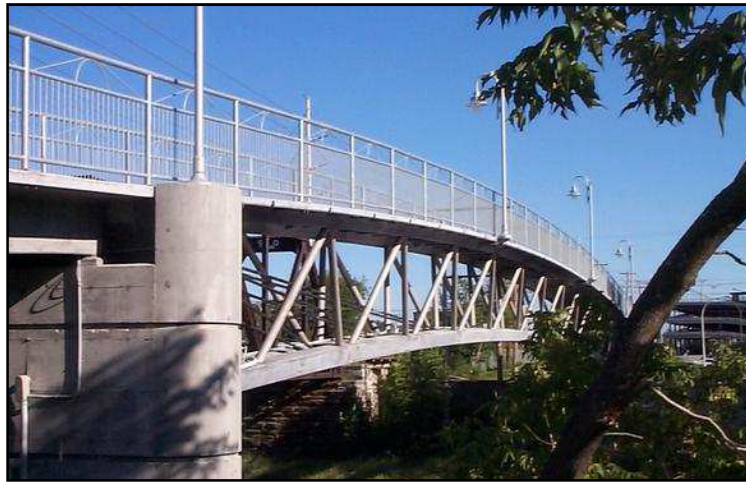
Figura 1. Pasarela en Sherbrooke, Canada. 1997
