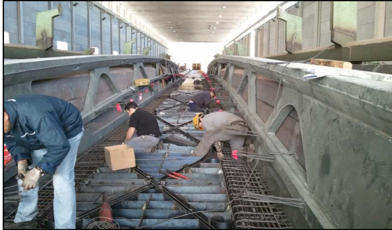
Figura 37. Preparación de armados en fondo (cercos de rasante)
