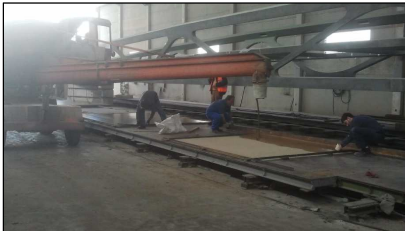
Figura 41. Hormigonado de losa en zig-zag con speedy
