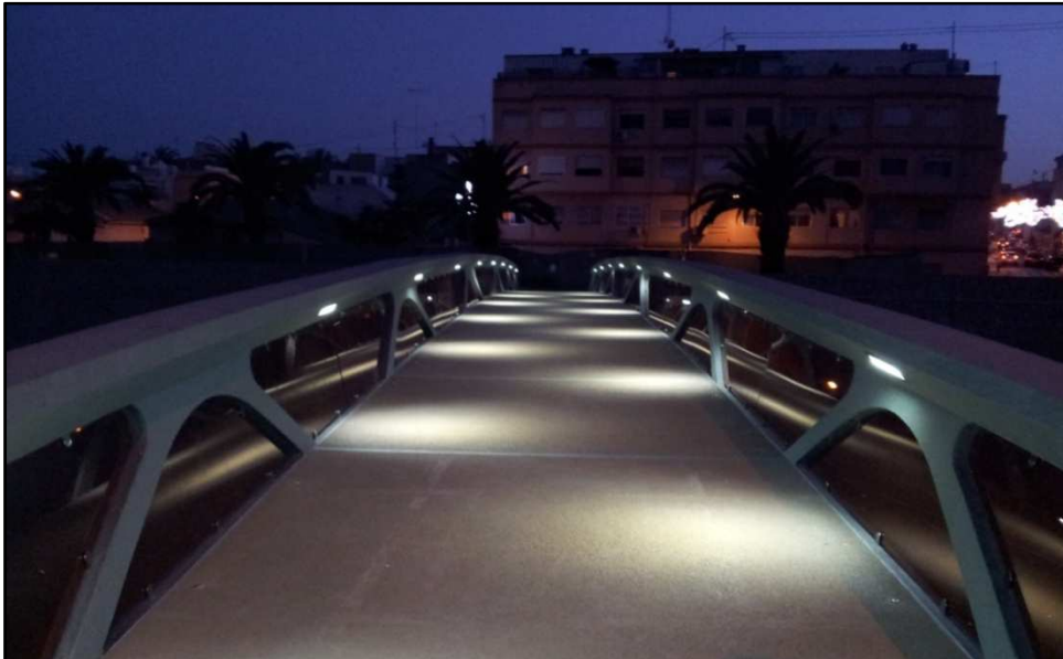
Figura 57. Pasarela iluminada mediante leds encastrados en el cordón superior
