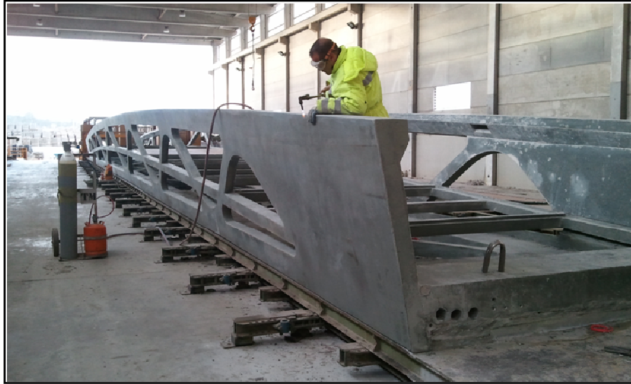
Figura 56. Operario pasando soplete para eliminación de fibras en esquinas
