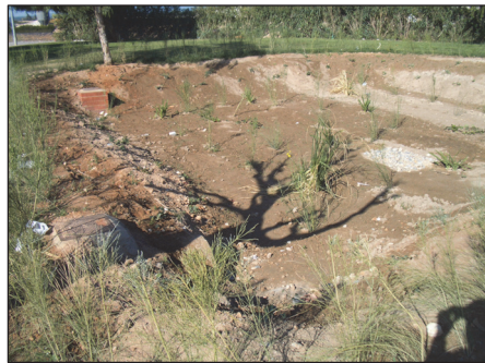
Figura 1. Infraestructuras de demostración en Benaguasil. Pavimento permeable (izquierda) y balsa de infiltración (derecha)
