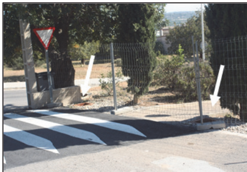
Figura 1. Zona de entrada de escorrentías al Parque Costera de L'Ermita en Benaguasil. Se señalan las arquetas para toma de muestra fija de esta agua
