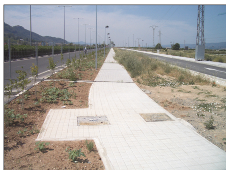
Figura 2. Infraestructuras de demostración en Xàtiva. Cubierta donde se implantará la cubierta verde (izquierda) y cuneta vegetada en ejecución (derecha)
