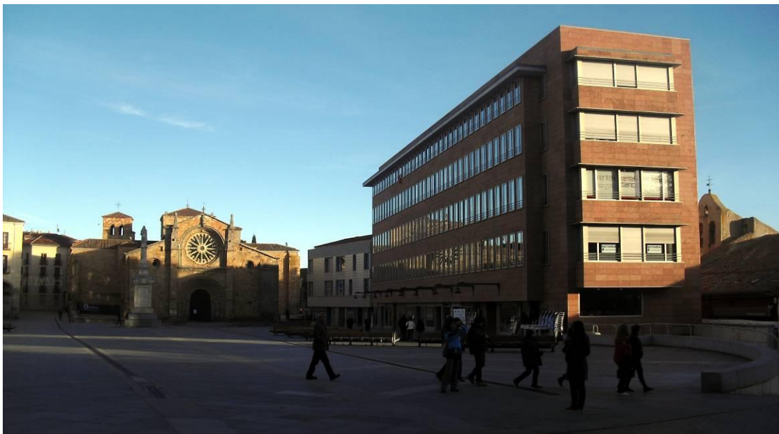
Figura 18: Vista de la Plaza de Santa Teresa desde la Puerta del Alcázar en la Muralla. En el flanco sur de la plaza (derecha) el edificio nuevo de la polémica intervención. (Autor 8/12/2013)
