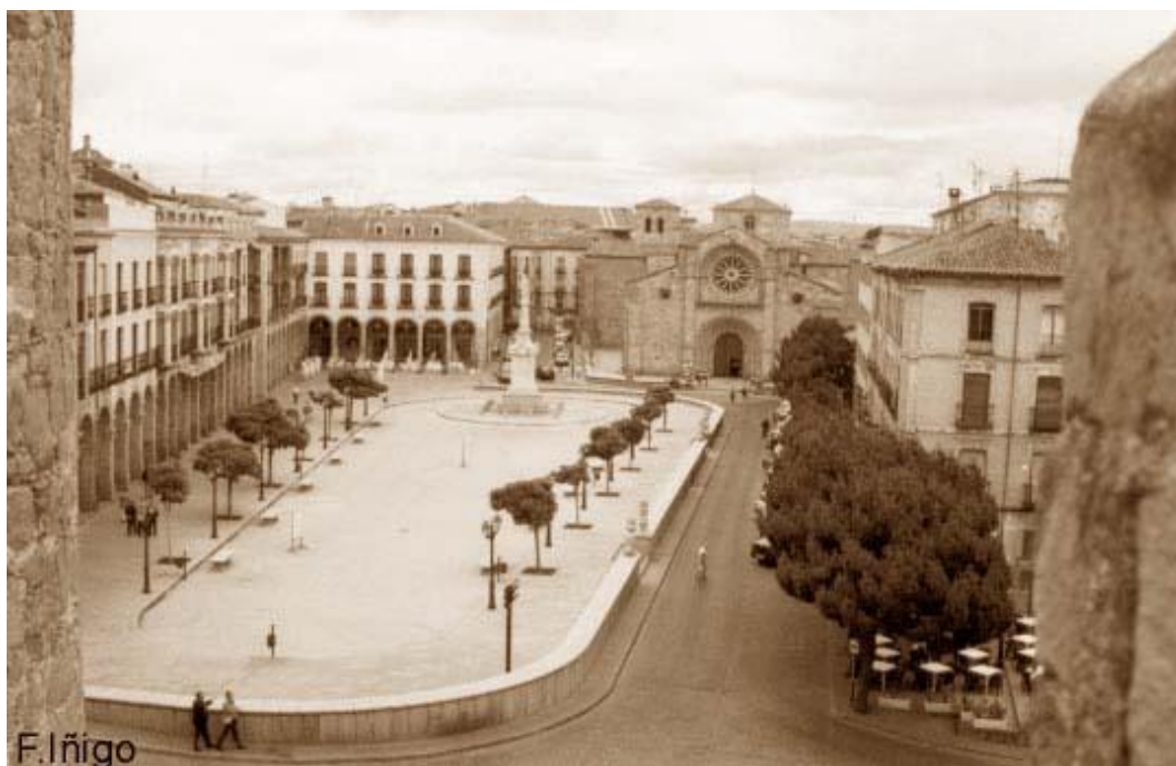
Figura 13: Vista de la plaza de Santa Teresa (coloquialmente, plaza del Mercado Grande) desde la Puerta de Alcázar de la muralla de la ciudad. Estado previo a la intervención. ( http://www.pueblosespana.org/castilla+y+leon/avila/avila/100440/ , 30/4/2013)
