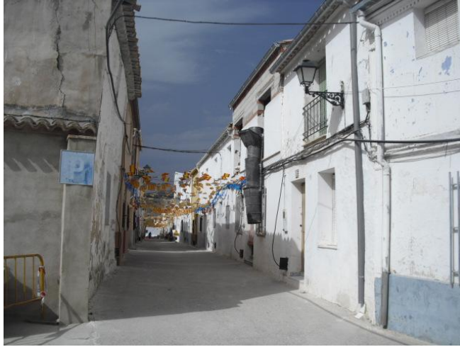
Figura 219: Obra de sustitución de cubierta con sobreelevación de la altura de cornisa
