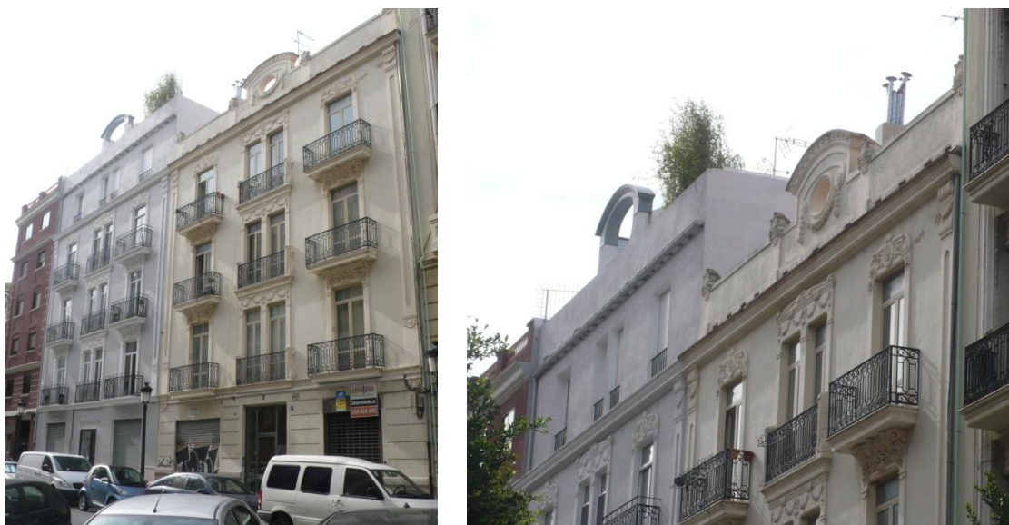
Figura 108: Frente de fachada de los edificios situados en los números 20 y 22 de la Calle Sueca, donde se lleva a cabo la sobre elevación de la última planta sobre la misma línea de fachada, sin acometer el retanqueo que permitiría apreciar la fachada del edificio en su estado original.
