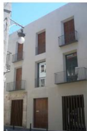
Figura 125: Ficha BC-PA 5434510 correspondiente al edificio en la Calle Museo 13ac, Plaza Borrego i Galindo, 7. Apartados sobre datos identificativos, descripción, destino y usos, estado de conservación y protección.
