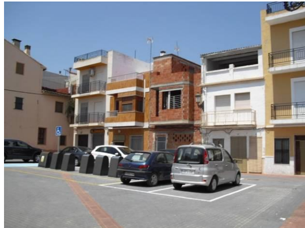
Figura 208: Conjunto de inmuebles del Carrer Sant Roc
