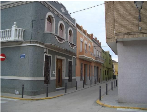
Figura 203: Acabados de fachada de revestimiento monocapa oscuros y ladrillo visto.
