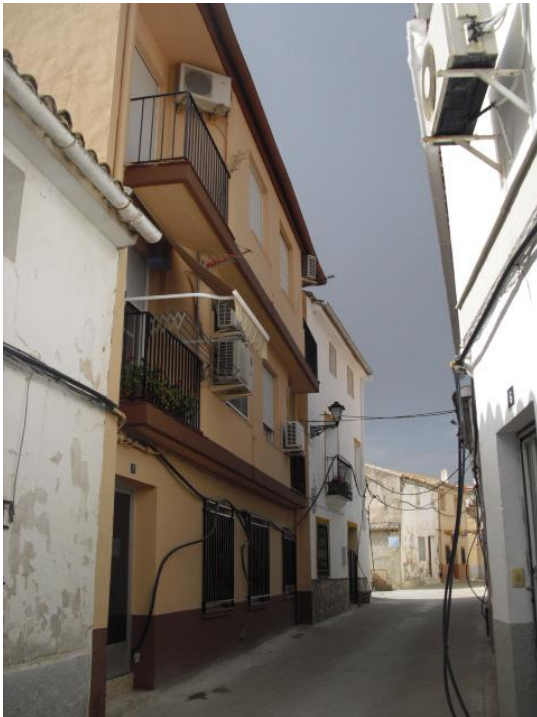
Figura 215: Fenómeno de sustitución donde no se cumple la adaptación a la altura, a los balcones característicos y a los materiales y colores de fachada en el casco antiguo, así como la prohibición de colocación de instalaciones en el plano de fachada.
