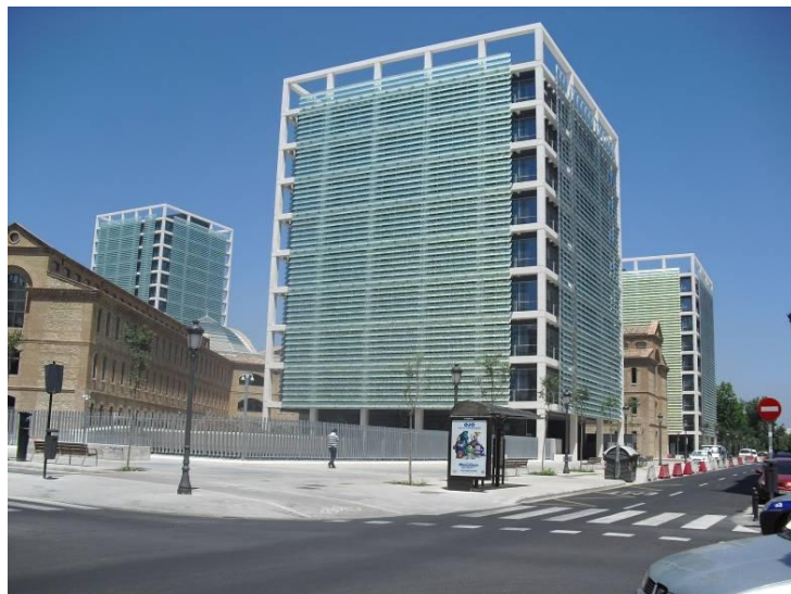
Figura 73: El impacto visual y paisajístico sobre el edificio protegido de la cárcel es evidente, no sólo por la intervención en búsqueda de contraste de las nuevas edificaciones, sino por la elevada edificabilidad permitida sobre un solar sobre el que debió extenderse la protección que le otorgaba el catálogo, conforme a las normas 3.69 y 3.70 del propio Plan General de Valencia. (Autor, 1/7/2013)
