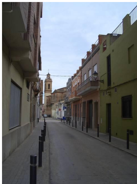
Figura 200: Fenómenos de sustitución con alturas superiores a la ordenanza.
