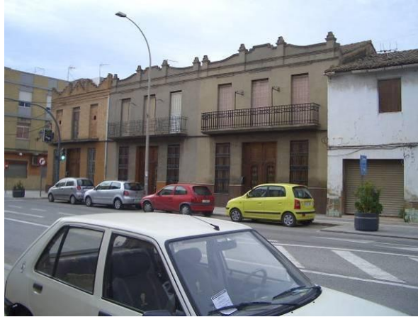
Figura 198: Conjunto de tres casas tradicionales en la carretera de Valencia
