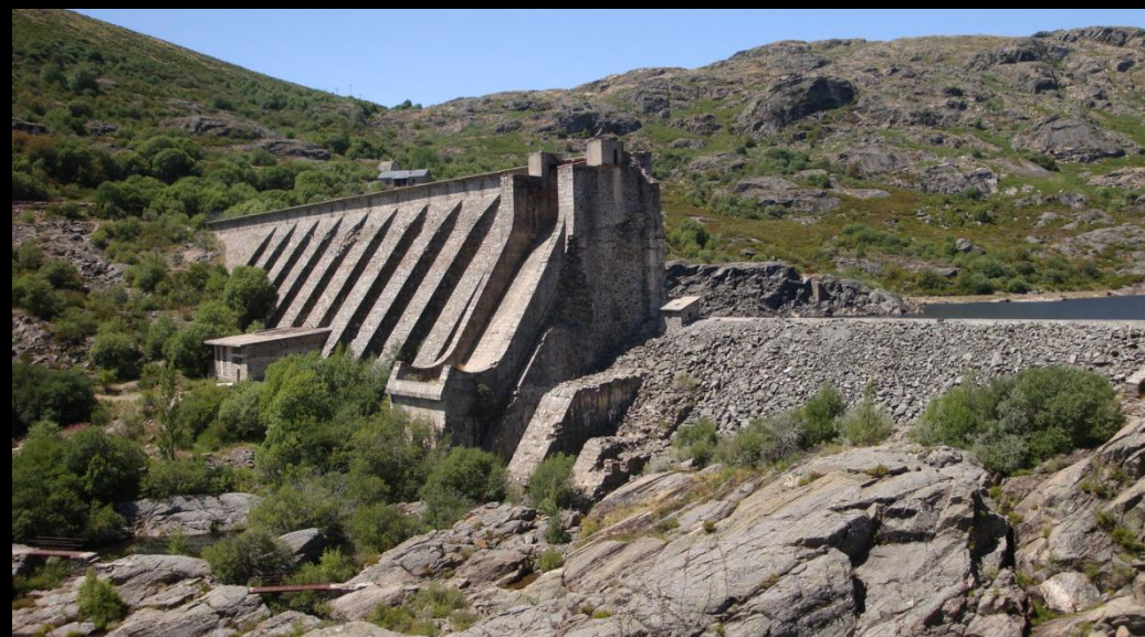
Presa Vega de Tera, o de Ribadelago entre neises del Precámbrico. Galende, Zamora. SW Hoja de La Baña. Cerrada de la presa, rota. (por José Ignacio Terán/nebusin-Google)
