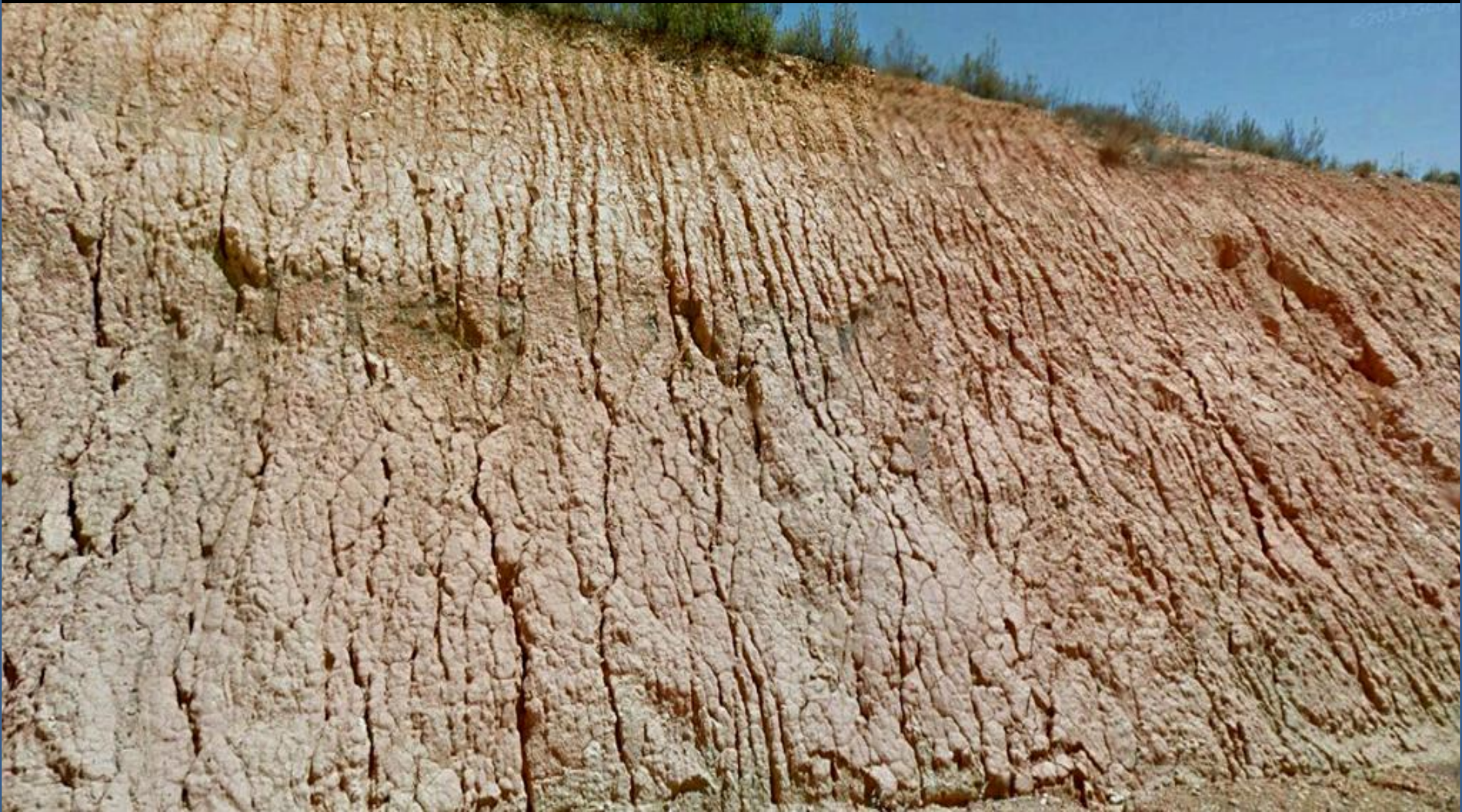
Inestabilidad en talud de coluvión. Cuaternario. NW de Villageriz, Zamora. N Centro Hoja de Arrabalde.
