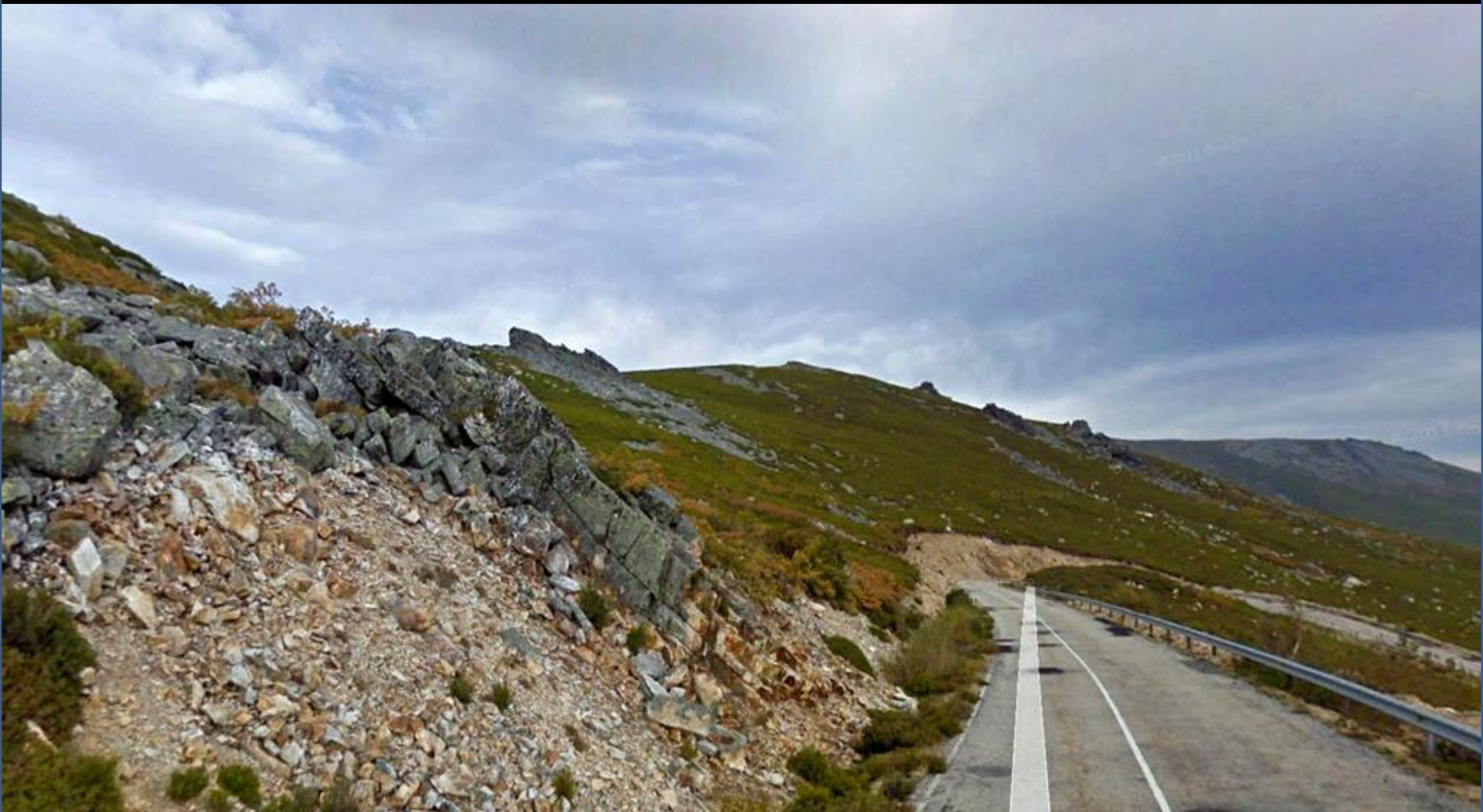
Junto a anterior. Cuarcitas, tectonizadas, del Ordovícico Inf., al N de Escuredo, conformando taludes metaestables. S del Alto del Peñón. SE Hoja de La Baña.
