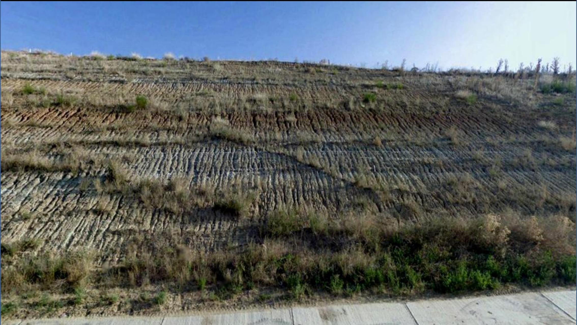
Talud de detríticos del Eoceno, Terciario, erosionándose, en la A11. SE de Algodre, Zamora. SE Hoja de Coreses.
