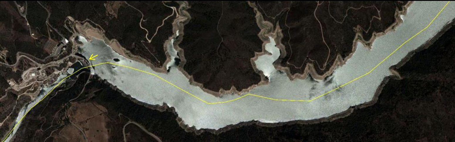
Detalle de anterior: Cerrada del Embalse de Bemposta. Lado portugués y detalle de planta. Paraneises. Al SW de Fermoselle, Zamora. (por Pedro I-Google)
