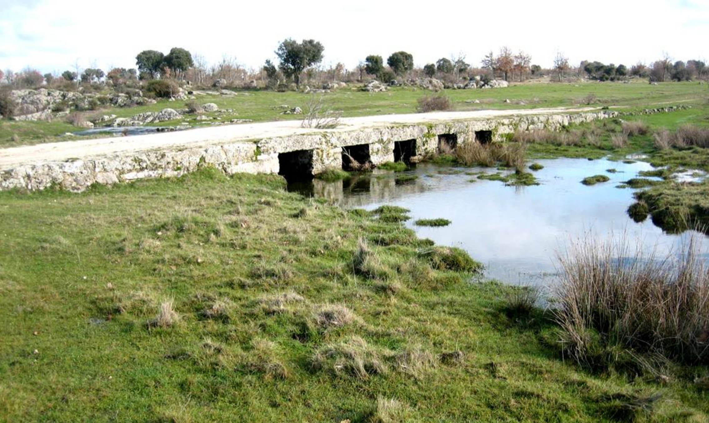
Puente del camino Bermillo sobre arroyo de la ribera, S de Villamor de La Ladre, Bermillo de Sayago, Zamora. Zona de granitos. SW Hoja de Pereruela. (por jinkli-google)
