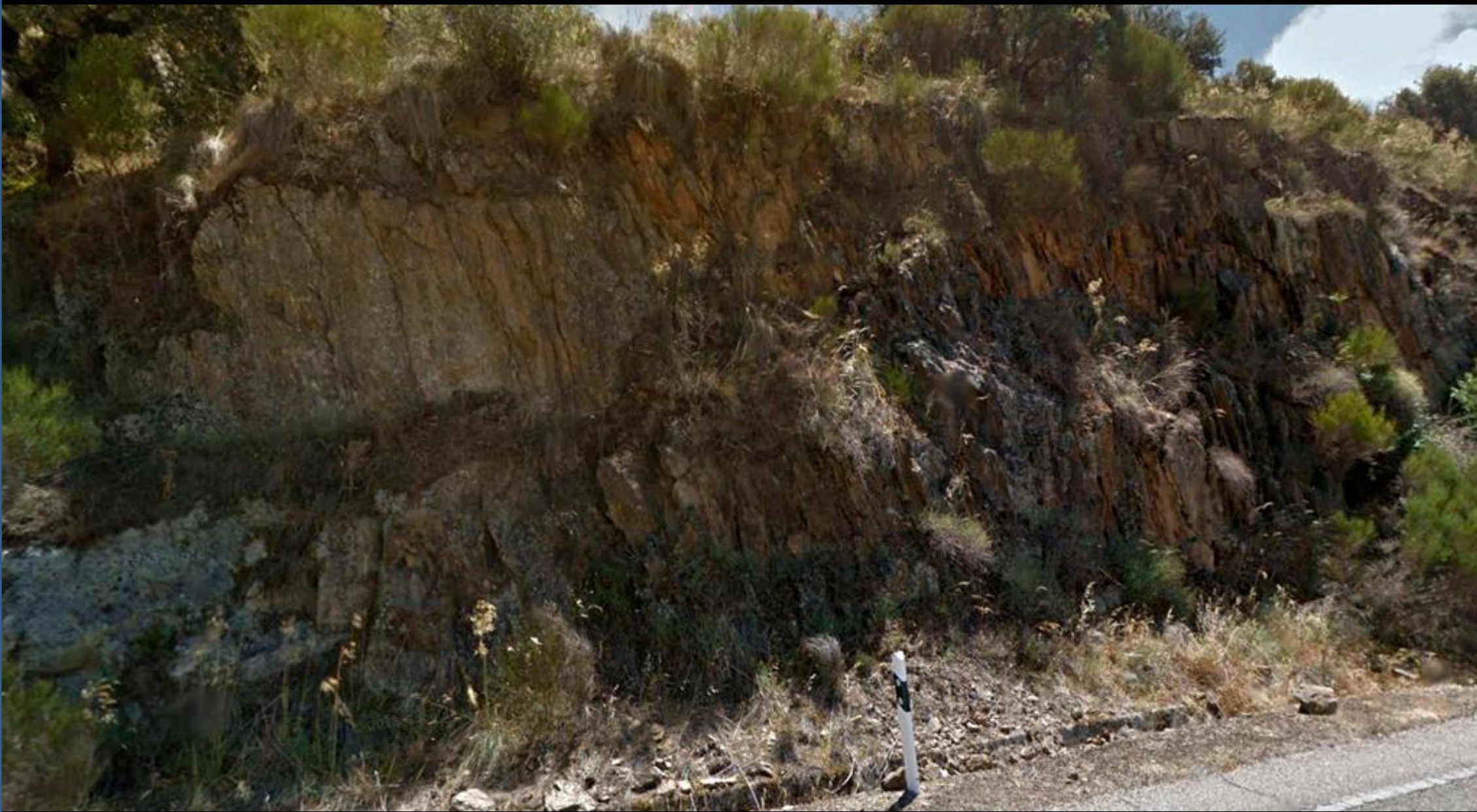
Cerca de anterior: Zona de esquistos y neises migmatíticos del Precámbrico-Cámbrico. Al SE del estribo izq., Presa Miranda de Duero. Portugal- Zamora. NE Hoja de Muga de Sayago.
