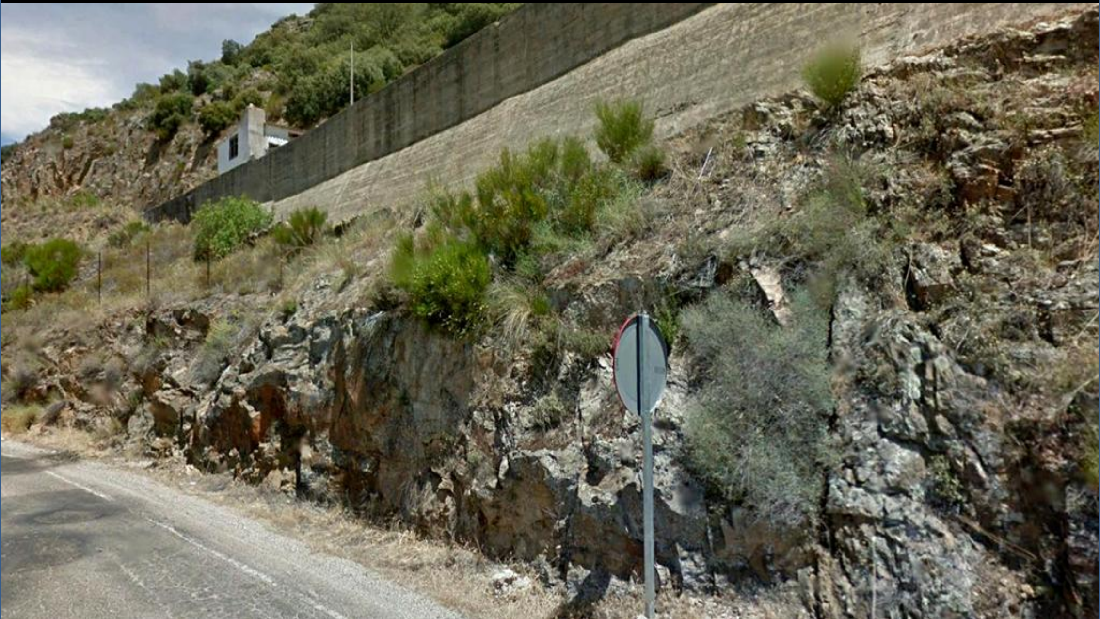
Zona de esquistos y neises migmatíticos del Precámbrico-Cámbrico. En estribo izq., Presa Miranda de Duero. Portugal- Zamora. NE Hoja de Muga de Sayago.
