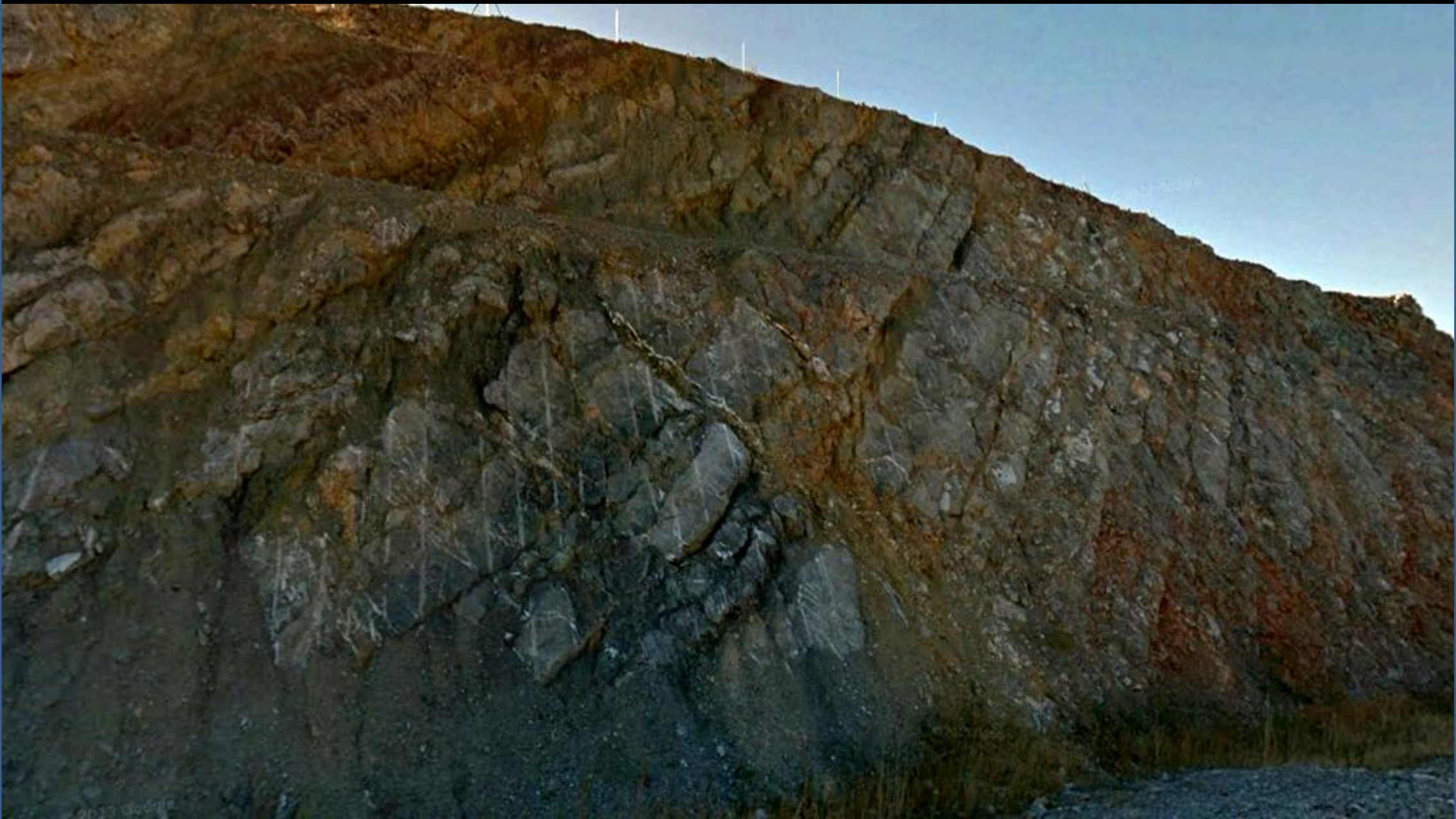
En talud anterior: Calizas del Jurásico?, falladas. S de La Cabria. Palencia. NE Hoja de Prádanos de Ojeda.
