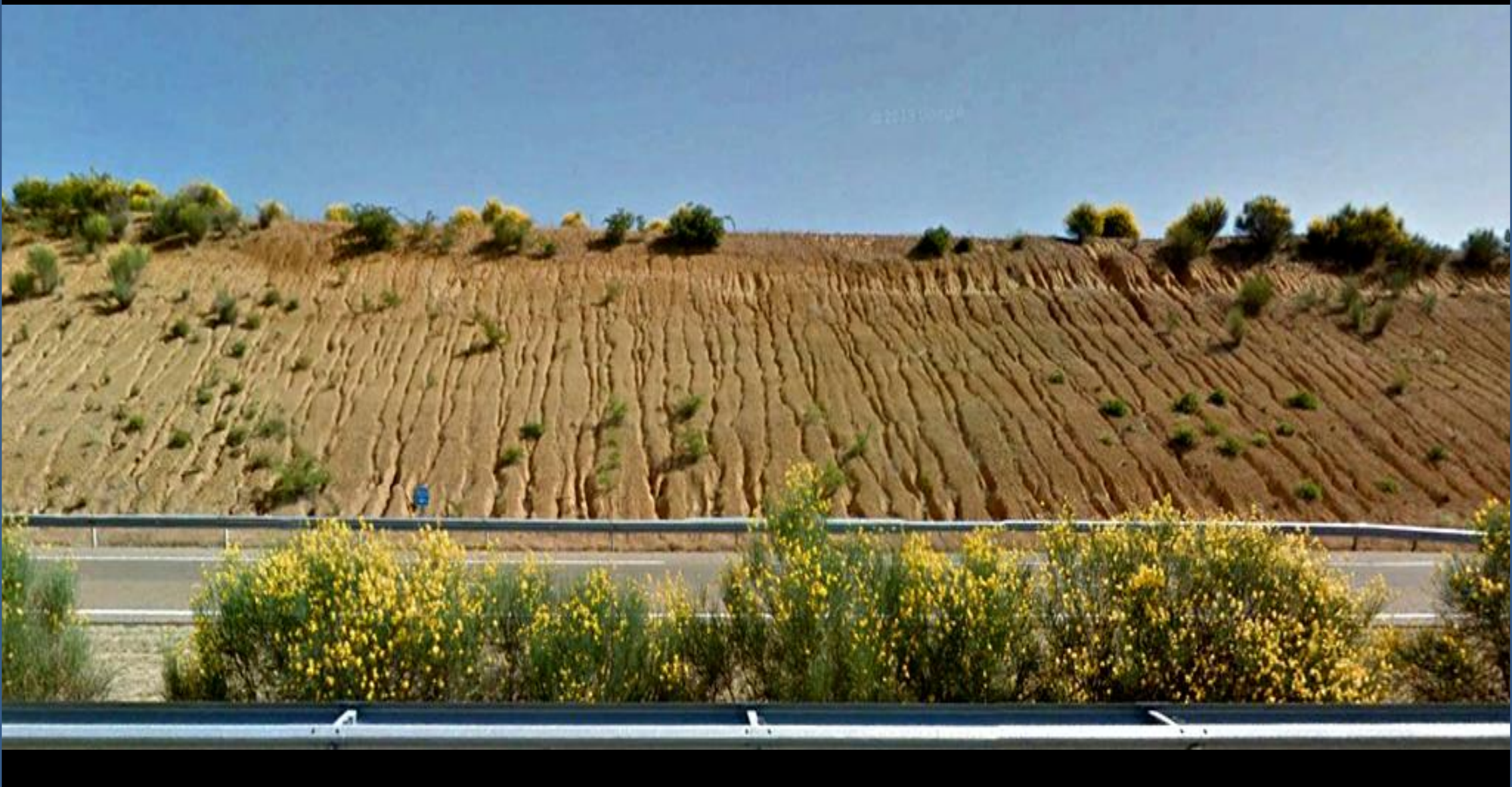
Por la Autovía Camino de Santiago. Talud acaravado en arenas y limos del Aragoniense, Mioceno, Terciario. ? N de Ledigos, Palencia. SE Hoja de Sahagún.
